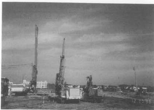
写真-10 高圧噴射式地山改良機 (SM 405) と多機能油圧削孔機 (SM 400, SM 103)
