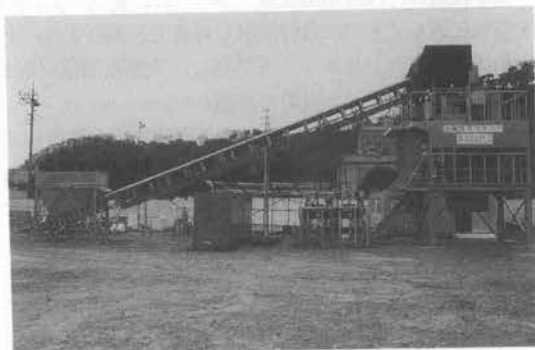
写真-8 汚染土壌処理プラント
