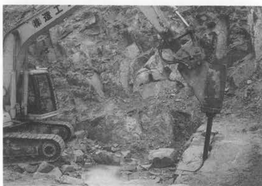
写真—18 施工状況（ベンチカット）
