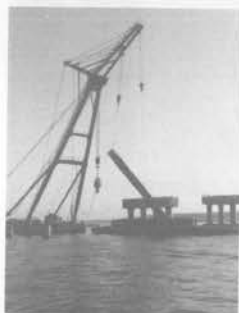
杭切断後の撤去
