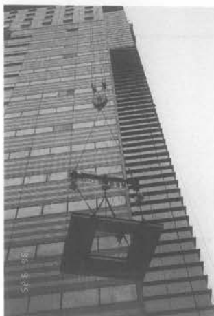
写真-1 揚重状況
