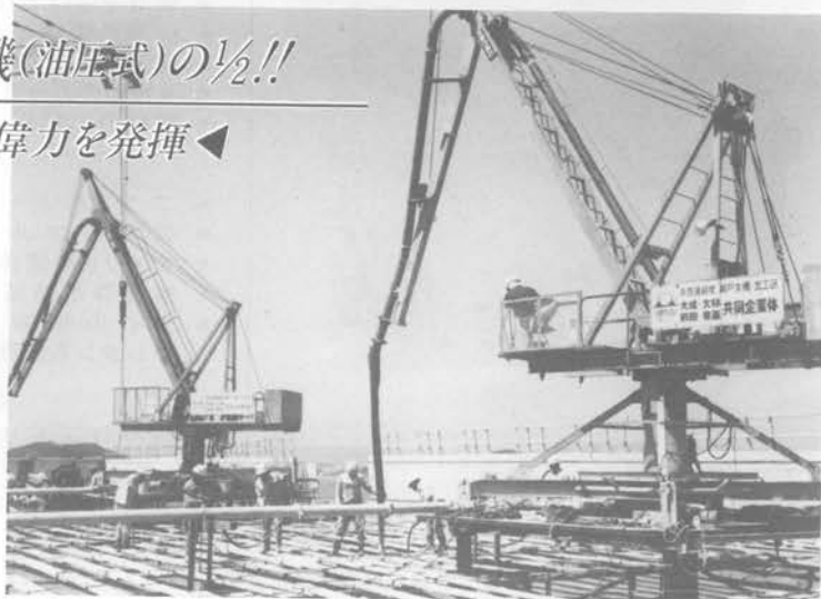
(本四架橋現場設置例)
