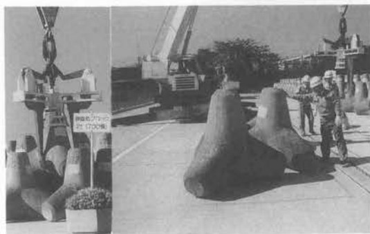
写真—1 スtockヤードからの積込み作業
