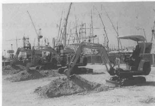
写真-5 屋外のデモンストレーション広場
