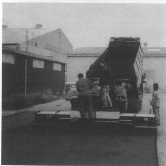
写真-3 アスファルトフィニッシャのテスト風景
