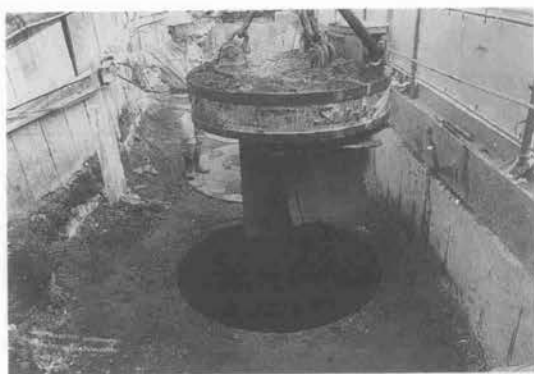
写真-3 切断片の搬出状況
