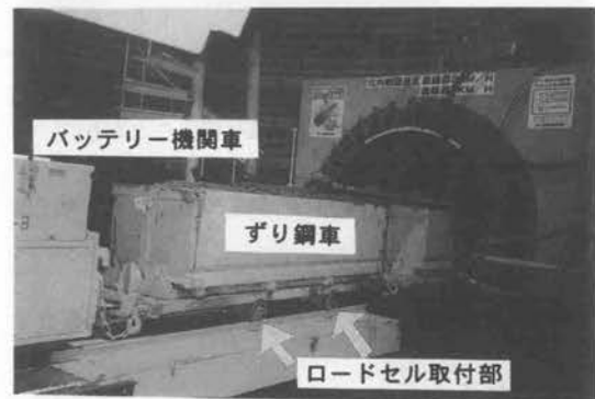
写真-17 現場での使用状況
