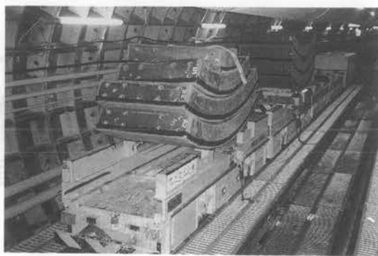
写真-1 セグメントの移載状況
