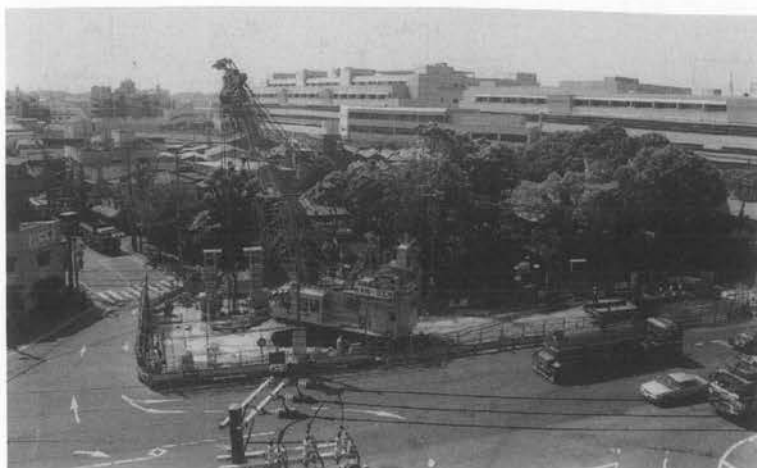
写真-5 現場全景
