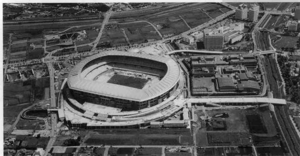
↑外周通路P C建方（平成9年5月）
