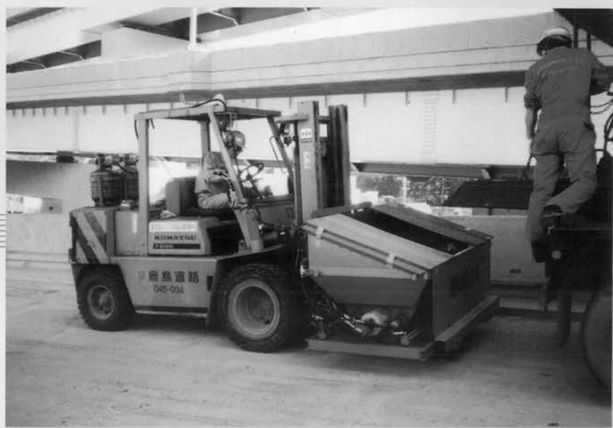
⇓ グース舗装端部注入機
