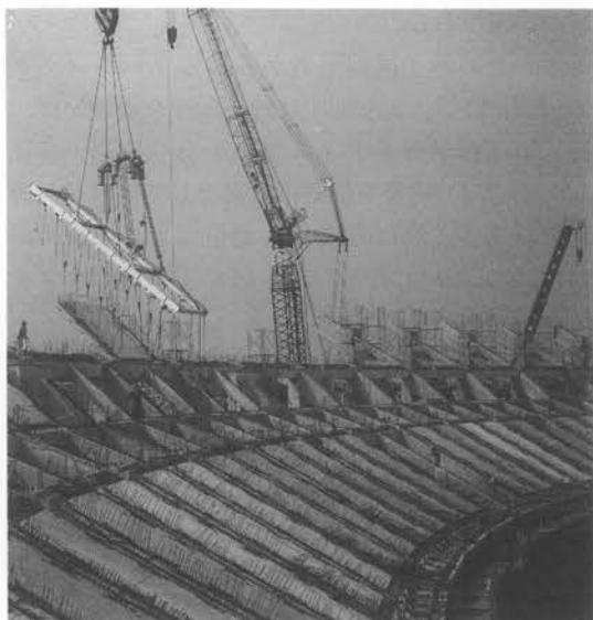
写真-1 斜めスラブユニット取付状況
