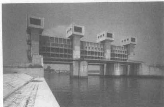
写真-2 岩湫水門(東京都)ローラゲート
