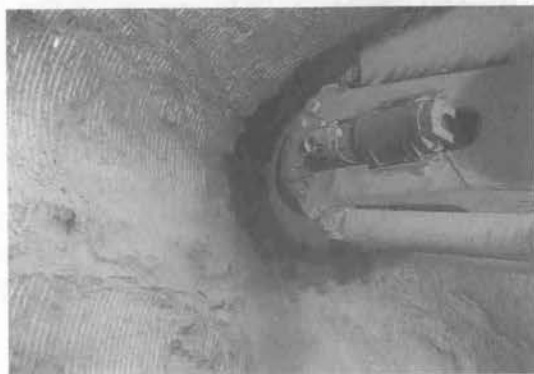
写真-2 掘削状況
