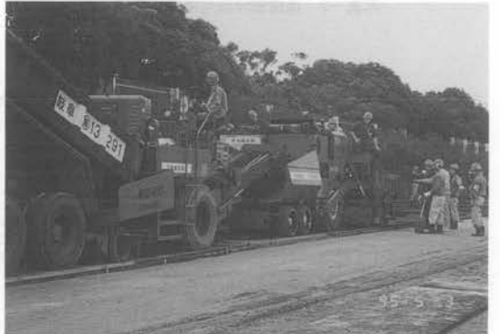
写真-9 材料供給機
