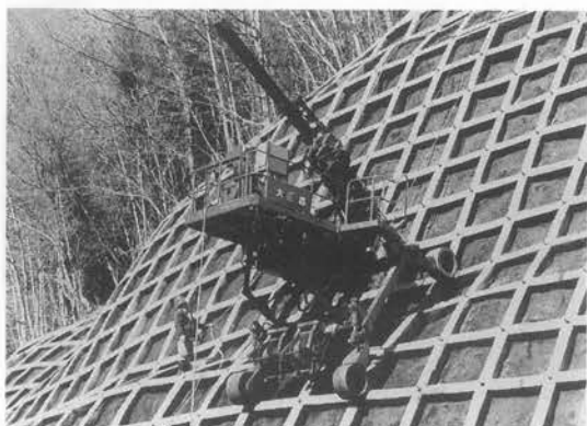
写真—47 無足場削孔機（アンカロックマシーン）
