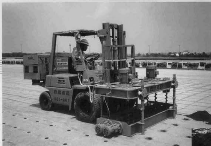
↑馬場排水削孔用多孔ボーリングマシン
