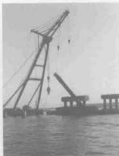
杭切断後の撤去
