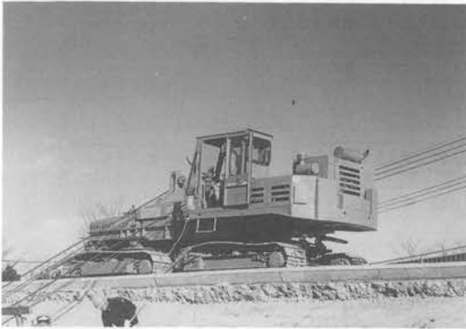
写真-4 斜面施工機サポート用クローラアンカ
