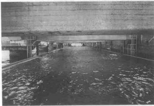
写真-2 吊下げ式レール架設状況
