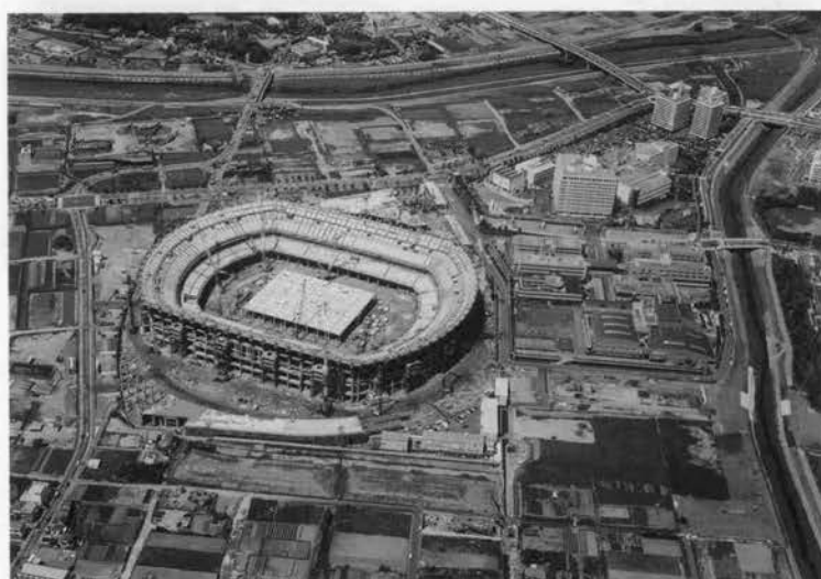
↑スタンド部P C建方終了（平成8年5月）
