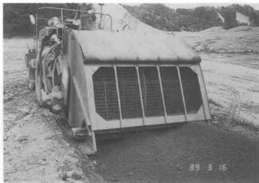
写真一 粒度改良用クラッシングセパレータ
