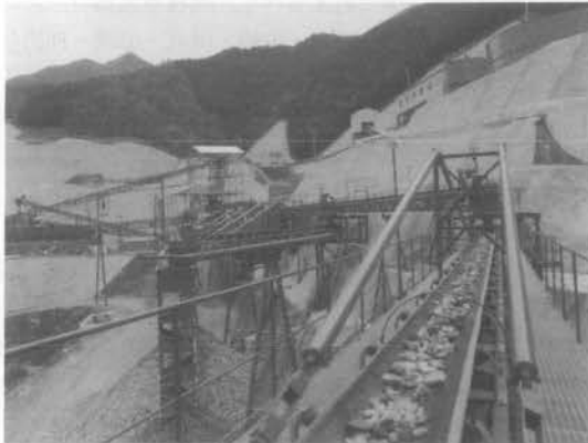
写真-4 あらゆる廃棄物の破碎・選別が可能な粗大ごみ破碎施設
