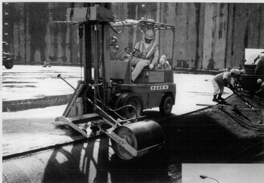
↑ V型側溝転圧装置
