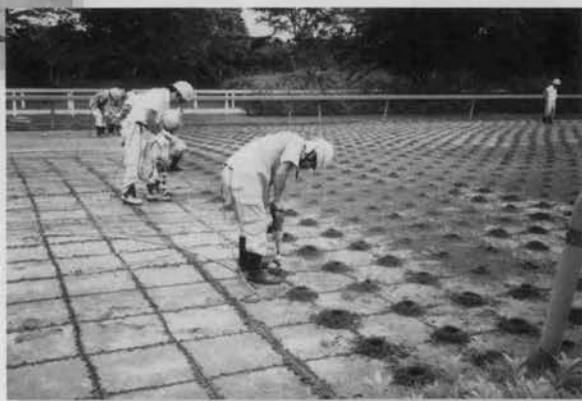
↑削孔作業改善前の人力施工
