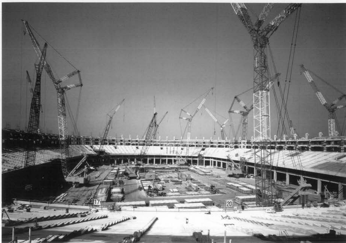
⇩ スタンド部P C建方状況
