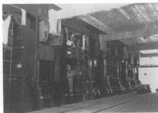
写真-31 建物押し上げ状況
