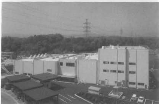
写真-5 経済性、操作性共に優れた骨材プラント
