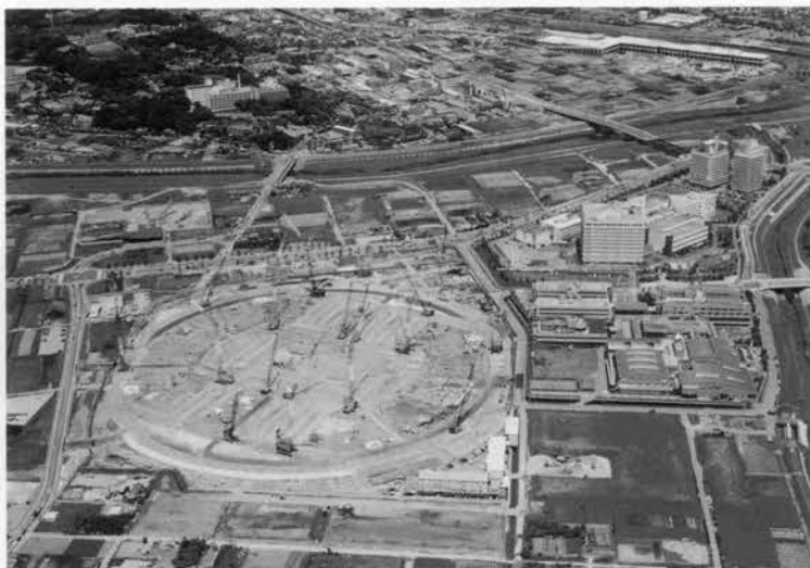
↑重機配置完了（平成7年5月）
