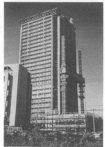
屋根架構解体、逆クライミング
