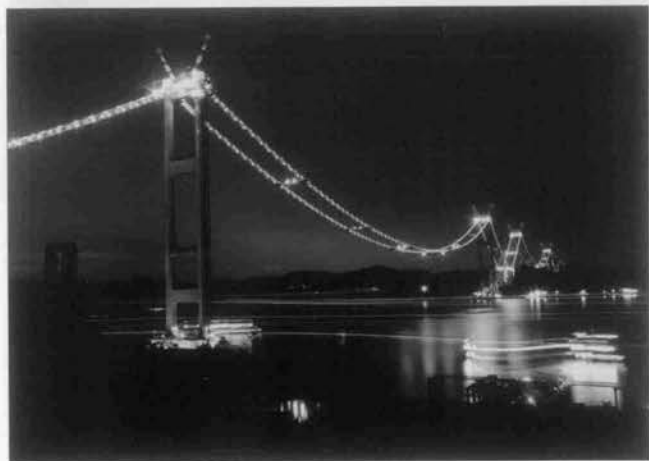
⇩来島第三大橋（手前）の夜景 主ケーブルのサブ調整作業のため、キャットウォーク上で照明を行なっている。今治市系山より望む。
