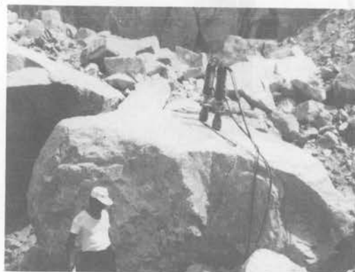
災害復旧での巨石処理
