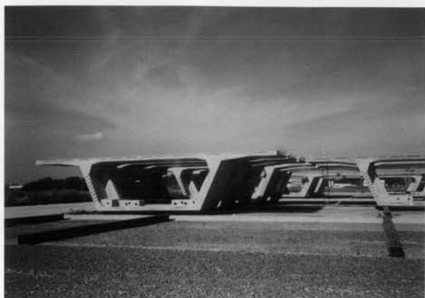
⇐ 弥富高架橋 本線部標準セグメント ストック状況
