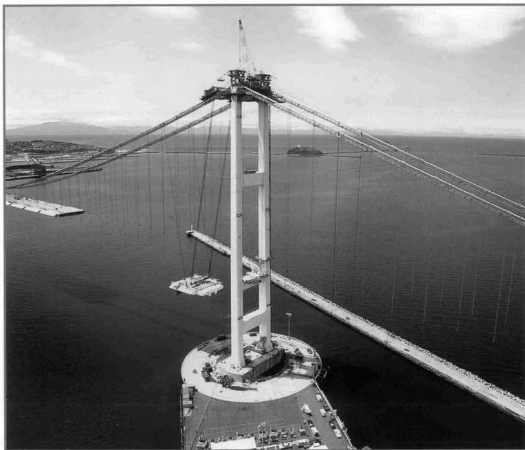
白鳥大橋補剛桁架設工事 三菱重工業株式会社
