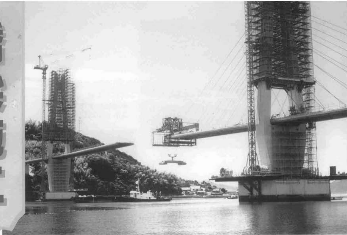
⇧大芝大橋架設状況
