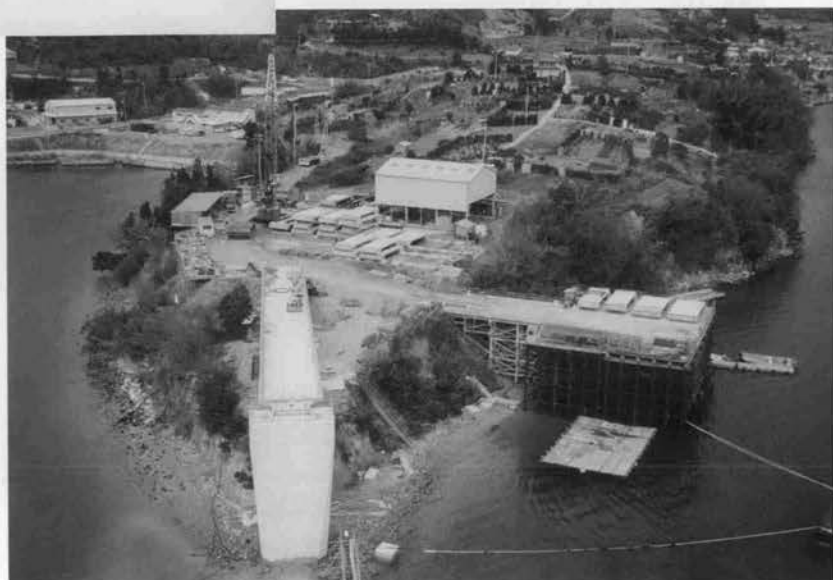
大芝大橋主桁製作⇨ ヤード
