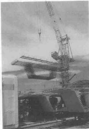
写真-2 鉄筋籠吊込み状況
