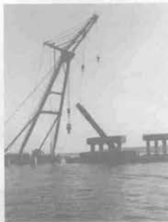
杭切断後の撤去
