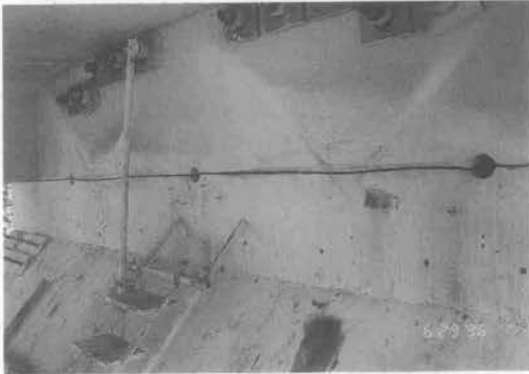
写真-4 バックステー頭部切断状況
