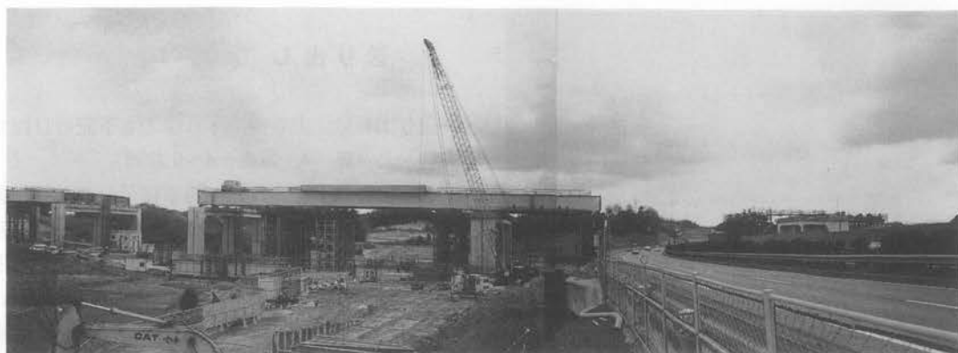
写真-4 送り出しヤード状況
