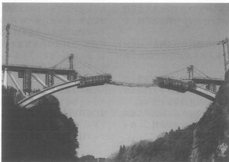
写真-3 合成アーチ施工状況
