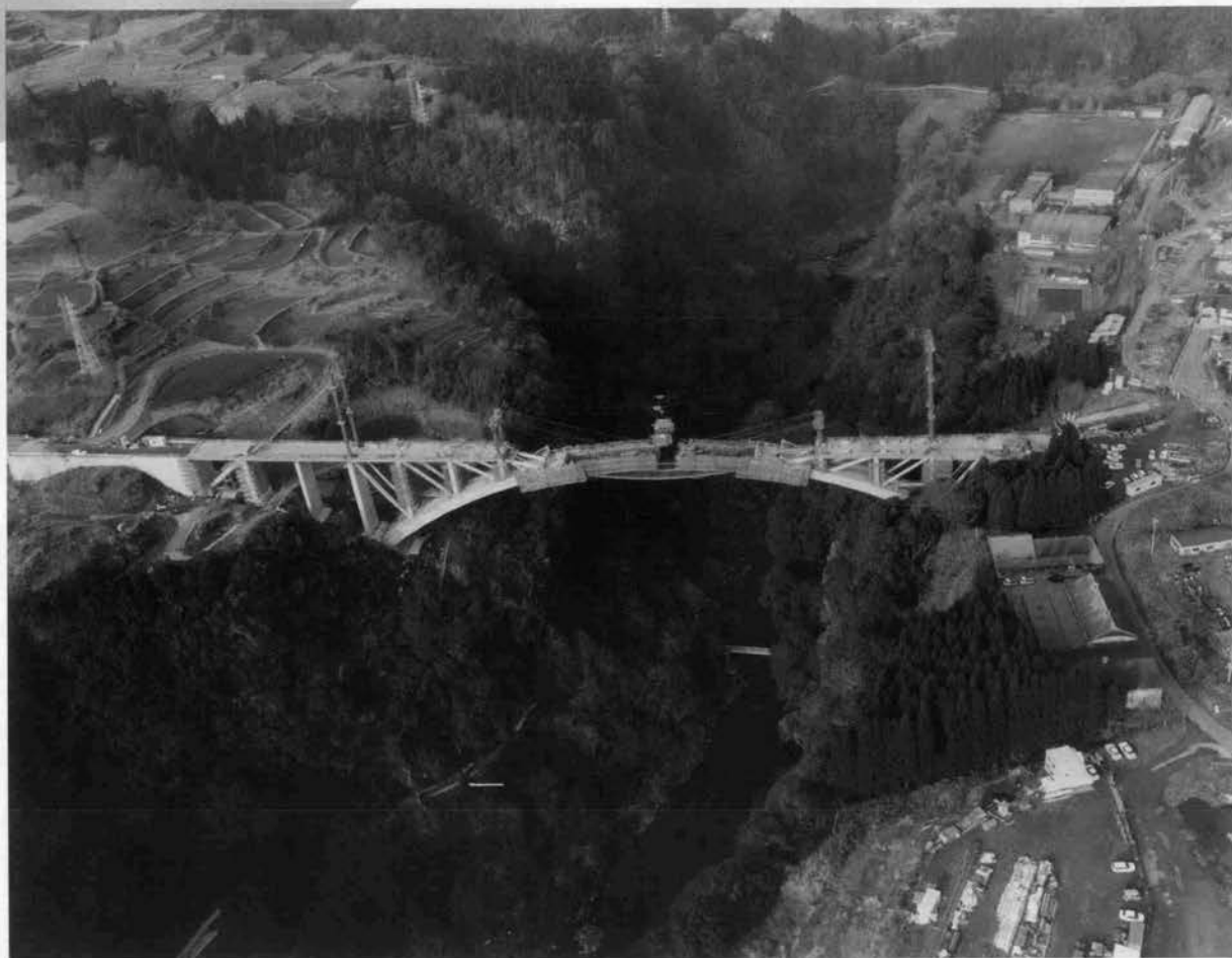
↑青葉大橋鋼管架設状況
