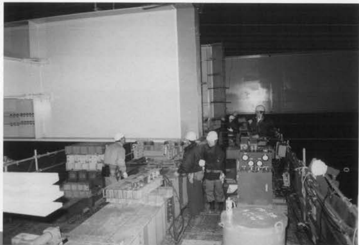
知多半島道路上の夜間送り出し作業⇨ 桁先端がPB5ベントに到達
