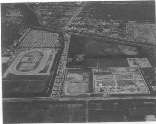
写真—1 架橋地点周辺状況および製作・ストックヤード
