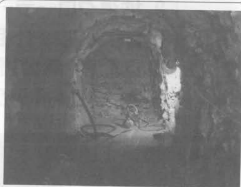
全断面トンネル掘削/深礎工事
