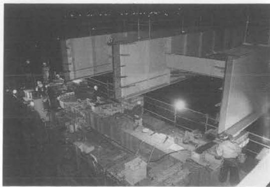
写真-6 桁先端到達状況
