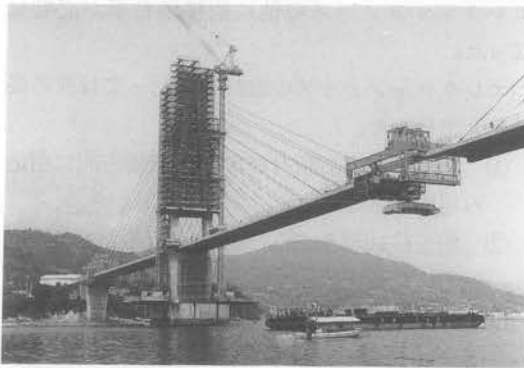
写真—4 架設状況 (大芝大橋)
