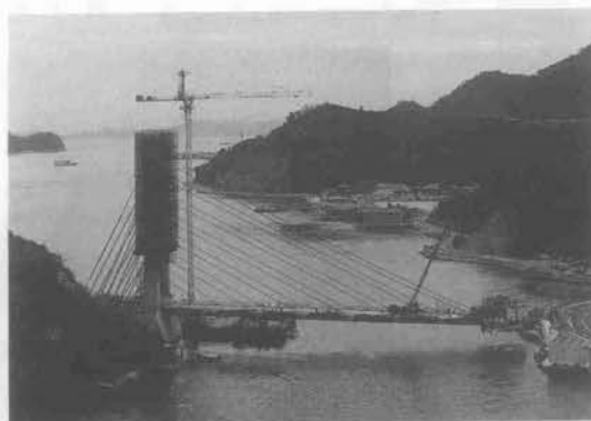
写真-2 架設状況(平羅橋)
