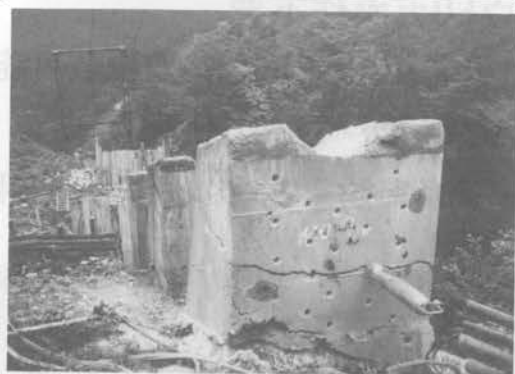
急斜面での導水管受台の解体
