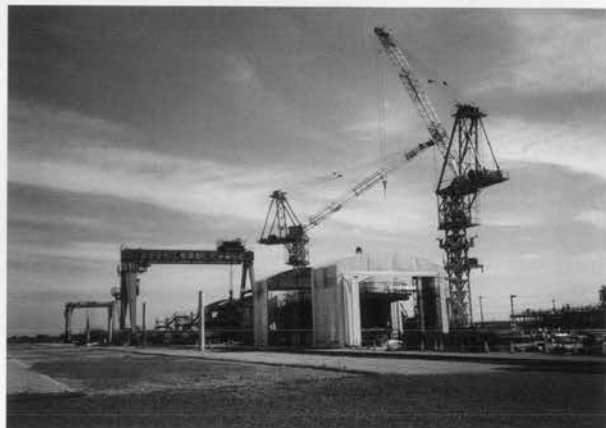
弥富高架橋セグメント製作ヤード⇨ 左奥よりトランスファークレーン 門型クレーン 製作ベース タワークレーン 鉄筋組立ヤード
