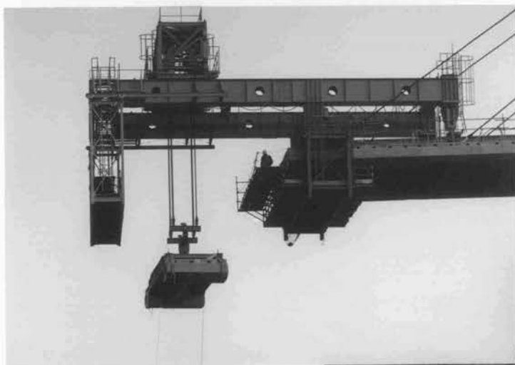
⇐大芝大橋 エレクションノーズによる架設
