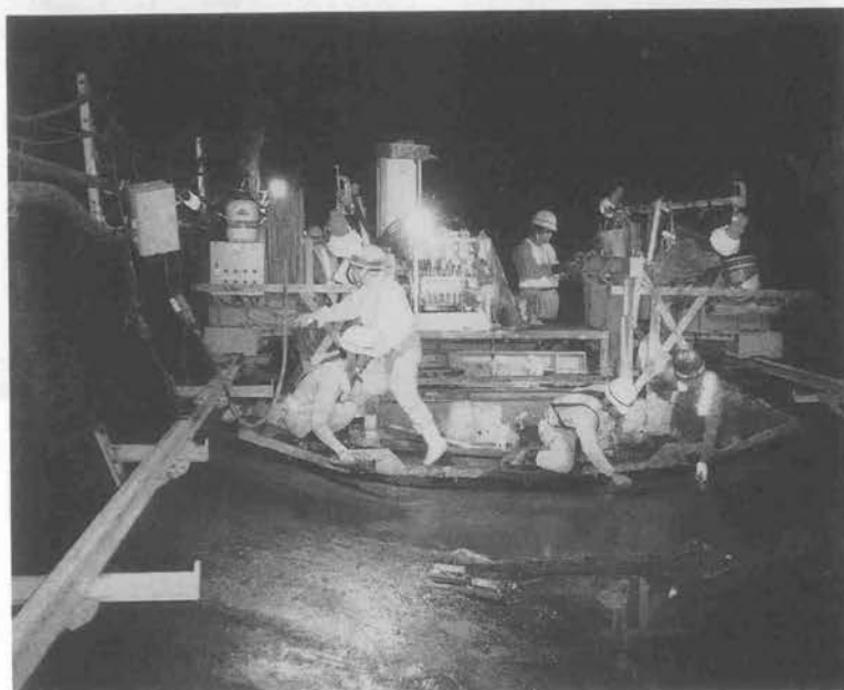
写真—6 インバート打設状況
