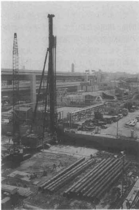
写真-2 鋼管柱列土留工施工状況
