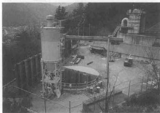
写真-3 仮設縦坑
