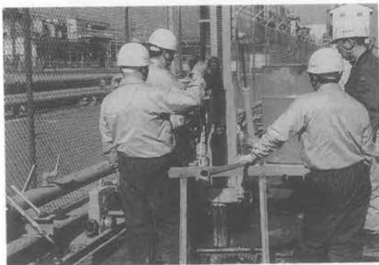
写真-3 小型可搬式ドレン打設機械による施工
