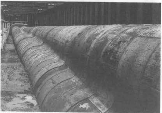
写真-3 開削状況写真(ひねり施工終了時)
