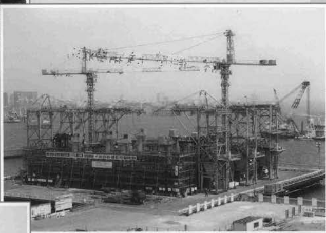
↓換気立坑全景
