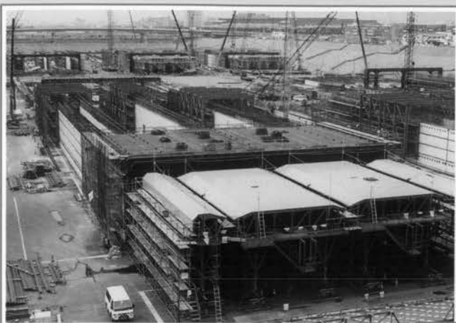
↑側壁上床構築状況
