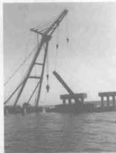
杭切断後の撤去
