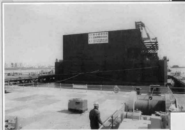
↑鋼殻ケーソン引込み状況
