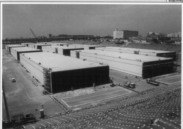
↑沈埋設備構築
