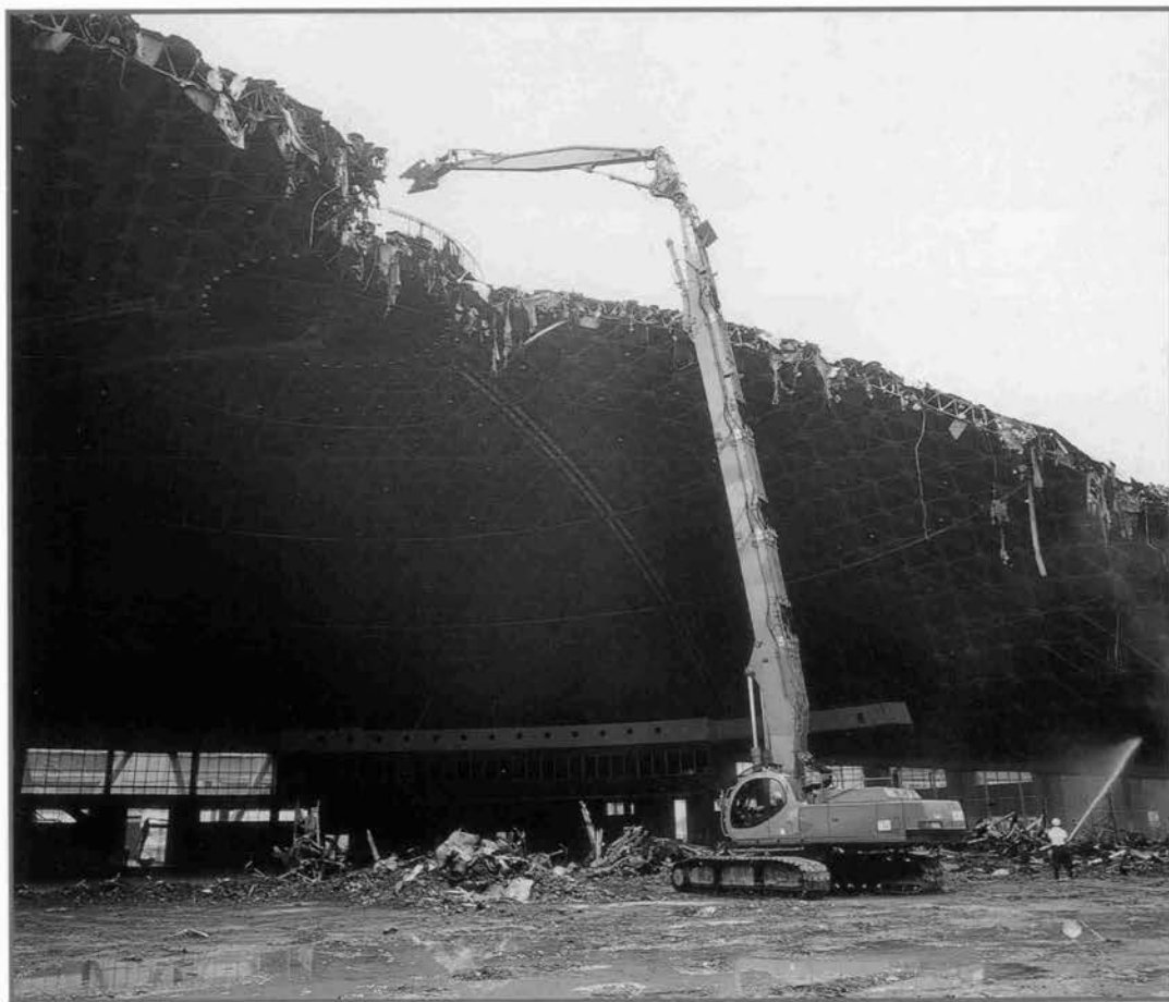
大型ビル解体専用機「SK 700D」株式会社 神戸製鋼所
