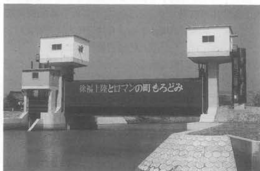
写真—4 新川水門 (佐賀県) シェル構造ローラーゲート (除福上陸とロマンの街もろどみ)
