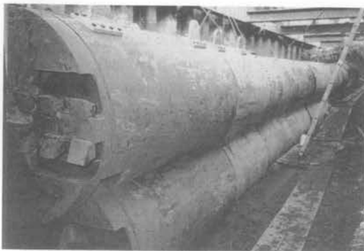
写真-2 開削状況写真(姿勢制御終了時)
