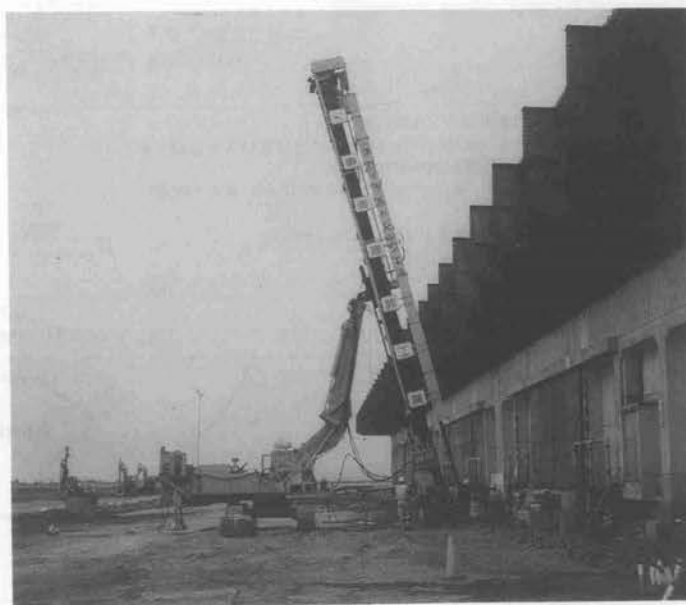
写真-2 鉛直打設・斜め打設兼用機施工状況（釧路港）
