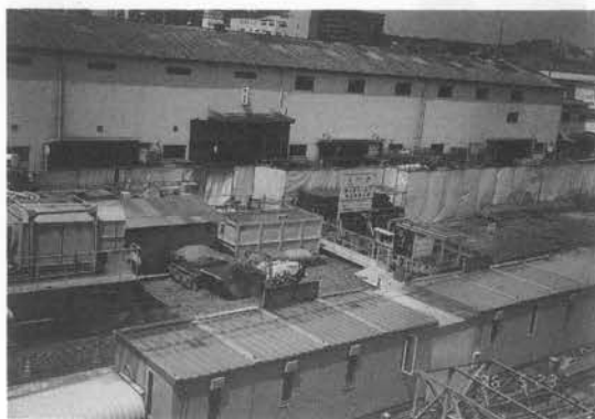
写真—1 実験場全景
