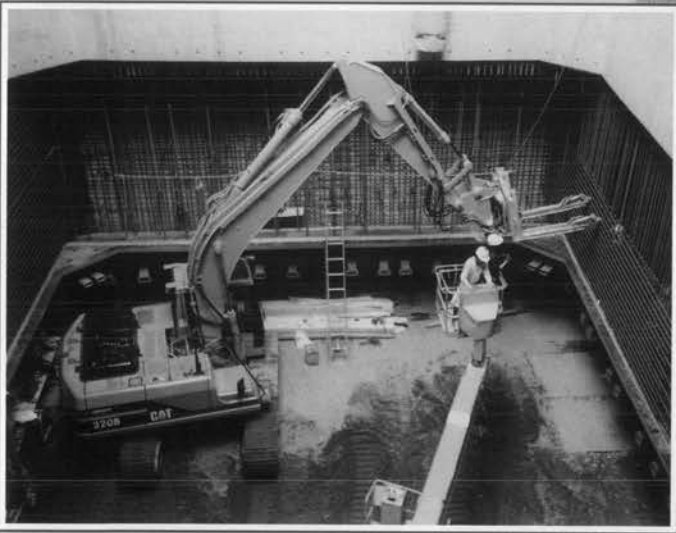
↑組鉄筋による配筋
