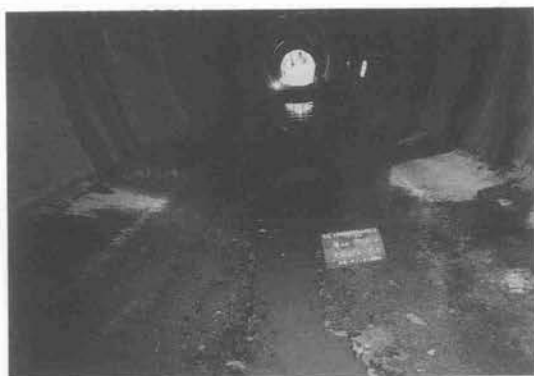
写真—4 インバート切削前の状況
