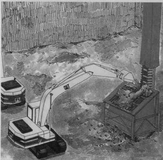
↑掘削・ホッパへの投入
