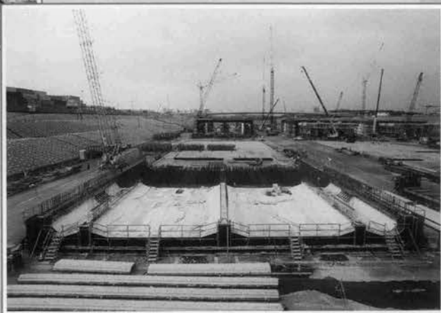
↓函体下床構築状況
