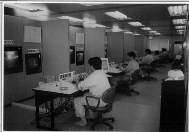
↓掘削機操作室（地上遠隔）
