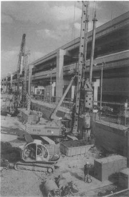
写真-1 先行削孔施工状況
