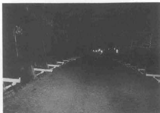
写真—5 インバート切削後の状況
