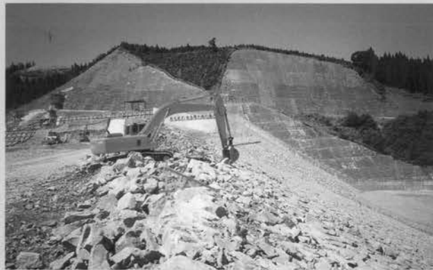
⇨ リップラップ施工状況
