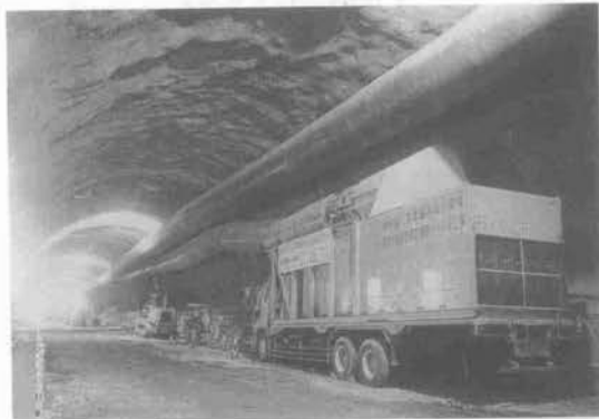
写真—4 城端トンネルにおける S.C.T.V. による坑内状況 (集じん機より坑口側を見る)
