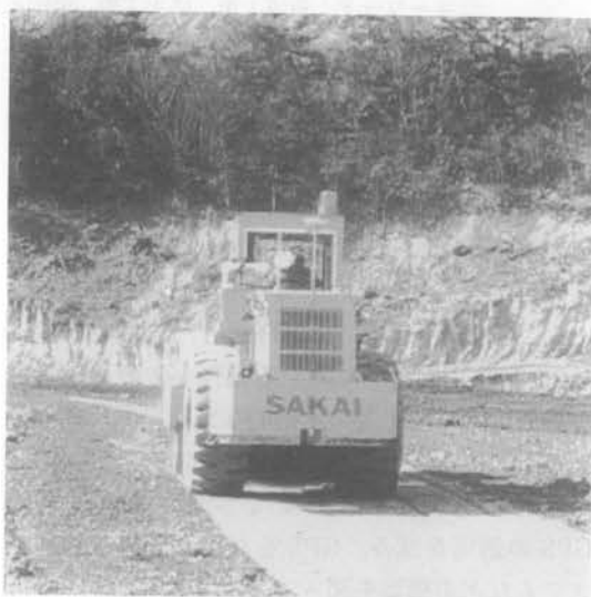
写真-2 振動ローラ走行状況
