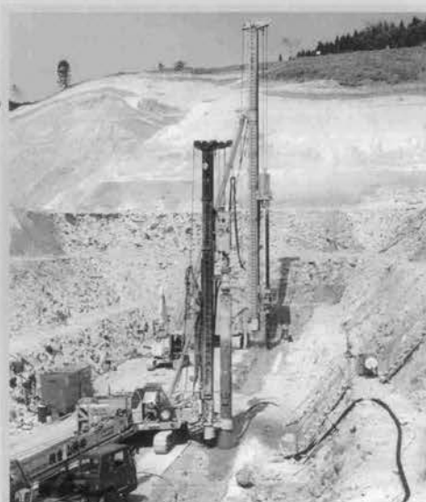
地中連続壁施工状況
