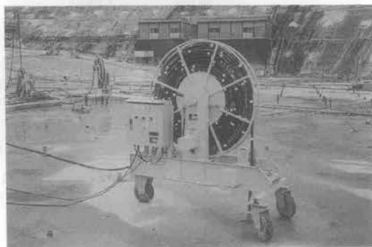
写真-4 ホースパッカ巻上げ装置
