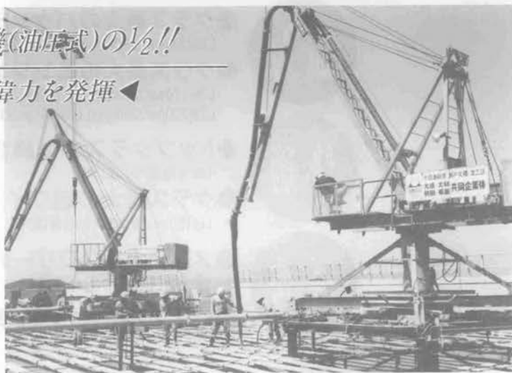
(本四架橋現場設置例)
