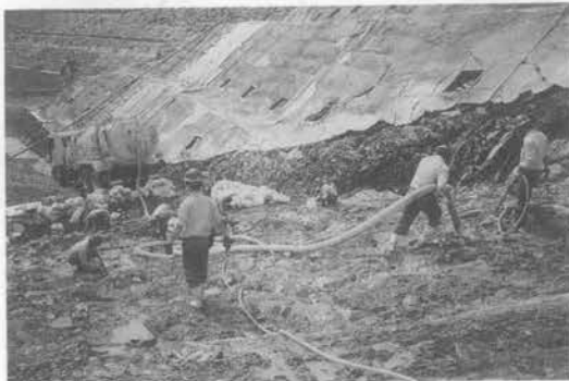
写真-1 バキューム車による岩盤清掃
