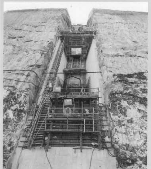
⇩ 監査廊傾斜部油圧上昇式セントル
