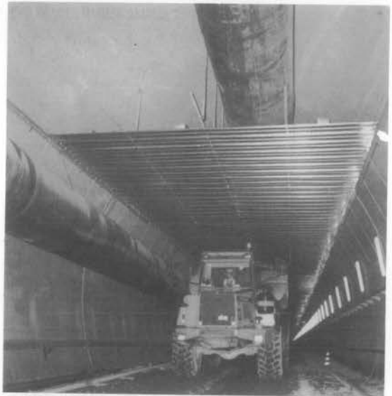
写真一 排気坑道（ダクト）用天井板取付状況（五里ヶ峯トンネル）
