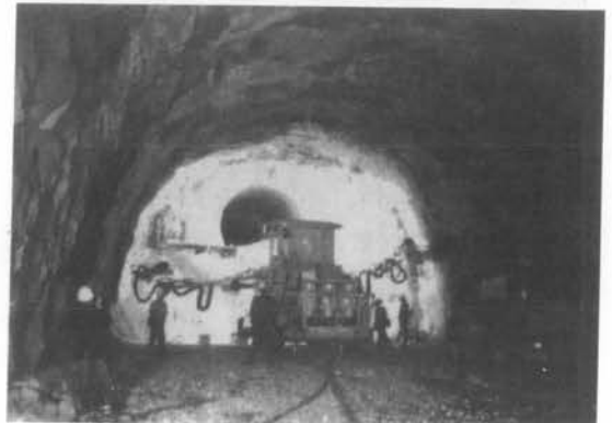
写真二 本坑内に設けた TBM 先進導坑
