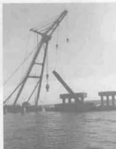
杭切断後の撤去
