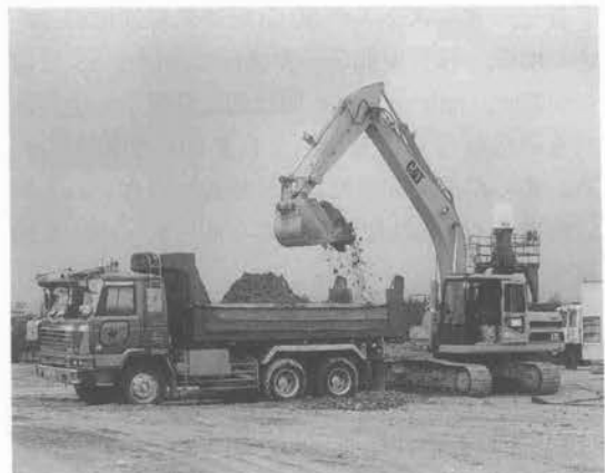
写真-2 ダンプ積み作業状況
