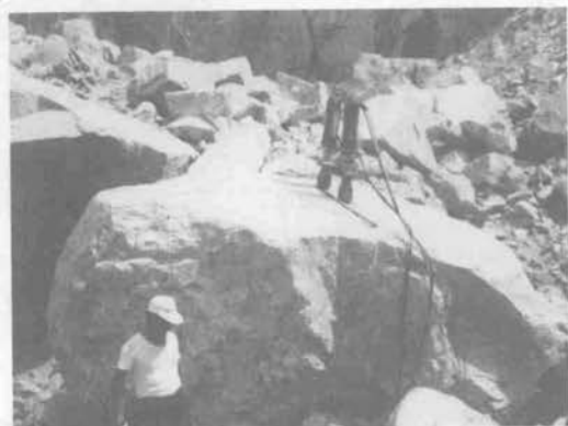
災害復旧での巨石処理
