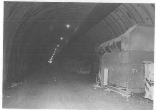
写真-5 高玉西トンネルにおけるS.C.T.V.による坑内状況 (集じん機より坑側を見る。天井灯が坑口より鮮明に見える)
