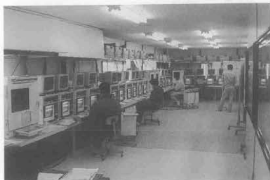
写真-2 グラウチング集中管理室
