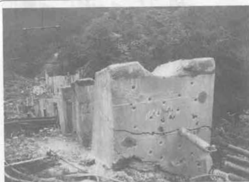
急斜面での導水管受台の解体
