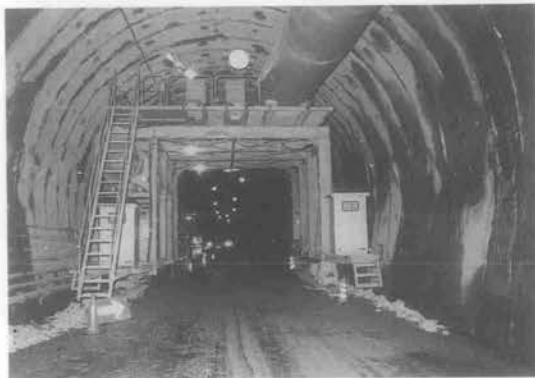
写真—2 換気設備
