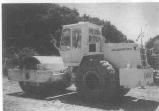
写真-1 GPS 装置を搭載した振動ローラ
