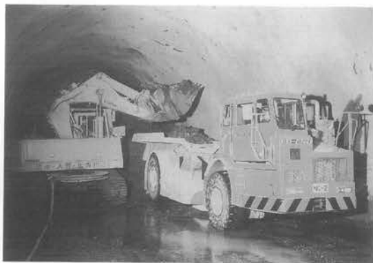
写真-3 ずり積み状況
