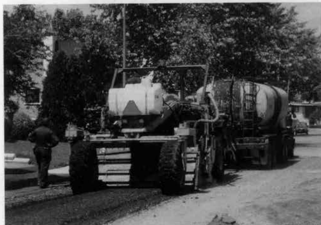
◆カナダ・モントリオール市道をフォームド・リサイクル中のSOTERシステムを搭載のRP-250
