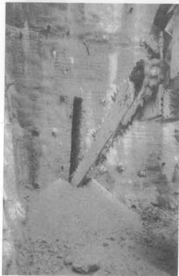
写真二 Perforex による掘削
