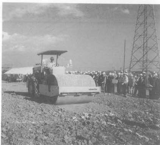
写真-1 転圧状況
