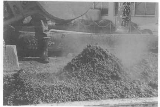
写真—2 排出状況
