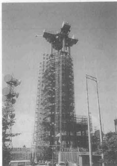
写真-1 高鈴山レーダ雨量観測所での施工状況
