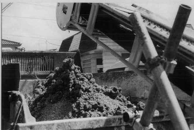
↑小口径管推進工事現場でのHB-10型 による改良状態
