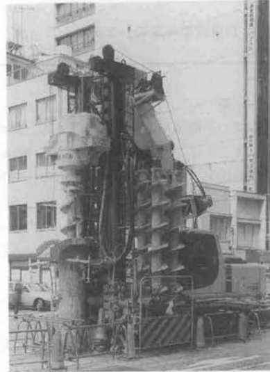
写真-1 低空頭杭打機
