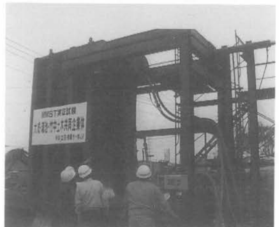
写真—6 裏込充填実験
