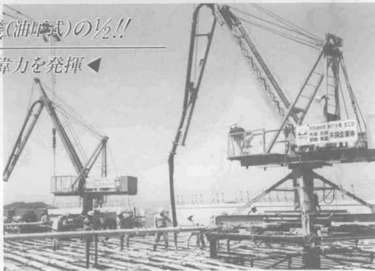
(本四架橋現場設置例)
