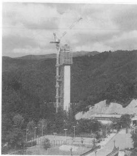
写真-1 施工中の高橋脚
