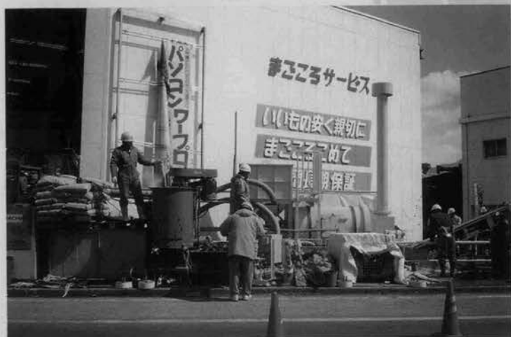
↑ HB-10型 小口径管推進工事現場での固化処理
