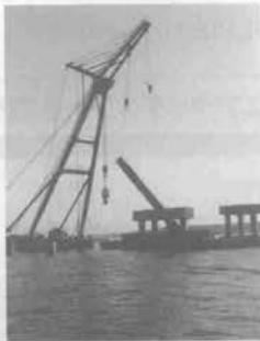
杭切断後の撤去
