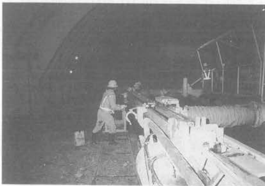
写真-3 鋼管セット状況
