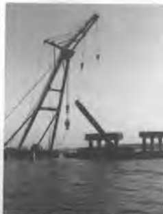
杭切断後の撤去
