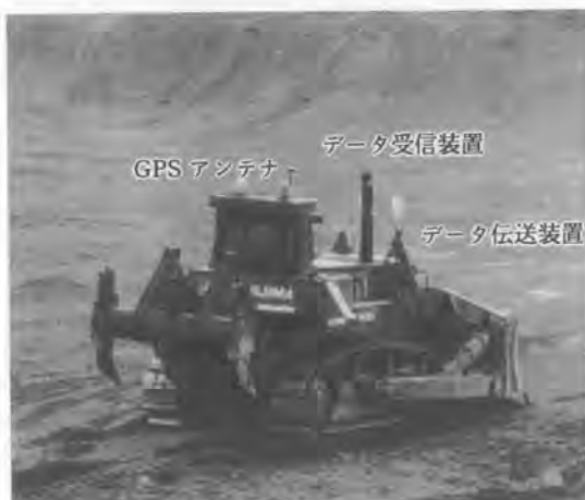
写真-2 GPS搭載ブルドーザによる施工状況
