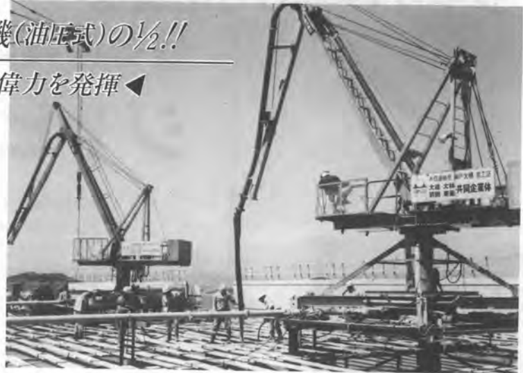
(本四架橋現場設置例)
