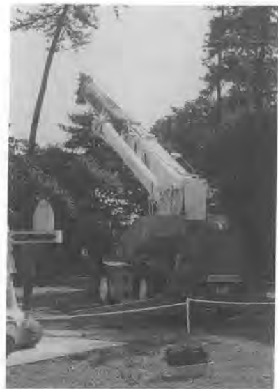
写真一4 安全装置を装備したホイールクレーン
