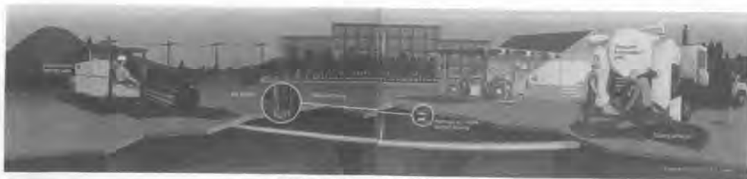
写真-2 Vacuum 掘削装置
