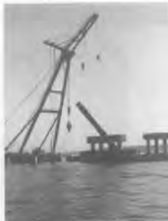
杭切断後の撤去
