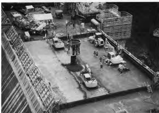
↑コンクリート打設状況(ELCM・左左岸方向)
