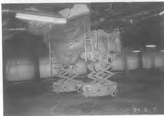
写真-3 飛散防止・落綿回収機能付き高所作業車
