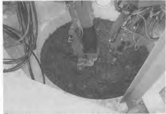
写真二 掘削状況
