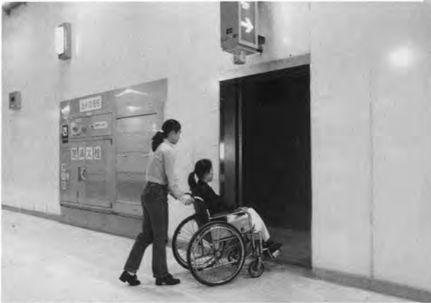
↑段差のない非常口
