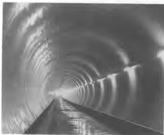
写真-2 軌道スラブ設置状況
