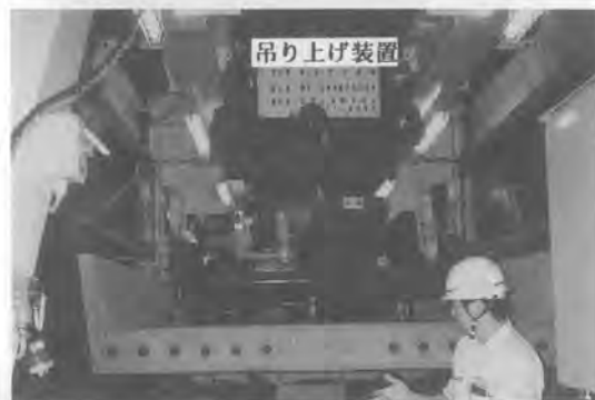
写真一 軌道スラブ据付装置
