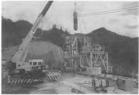
写真一 施工状況全景
