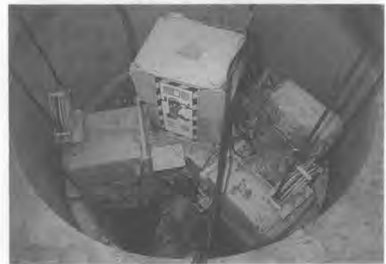
写真三 土留状況
