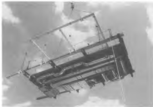
写真-1 ユニットフロア揚重状況
