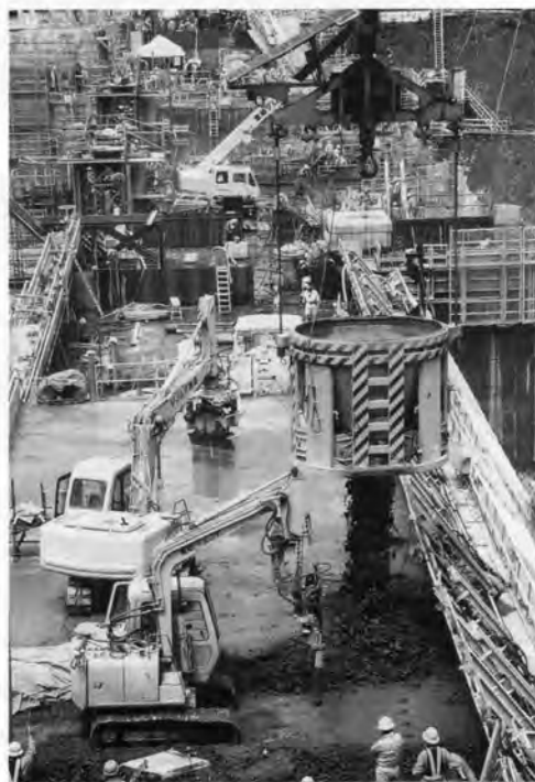
↑遠隔操作によるコンクリート放出状況
