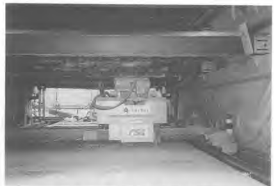
写真-2 ロボットによる吹付け状況
