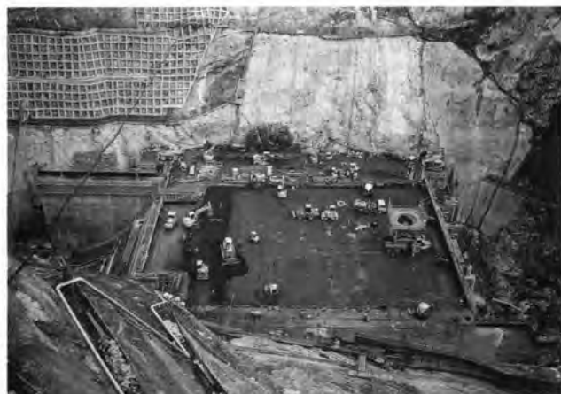
↑コンクリート打設状況(RCD工法)
