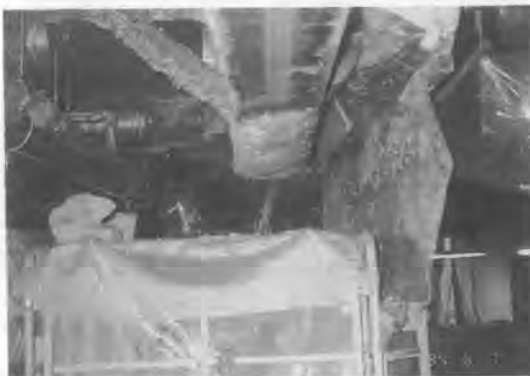
写真-4 作業車による耐火被覆吹付け状況
