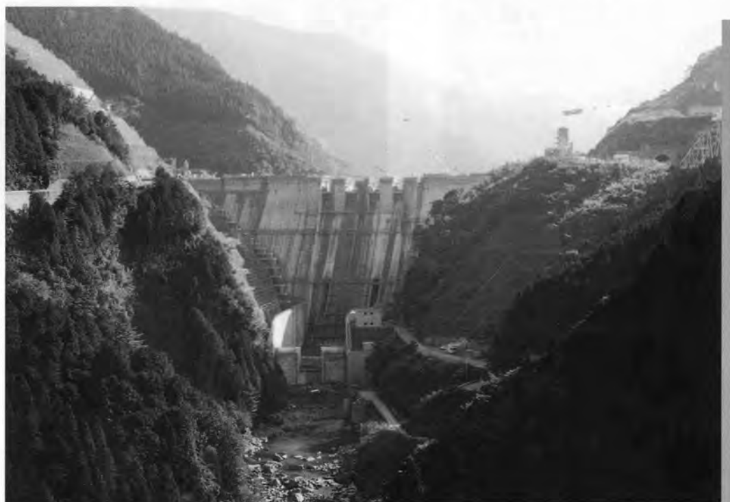
↑建設中の富郷ダム
