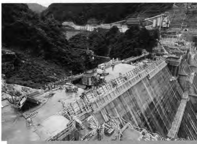
↑コンクリート打設状況(ELCM・上下流方向)
