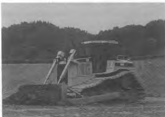
写真—2 D6Rブルドーザ
