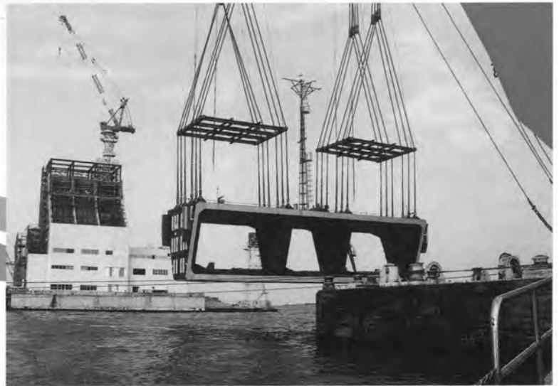
↑Vブロックの沈設風景
