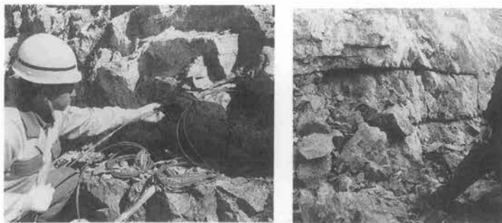
写真-1 SD・エレクトロプラスト工法施工状況
