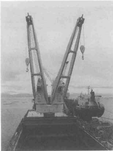
写真—7 デッキクレーン
