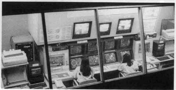
⇐自動施工管理システム管理状況
