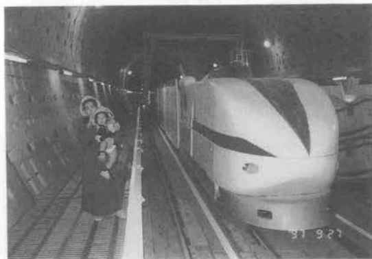
写真-5 渋川雨水貯留管工事の偽装バッテリーロコと地元見学者
