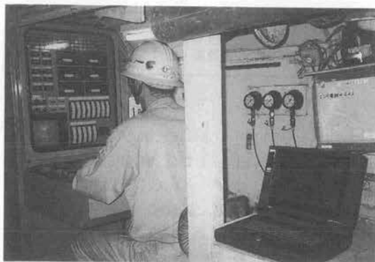
写真-1 TBM掘削状況
