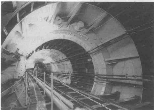
写真-3 子機発進部覆工状況
