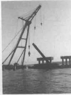
杭切断後の撤去
