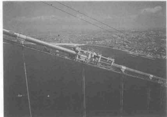
写真-9 ラッピングマシン
