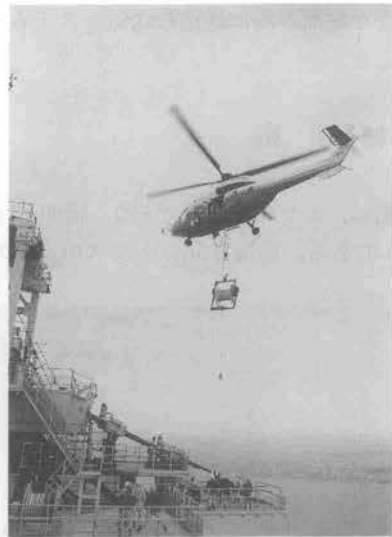
写真-8 パイロットロープの渡海
