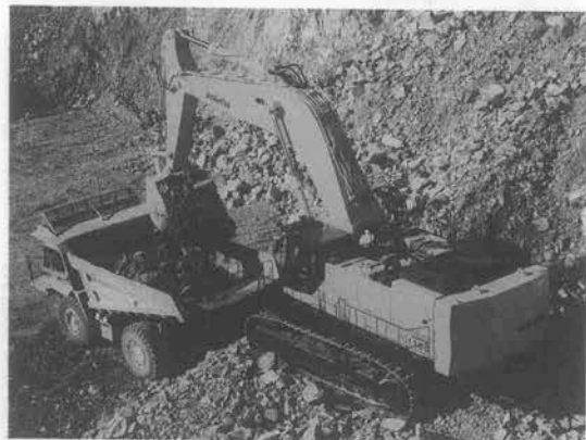
写真-1 コマツ パワーアバンセ PC 1100 油圧ショベル
