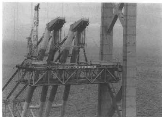
写真—12 大ブロック架設
