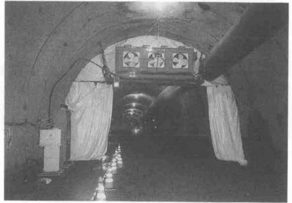
写真-2 集塵装置設置状況
