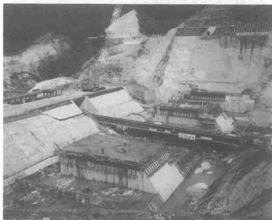
写真-3 現場全景
