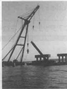
杭切断後の撤去
