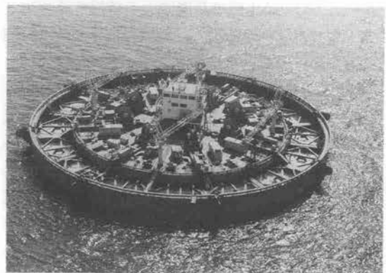
写真二 沈設を完了した2Pケーソン (8台のリニアウインチが装備されている)
