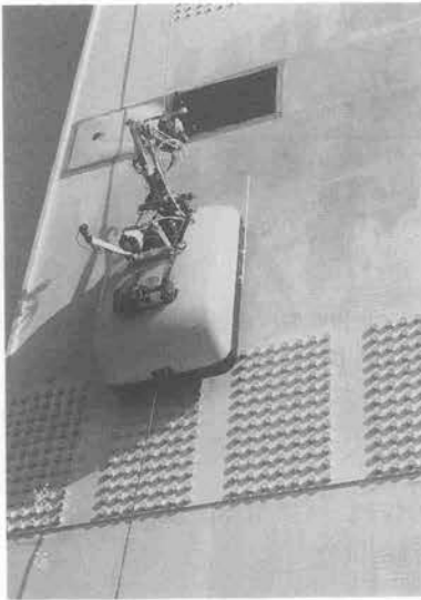
写真-13 主塔点検ロボット
