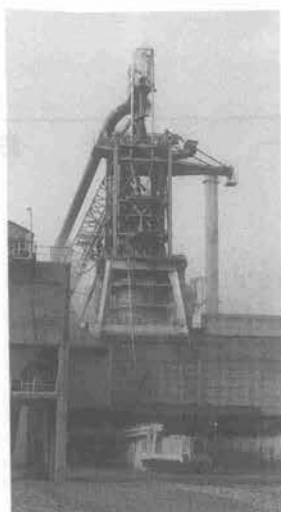
完成した高炉
