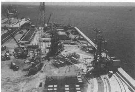
写真-2 地下連壁掘削状況
