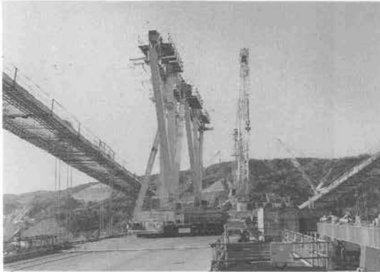
写真—10 ドーリーによる補剛桁部材の運搬
