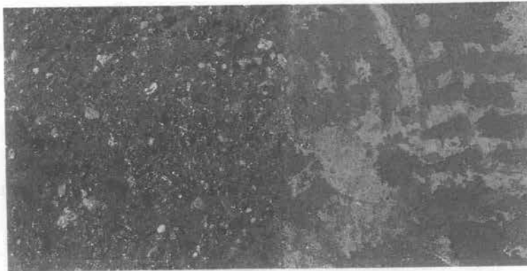
写真-4 打ち継ぎ面のカット前とカット後
