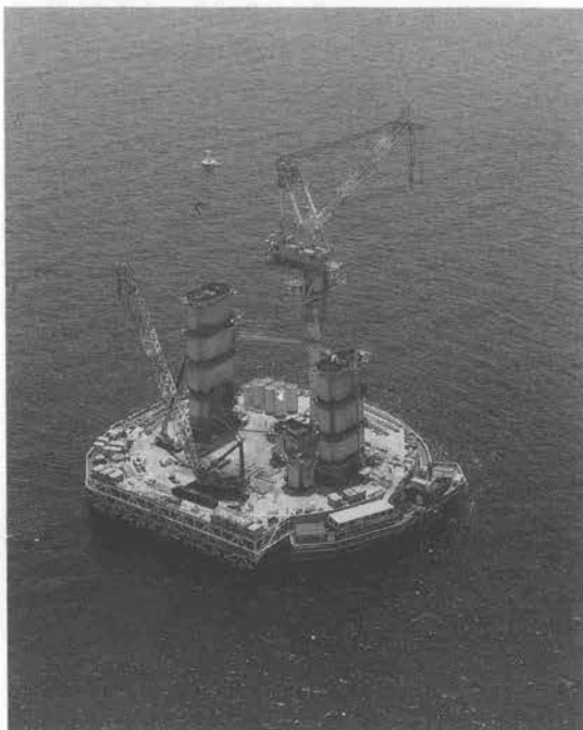
写真-7 タワークレーン
