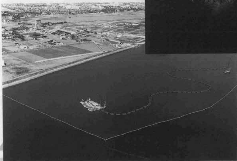
⇩ 高濃度汚泥浚渫船 （負圧吸泥方式）の施工状況
