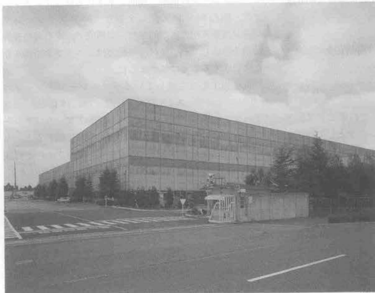
写真—2 大久保建設機械工場
