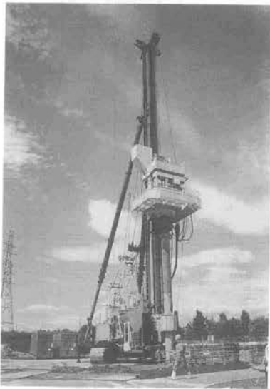
写真-1 施工機全景
