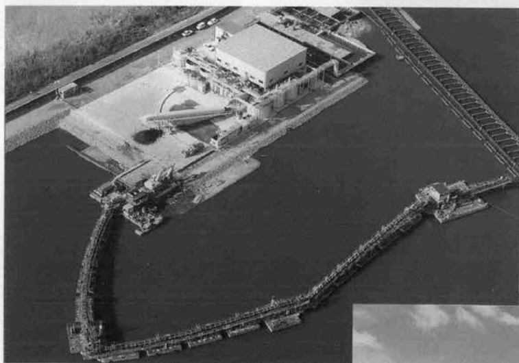
↑フローティングコンベヤの施工状況 (脱水から埋立への連続施工)
