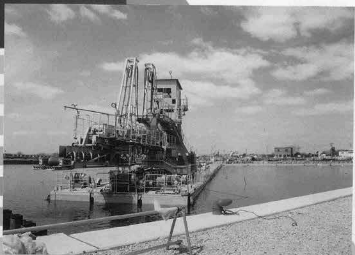
フローティングコンベヤまき出し部↑
