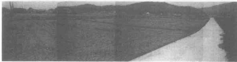
写真-6 施工前の現況
