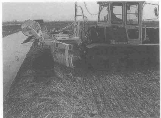
写真-3 畦際の作業
