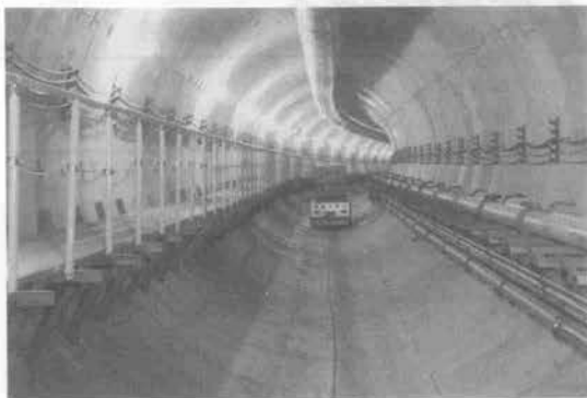
写真-1 シールド坑内
