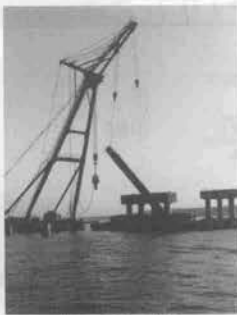
杭切断後の撤去
