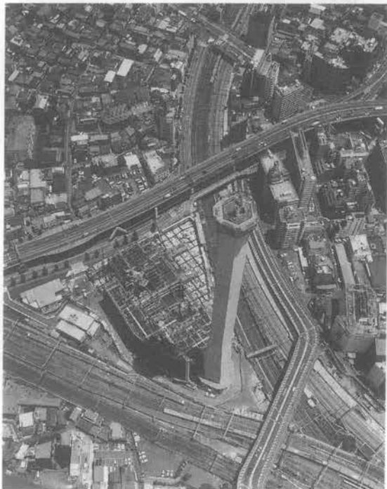
写真-1 現場全景
