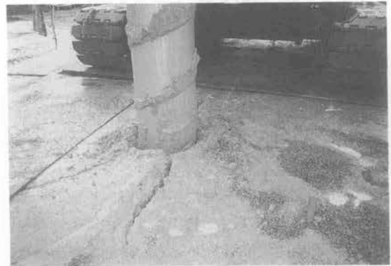
写真-2 打設状況
