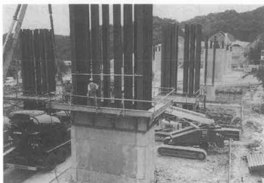
写真-9 打設足場
