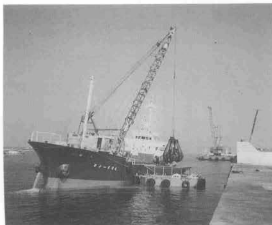
写真-3 チェーン式トレミーの使用状況
