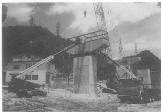
写真-8 函体の設置（梁部）
