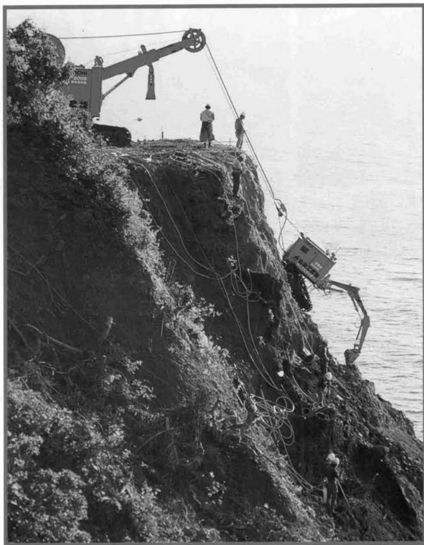
岩盤崩落事故を未然に防止する断崖掘削機 日立建機株式会社
