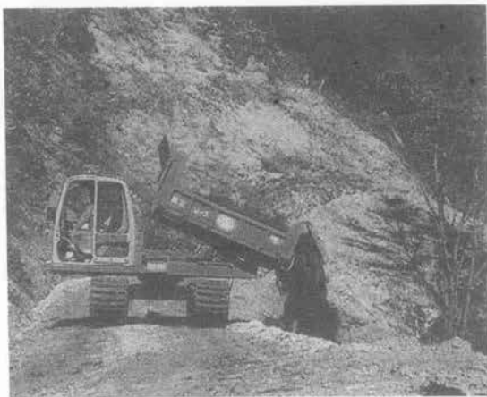
写真—3 林道造成工事でのサイドダンプ
