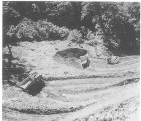
写真一2 スイッチバック方式による作業状況
