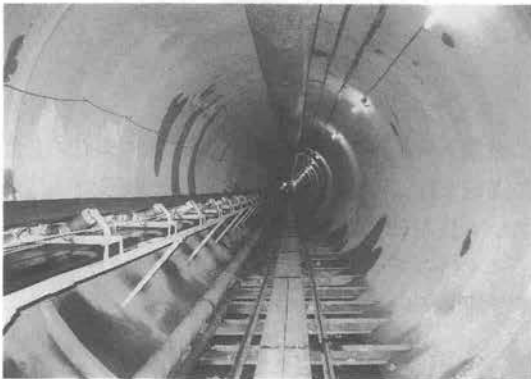
写真-1 坑内ベルトコンベヤ設置状況
