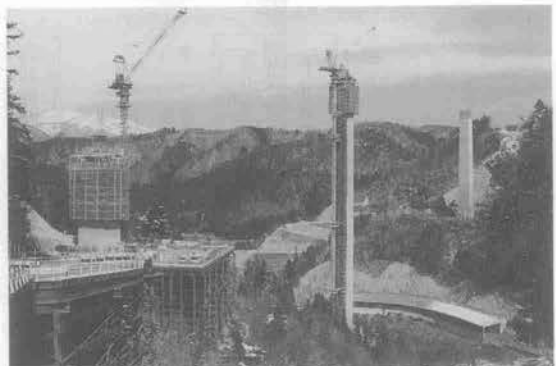
写真-1 施工中の鷺見橋
