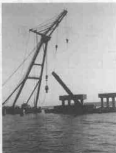
杭切断後の撤去
