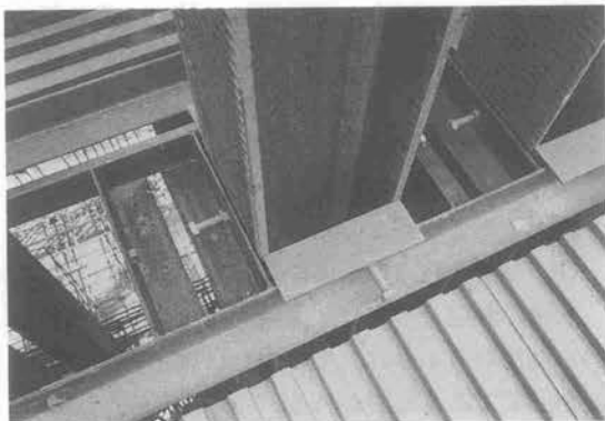
写真-6 鉛直保持の状況
