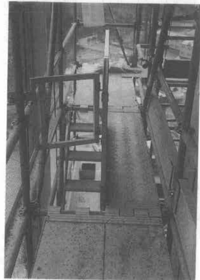
写真-3 作業足場(外周部)
