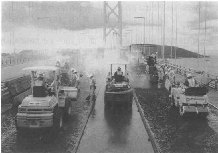
写真—1 グースアスファルト舗装状況
