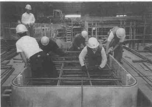
写真—4 帯鉄筋・セパレータの取付
