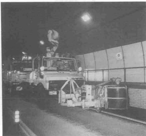
写真二 万能車による機械清掃作業
