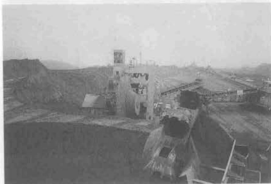
写真-3 土取A地区バケットホイールエキスカベータ掘削状況(2)
