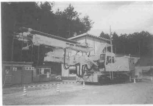
写真-20 プレライニングマシン全景
