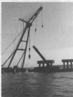
杭切断後の撤去
