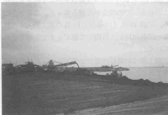
写真-8 スプレッドによる撤出し状況
