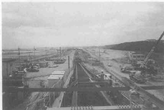
写真-6 幹線コンベヤ
