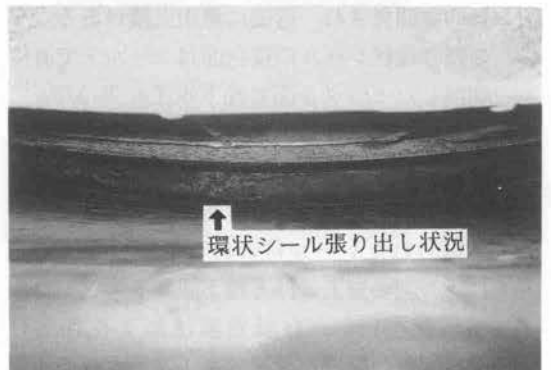
写真-4 環状シールド張り出し状況
