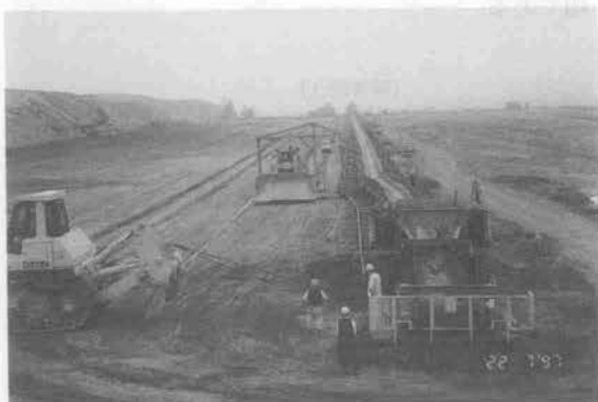
写真-4 シフタブルコンベヤシフト状況
