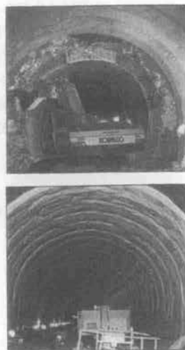
図-1 コベルコ製バックホウを用いて掘削 (上)、PVC による漏水防止策を使用 (下)
