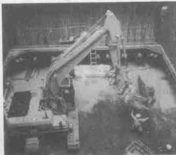
写真-2 組鉄筋の把持状況
