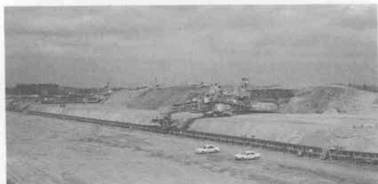
写真-2 土取A地区バケットホイールエキスカベータ掘削状況(1)
