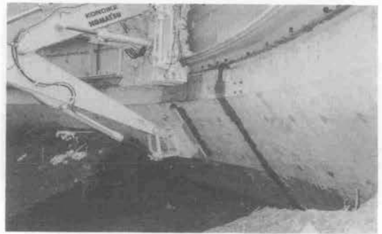
写真-5 刃口清掃用ブラシ (作動確認状況)
