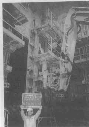
写真-4 壁型枠設置状況
