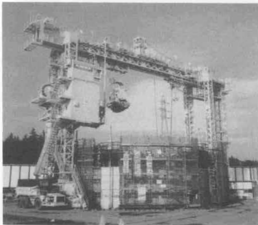
写真-3 自動掘土機
