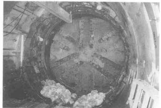
写真-3 接合状況 (貫入側カッタ面板)
