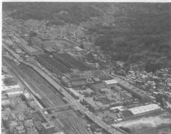
写真—1 広工場全景
