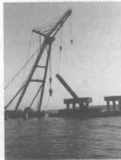
杭切断後の撤去
