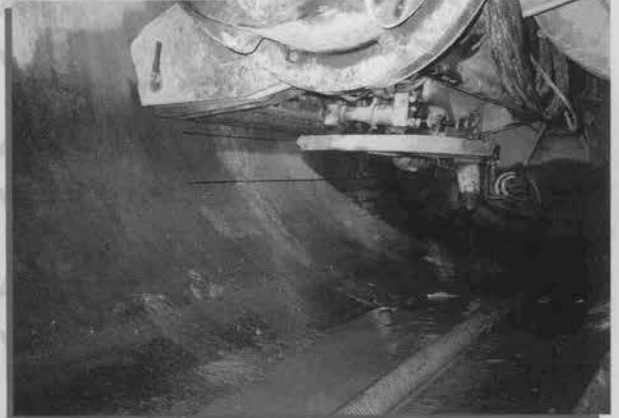
⇩既設下水道管切断中（縦方向）
