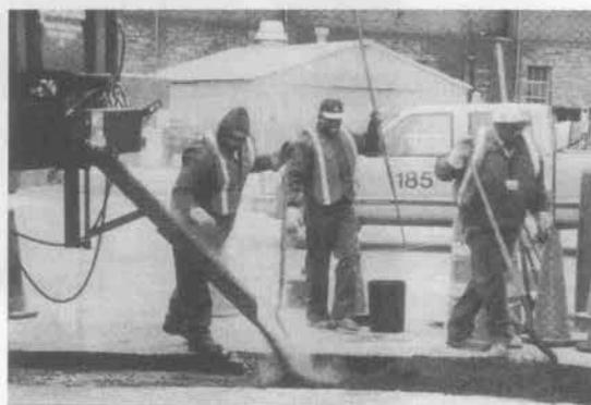
写真-2 合材加熱装置がアスファルト合材を加熱している
