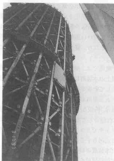
写真—28 揚重状況
