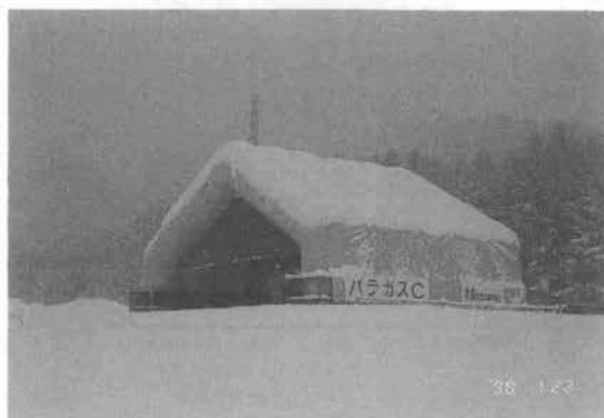
写真-35 「パラガスCs」外観
