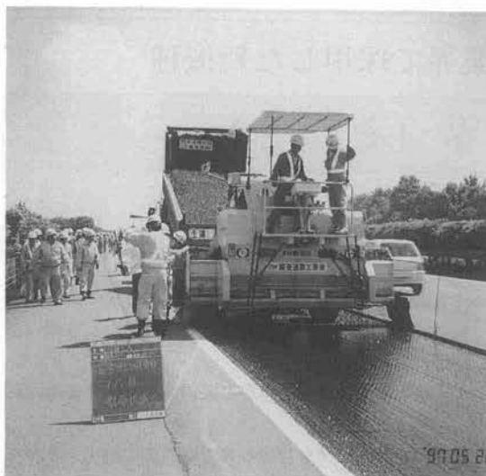
写真-23 常磐自動車道における骨材散布状況 (平成9年5月)
