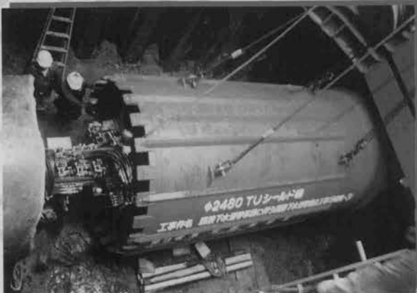
⇩TUシールド機投入中
