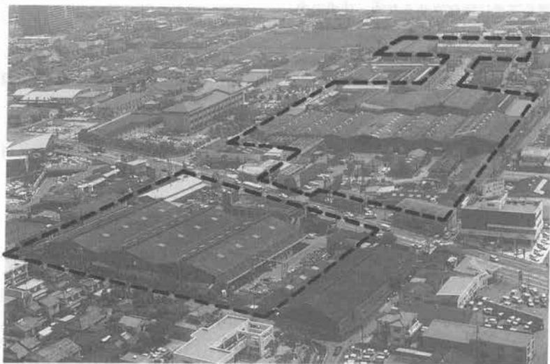
写真—1 工場全景
