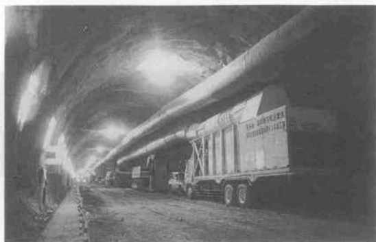
写真-1 集塵機より後方の坑内浄化状況
