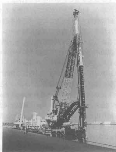
写真-8 F &amp; G 3545 起重機船(クレーン・グラブ兼用機)
