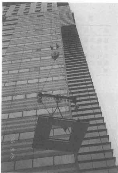
写真—27 ウォールハング工法
