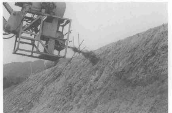
写真10 施工状況 (勾配 1 : 0.7 ラス網設置) 急斜面では、吐出した材料は斜面と直角に付着する。
