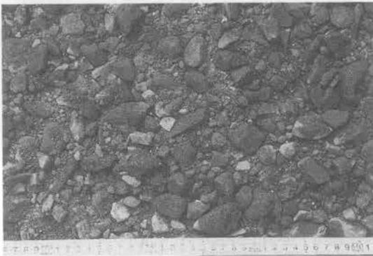
写真—13 改良路盤材
