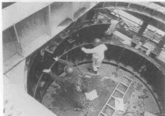
写真—1 鋼製セグメント組立状況写真
