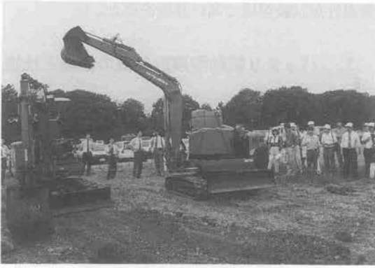
写真-3 バケット &amp; 散水装置
