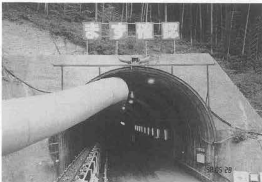
写真—1 田上トンネル
