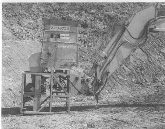
写真-6 吹付施工機械の全景
