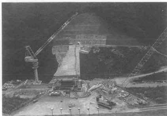
写真-1 ダム堤体全景
