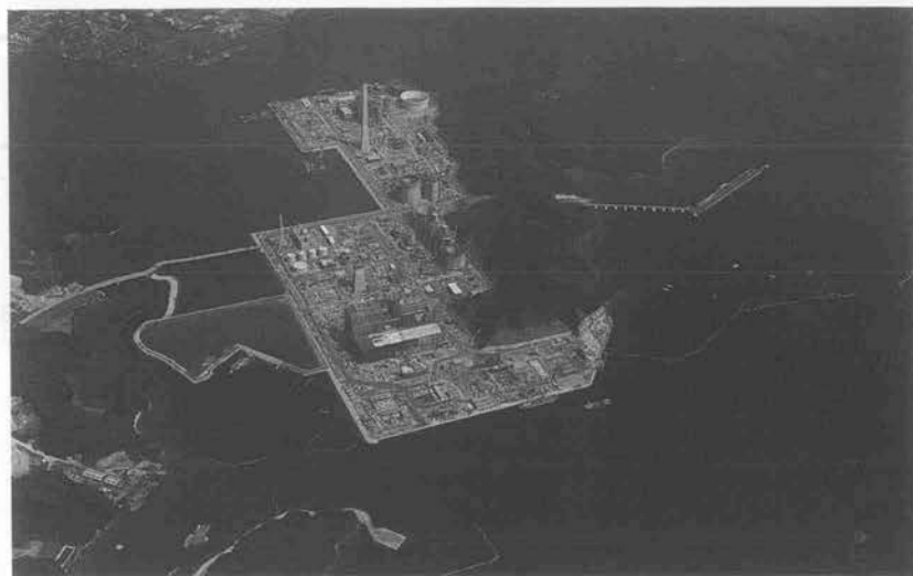
写真一1 工事状況全景
