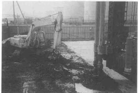
写真-3 施工状況
