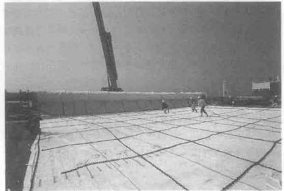
写真-2 シートの巻取り状況
