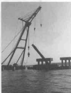
杭切断後の撤去
