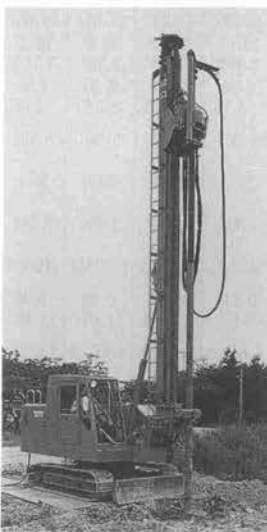
写真-6 日車 DHJ-12 地盤改良機械
