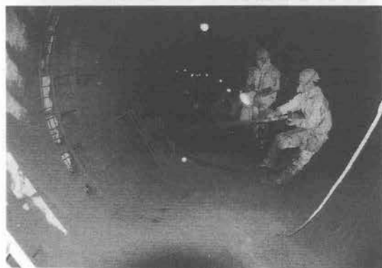
写真-3 吹付け施工状況
