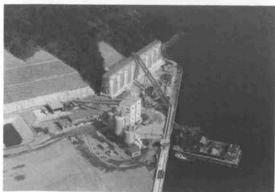
写真一2 コンクリート製造プラント全景
