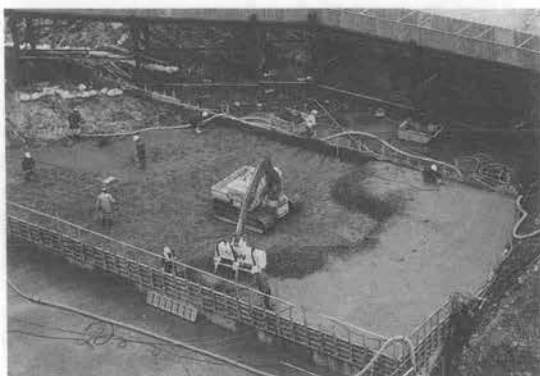
写真-3 締固め状況
