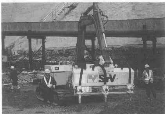
写真-4 締固め状況
