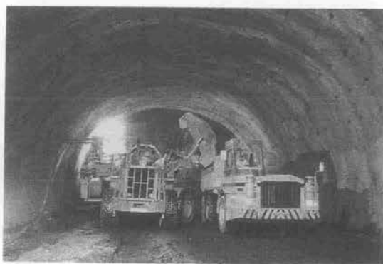
写真-2 掘削ずり出し併行作業
