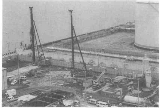
写真-2 施工状況
