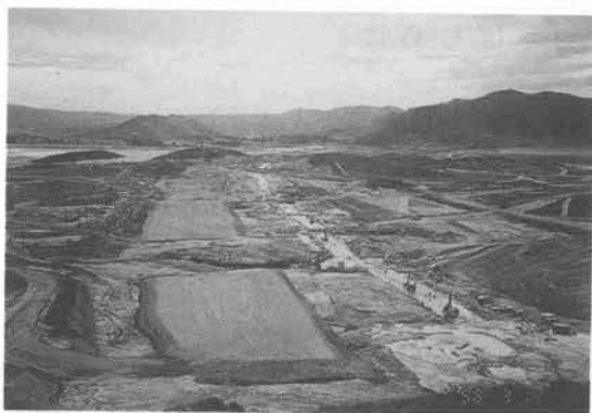
写真-2 西ダム施工状況
