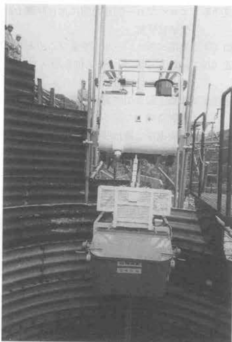
写真-7 掘削土砂搬出装置
