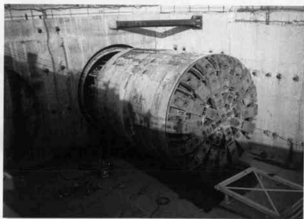
↑ Uターン用架台へのシールド押し出し
