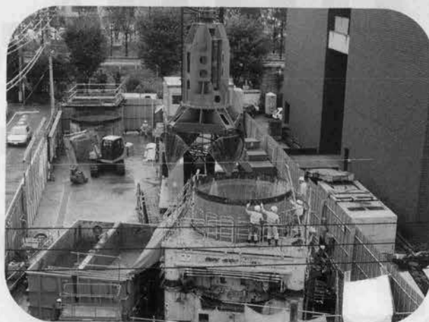
↑NTT立川～新明神発進立坑施行状況 (平成9年9月)
