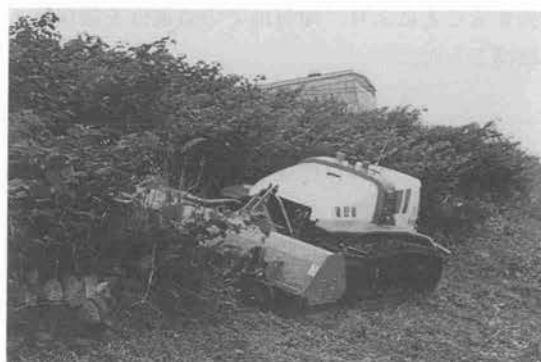
写真-4 現場試験状況（河川堤防法面）
