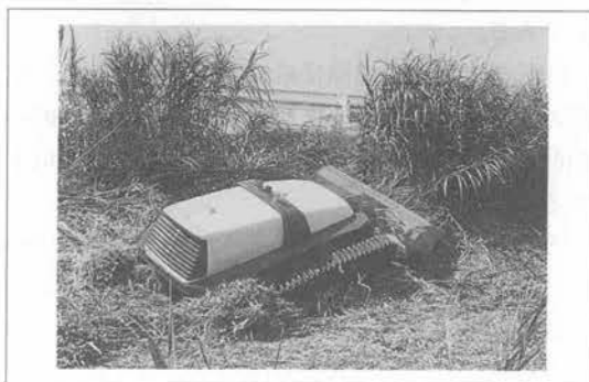
写真-5 現場試験状況（道路法面）
