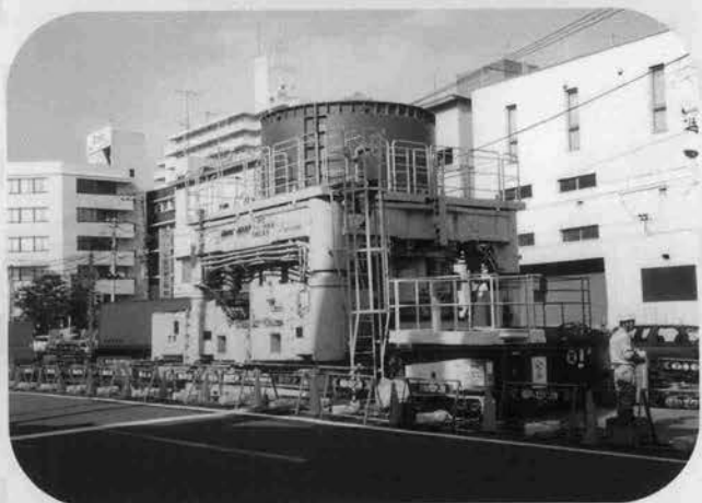
↑NTT三田～品川中間立坑全旋回ボーリングマシン設置状況(平成6年7月)
