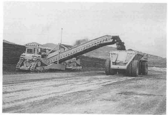
写真—5 コア材採取状況
