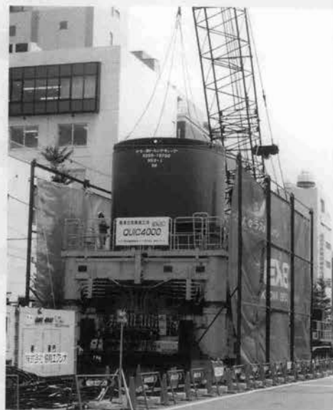
↑NTT三田～品川中間立坑工事ケーシング チューブ吊込み状況 (平成6年7月)
