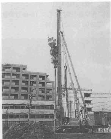
写真-1 SAVE コンポーザの施工状況
