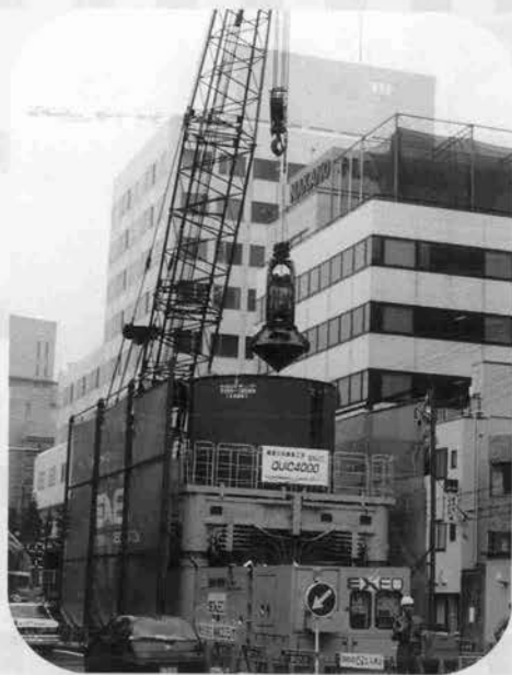
↑NTT三田～品川中間立坑掘削状況 (平成6年7月)
