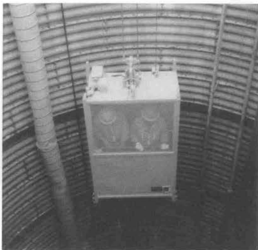
写真-6 工事用エレベータ
