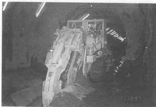
写真-1 トレンチャによる溝掘削状況
