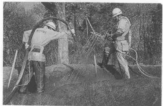
写真-1 施工写真
