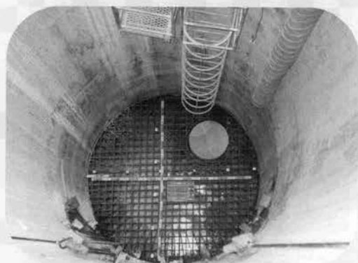
↑NTT立川～新明神発進立坑掘削完了底板鉄 筋格子敷設状況 (平成9年10月)
