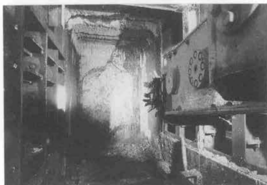
写真-15 底版間接続部の切削状況
