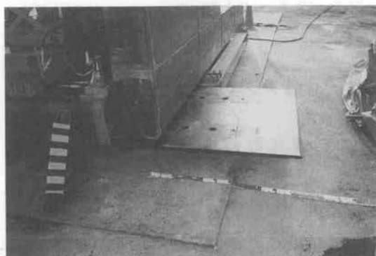
写真一 三 スライド鋼板圧入試運転状況
