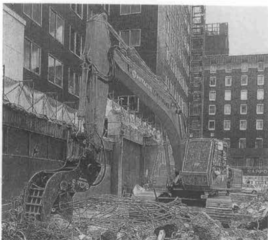
写真—8 小割破碎機
