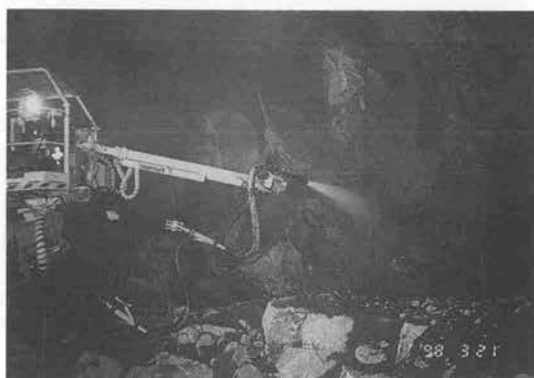
写真-1 スプレイメックの坑内吹付け状況
