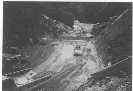
写真-5 盛土初期時の施工状況
