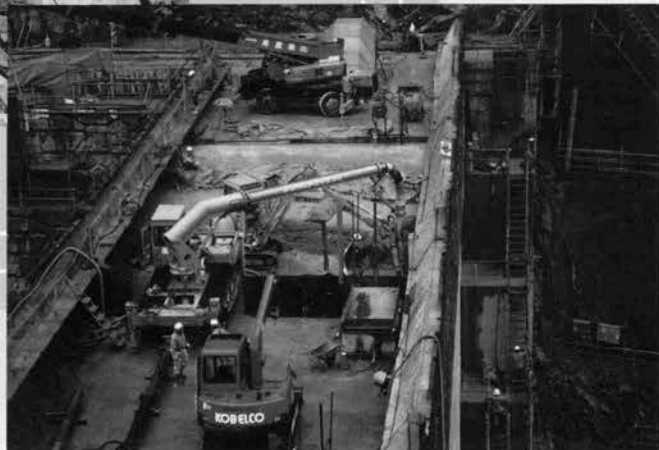
↑中位標高でのPCD工法打設状況
