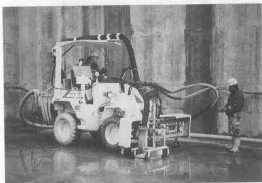
写真-1 グリーンカット施工状況
