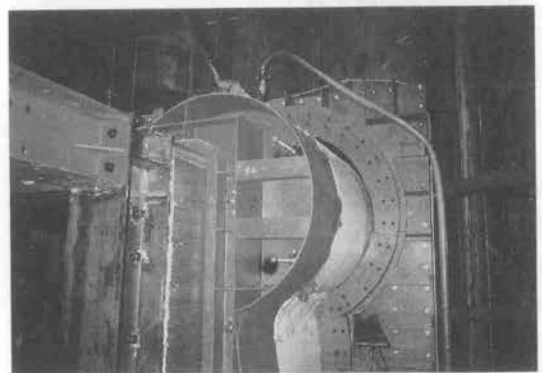
写真-7 鋼管止水枠取付状況
