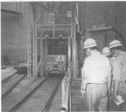
写真一 セグメント自動搬送（発進立坑下）
