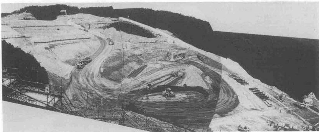
写真-1 盛土施工状況全景
