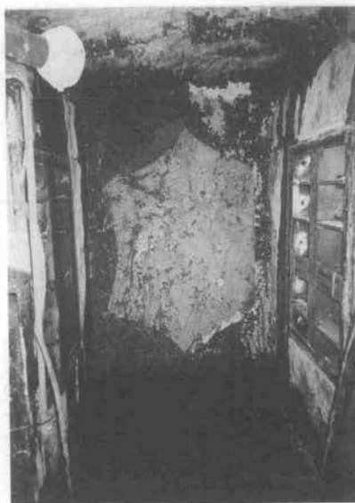
写真-14 接続部充填状況 (34リング)
