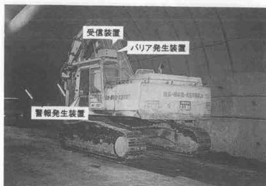
写真-1 システム設置状況
