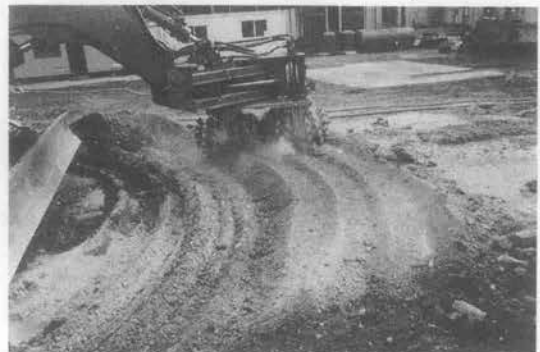
写真-4 不陸除去作業状況（陸上試験）
