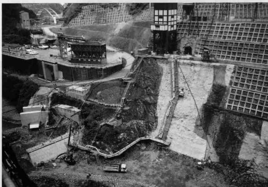
↑ 試験施工時の圧送管配管状況
