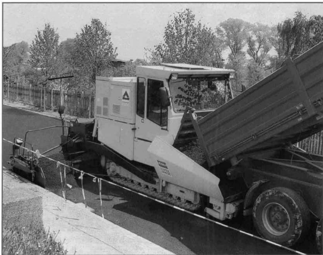
フェーゲル社製 電気式アスファルト フィニッシャ S-1800DE ヴィルトゲン・ジャパン株式会社
