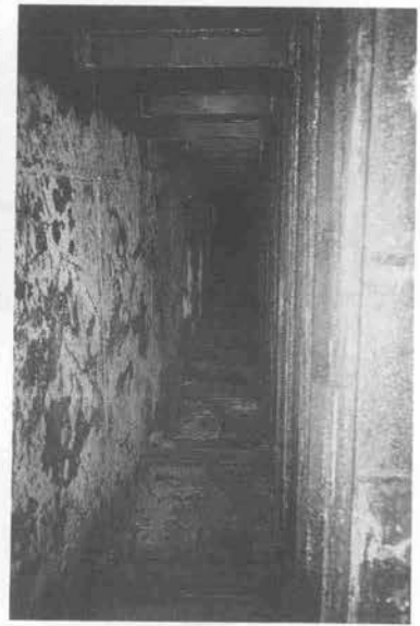
写真-10 接続部掘削完了全景
