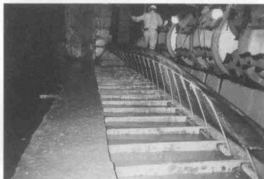
写真—1 エントランス倒れ防止ばね
