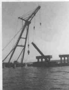
杭切断後の撤去
