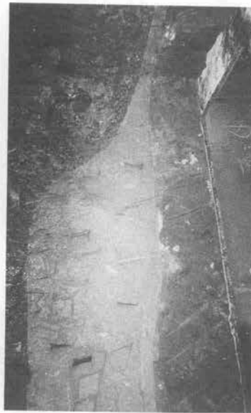
写真-9 接続部裏込め材充填状況
