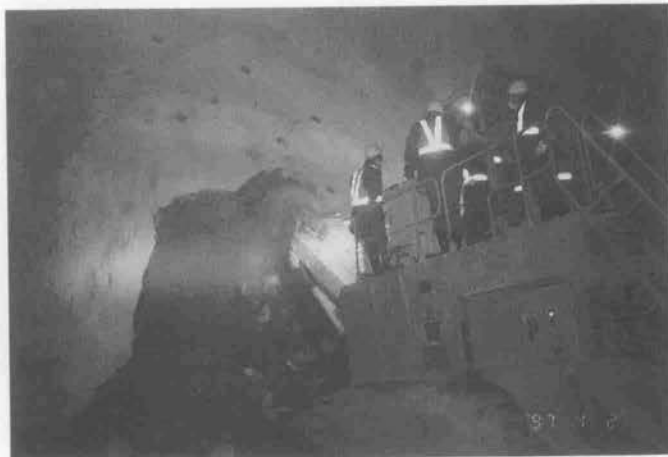
写真一 掘削状況
