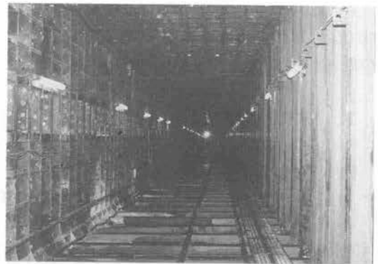
写真-3 一次覆工完了状況
