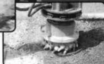
大型ロードカッタの路面接触部 切削残し部分のハツリ
