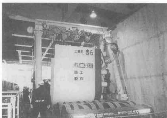
写真-2 シールド機投入状況
