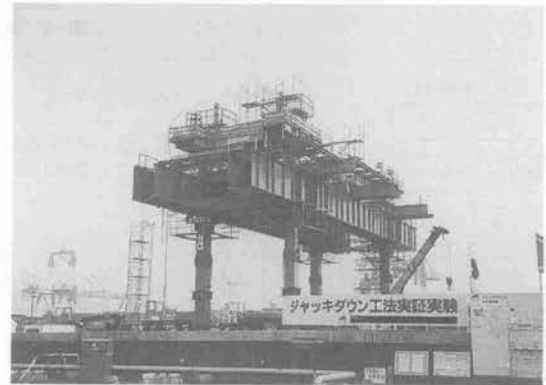
写真-1 ジャッキダウン工法実証実験
