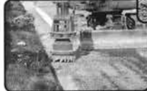
大型ロードカッタの道路端 切削残し部分のハツリ
