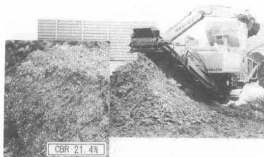
写真-2 リテラ工法: 混合むらなく均一に混ざっている
