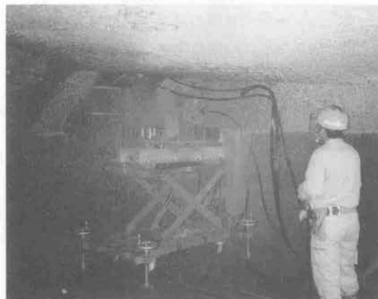
写真-4 人孔内での施工状況
