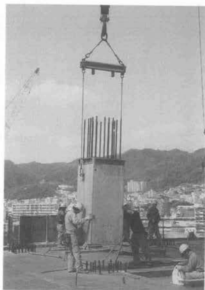
写真-4 柱PCセット状況
