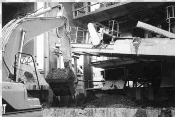
↑1次処理土と2次処理土の混合
