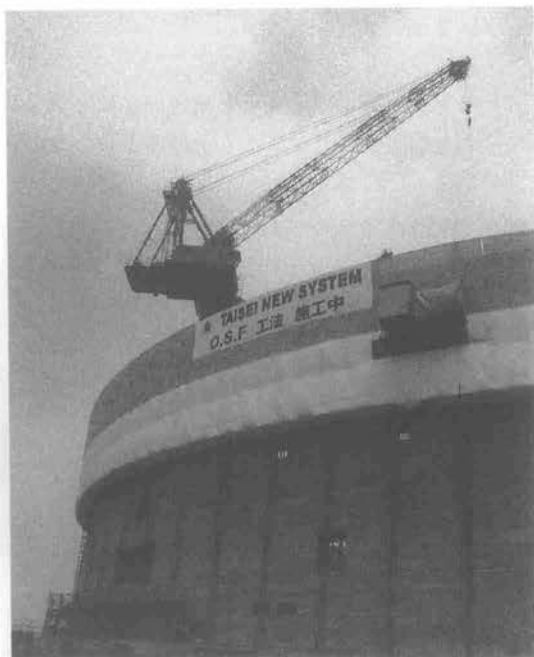
写真-1 OSF工法施工状況
