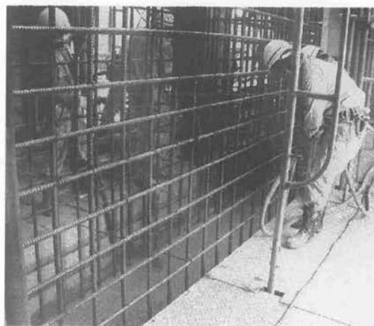
写真-6 コンクリート打設工事
