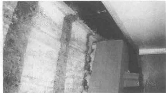
写真-2 SEW 壁の切削状況
