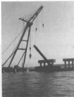
杭切断後の撤去
