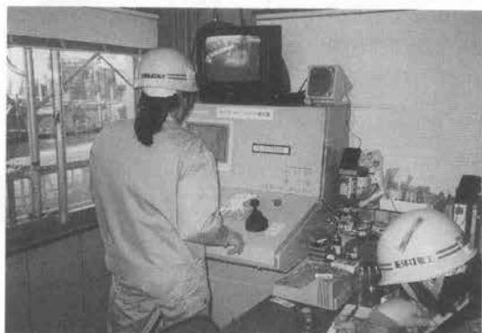
写真-8 貨物リフトオペレータールーム
