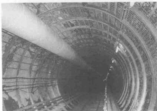
写真—1 TBM ロックライナー工法で施工した坑内の状況
