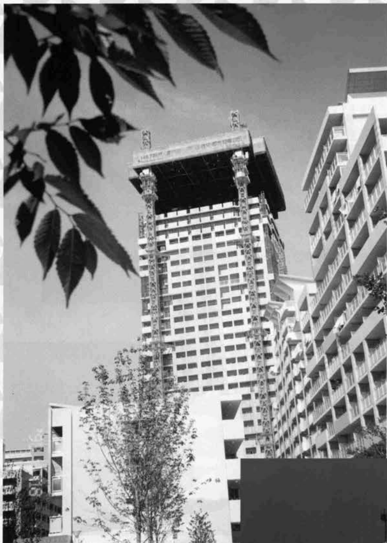
↑RC自動化建設システム —高層住宅の施工
