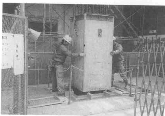
写真-9 貨物リフト搬送状況
