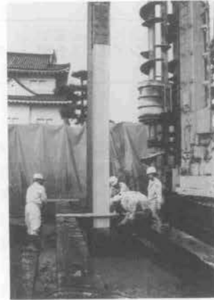
写真-1 SEW 壁の建込み状況
