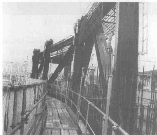
写真-4 先行鉄骨工事
