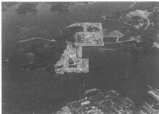
写真-1 橋湾発電所全景(北側より望む)
