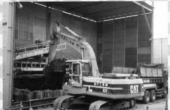
↑現場より搬出される改良土
