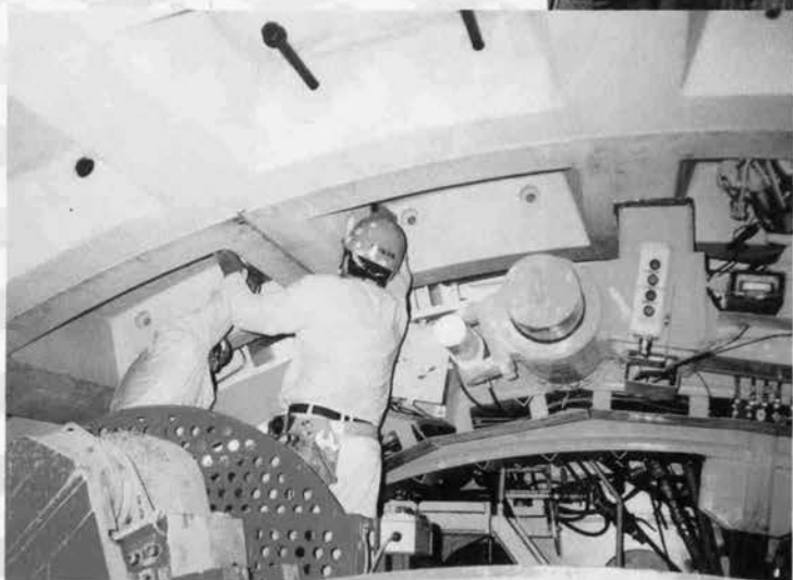
⇩セグメント組立状況
