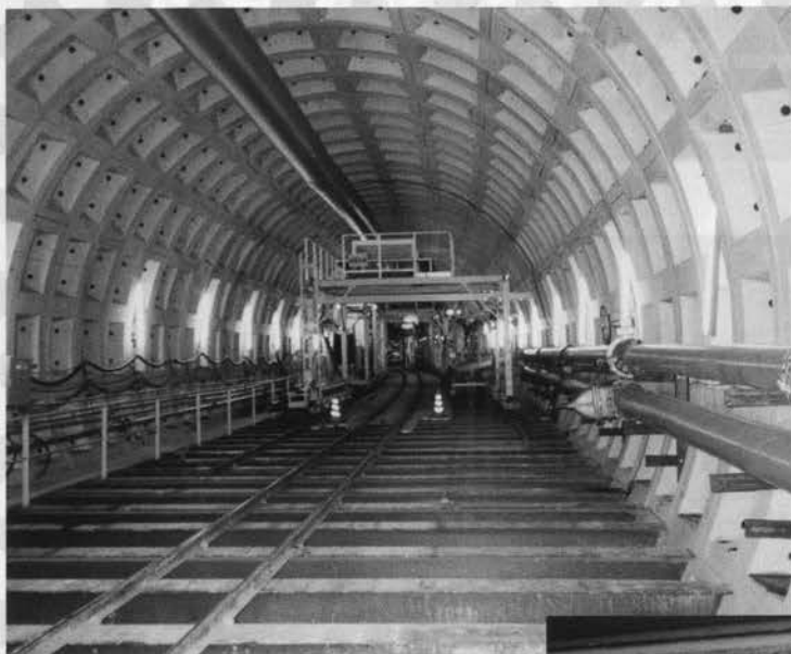
↑赤山トンネル坑内
