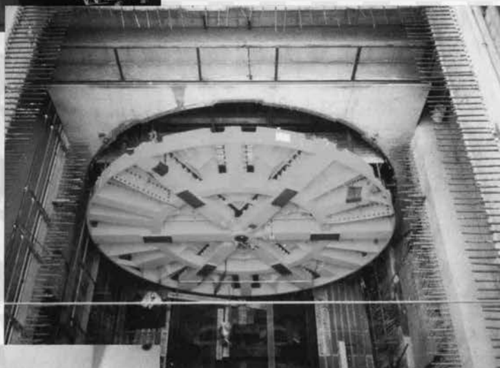
⇩シールド機現場組立状況
