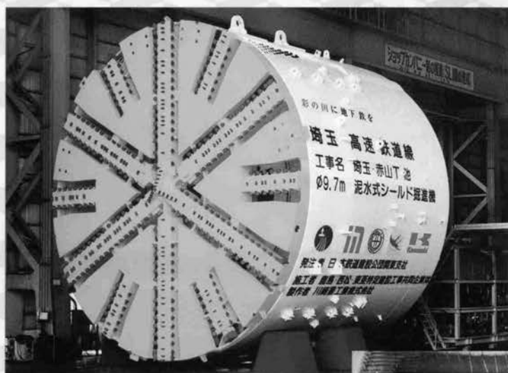
⇩シールド機工場完成
