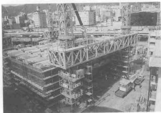
写真-5 屋根架構組立状況
