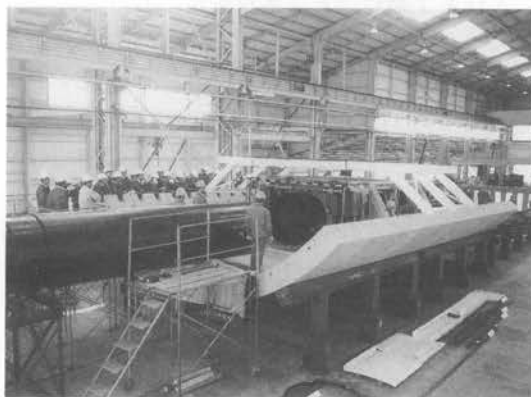
写真-1 導水管敷設装置公開実験
