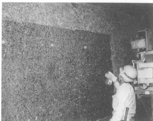
写真-5 除去された劣化コンクリート
