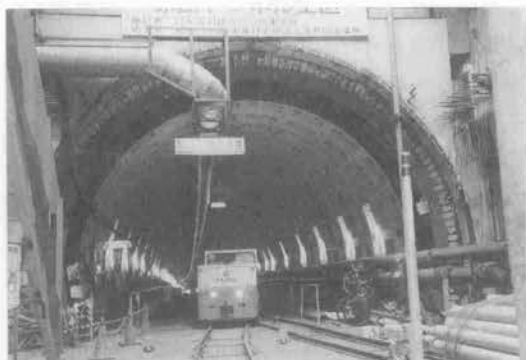
写真—2 掘進中の赤山トンネル坑口付近
