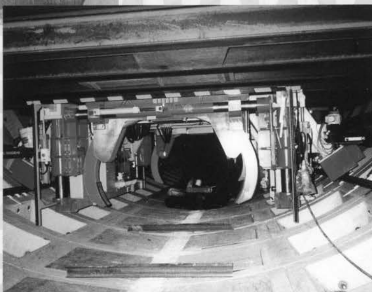
↑導水管敷設装置
