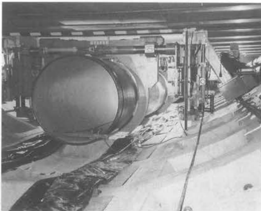
写真—3 導水管敷設状況
