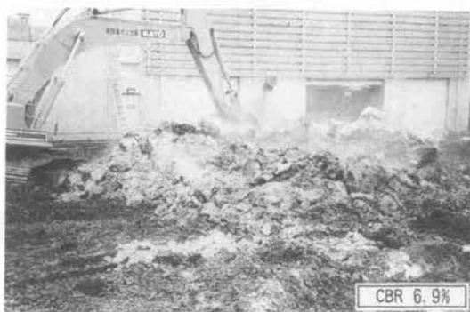
写真-3 油圧ショベル攪拌工法(従来工法): 粉塵が飛散し混合むら大
