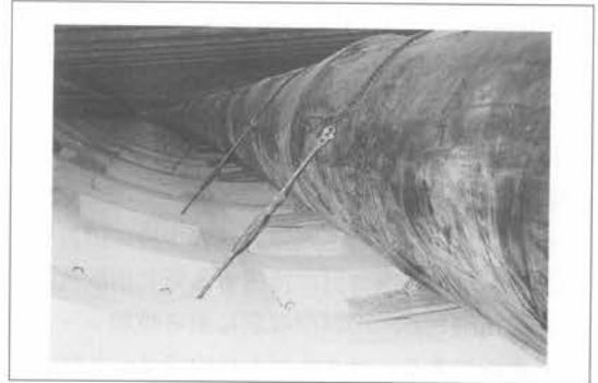
写真—4 導水管敷設完了状況
