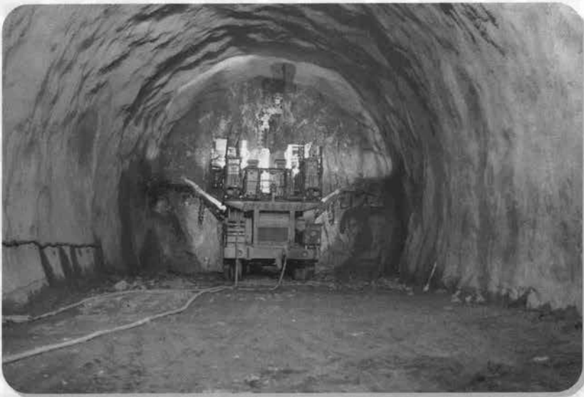
↑新親不知トンネル(西)切羽・ジャンボセット状況
