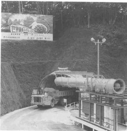
写真—3 火行工区斜路入口
