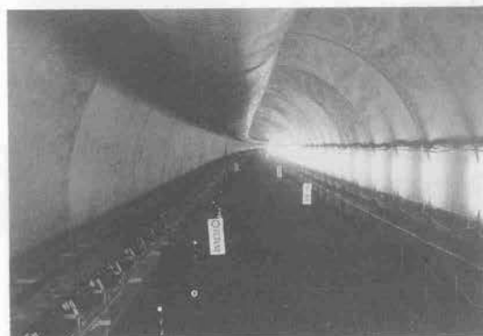
写真-7 覆工部吊り構造
