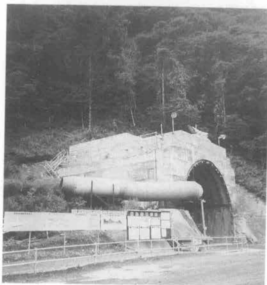
写真—6 鳥越工区坑口付近
