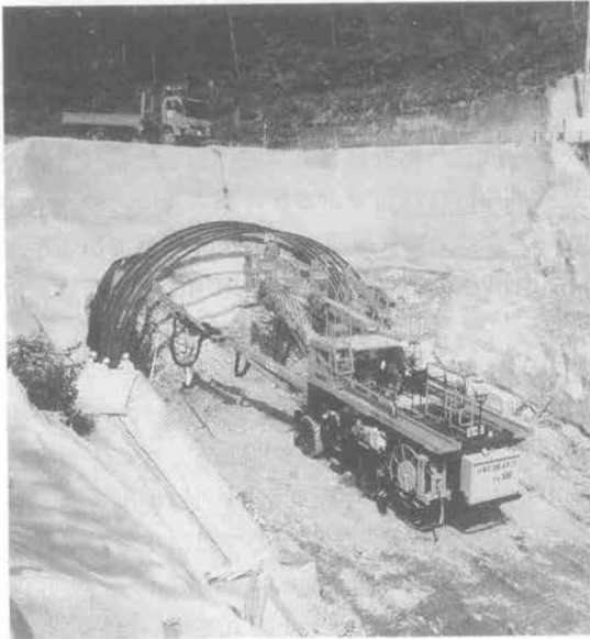
写真—1 御堂工区坑口付け
