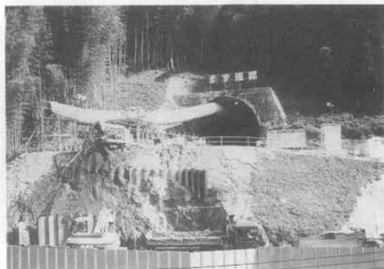
写真-2 坑口全景
