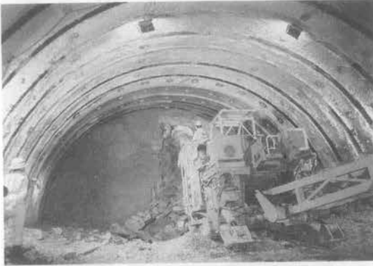
写真—4 女鹿工区本坑掘削状況
