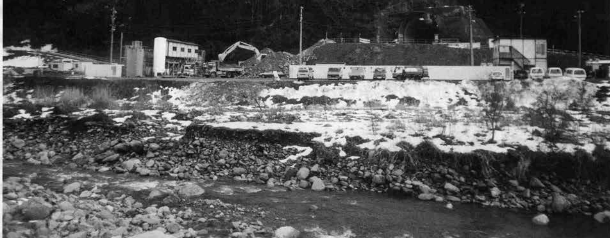
↑新親不知トンネル(西)坑口状況
