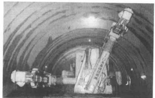
写真-1 トレヴィチューブ工法
