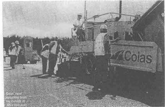
写真 TRAでの舗装テスト
