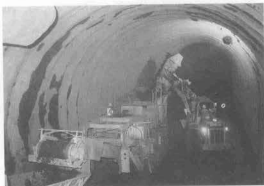
写真-1 ずり出し時切羽状況
