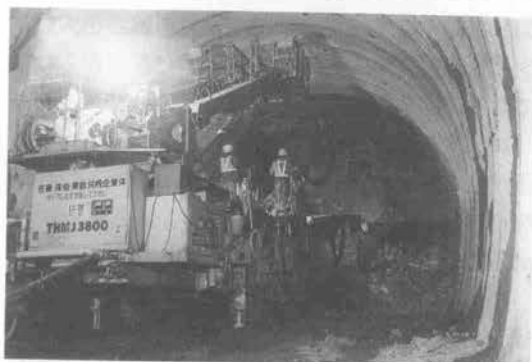
写真—5 鳥越工区本坑掘削状況
