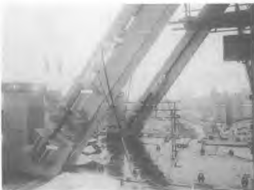
写真-4 張力導入時状況
