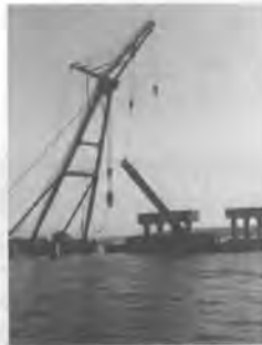
杭切断後の撤去
