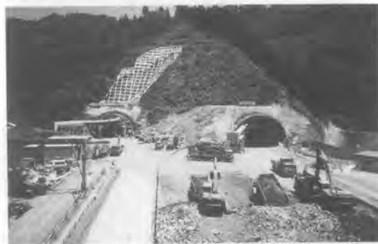
写真-1 清水第三トンネル工事の坑口全景
