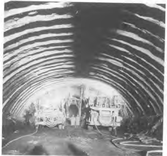
写真-2 坑内の状況
