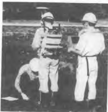
図-1 位置出し状況
