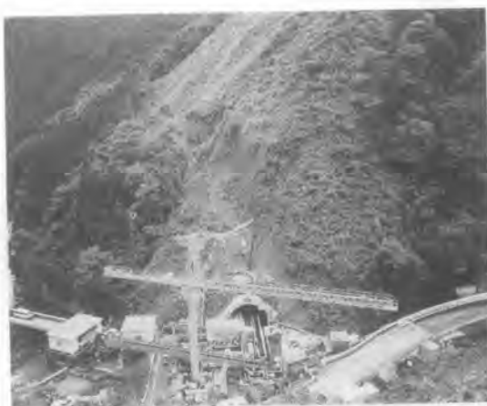
写真—3 富士川トンネル西工事の坑口全景
