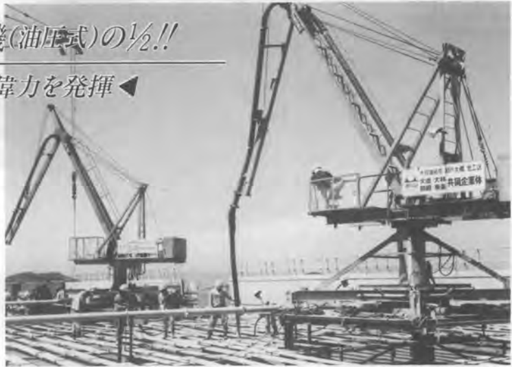
(本四架橋現場設置例)
