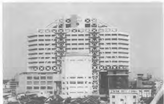
写真-3 B、C棟および既存建物
