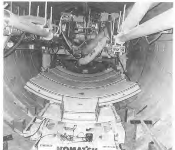
写真—3 セグメント供給装置
