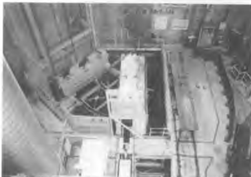
写真-2 立坑下設備
