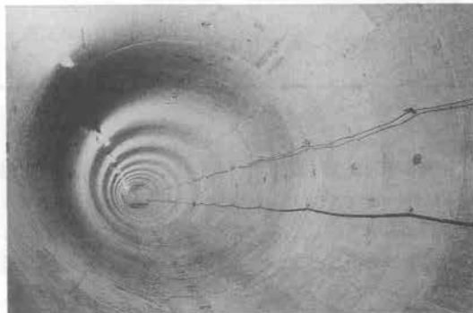
写真-1 セグメント内面
