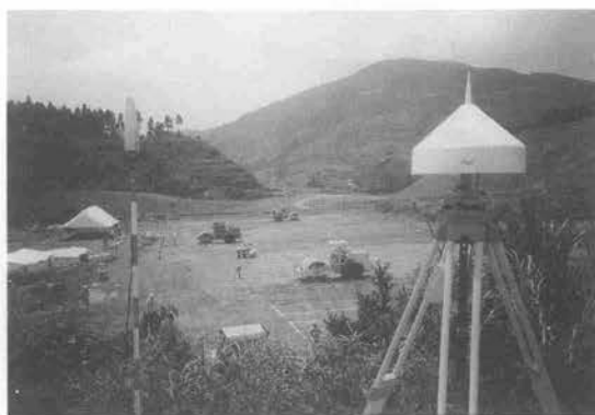
写真-1 試験施工状況 右がGPS受信機、左は誤差補正のため振動ローラへデータを送信するためのアンテナ
