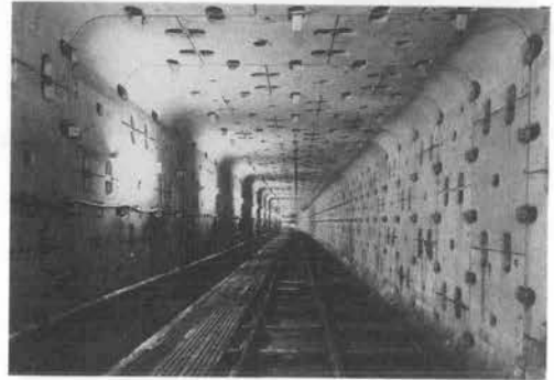
写真2 坑内状況(一次覆工終了)
