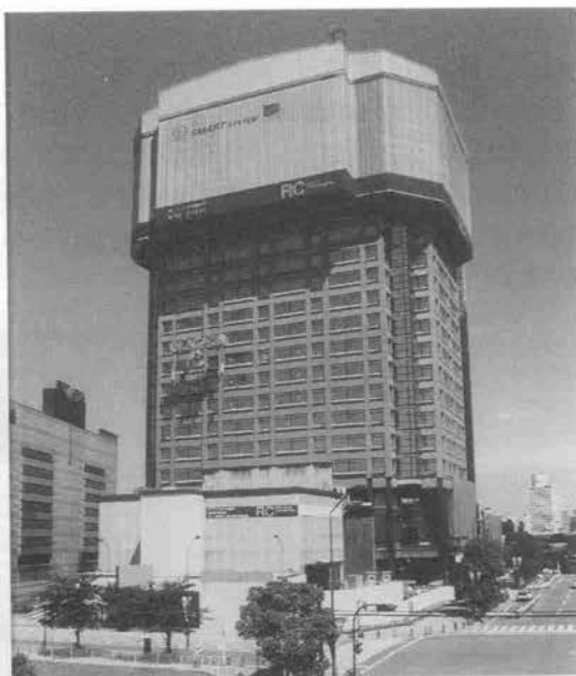
写真-1 ビル自動化施工システムの外観
