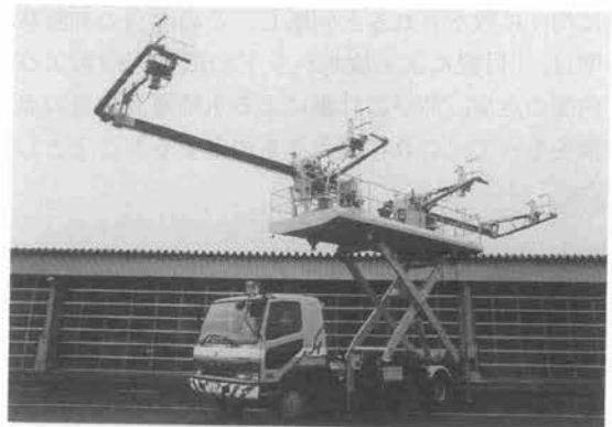
写真-2 水噴霧点検全景
