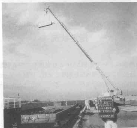
写真-1 実大規模の現場実験における撮影状況
