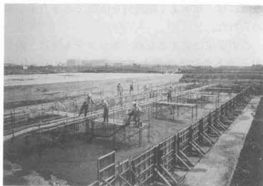
写真-6 打設状況
