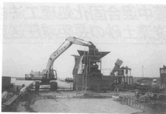
写真-1 圧送機への土砂投入状況
