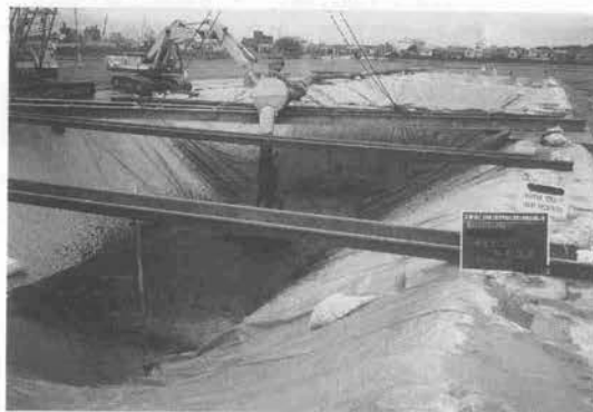
写真-2 土砂の吐出状況
