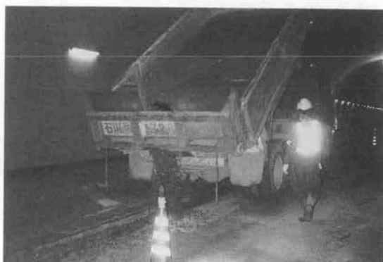
写真-5 Cトンネルでの埋戻し材投入状況
