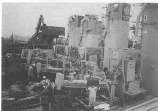
写真-5 SGM プラント
