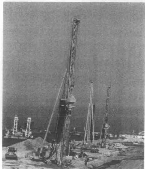
写真—1 施工状況（テラシステム）
