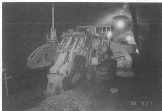
写真-4 トレンチャ坑内掘削状況
