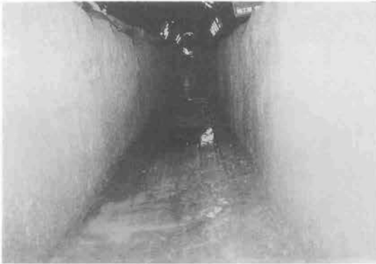
写真-3 掘削形状
