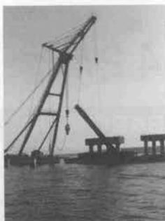
杭切断後の撤去
