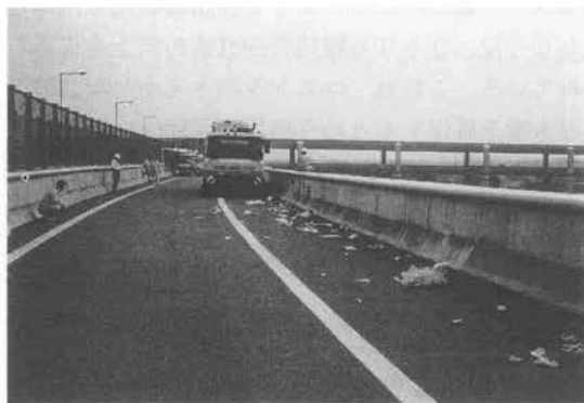
写真-1 JCT 試験状況
