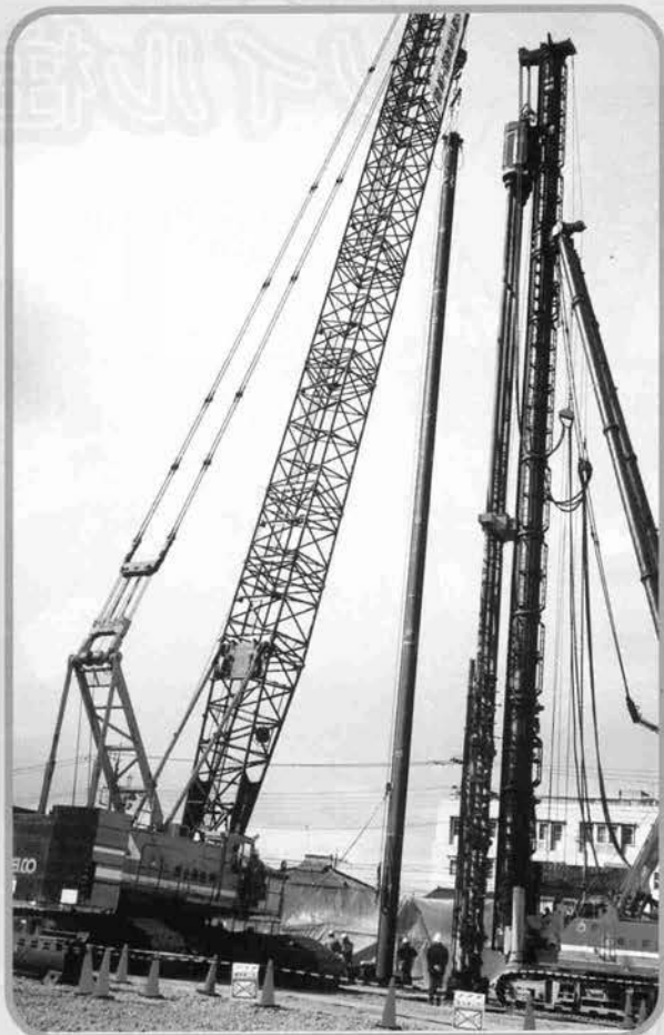
↑鋼管矢板建込み工
