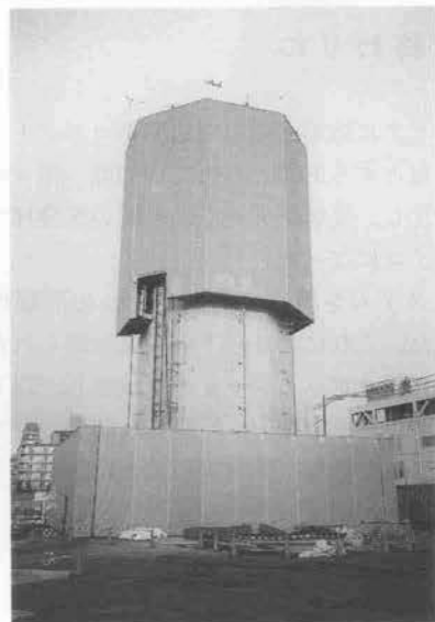
写真-1 初期の施工状況
