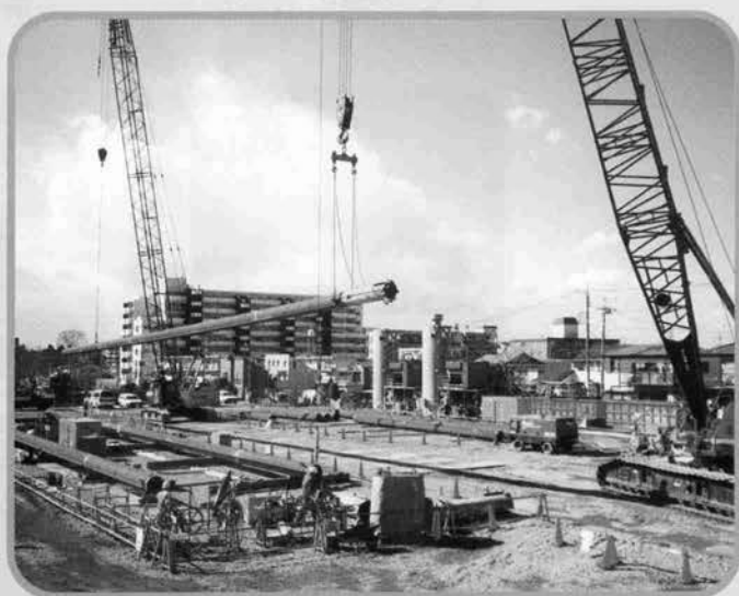
↑クローラークレン合吊りによる鋼管矢板位置決め
