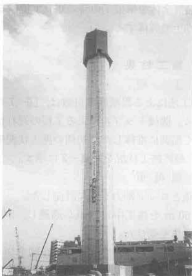
写真-2 最終施工状況
