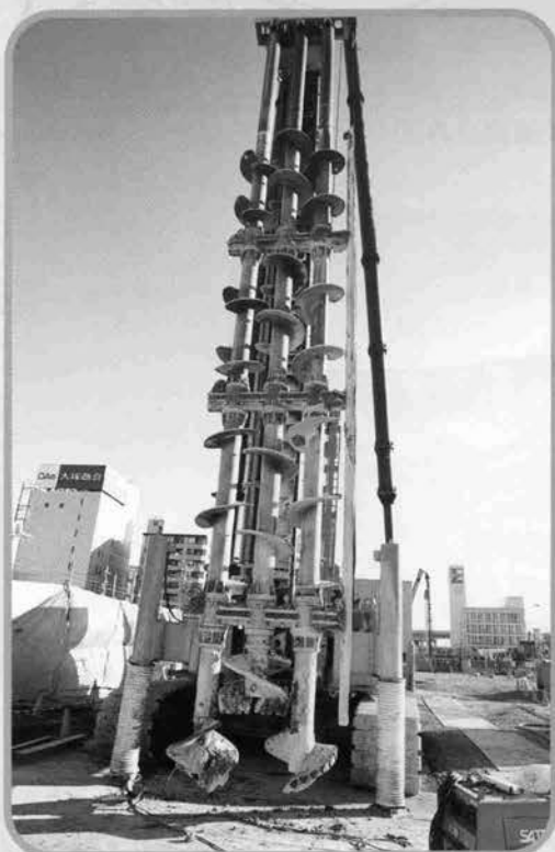
↑スタビライザ付三軸削孔機
