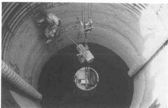
写真7 深礎杭坑内吹付け状況
