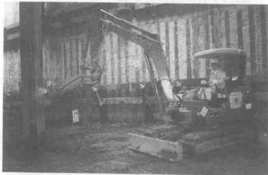
写真—4 構真柱ケレン機全景
