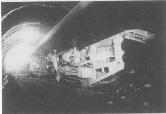
写真-12 連続コンベヤ搬出しシステム
