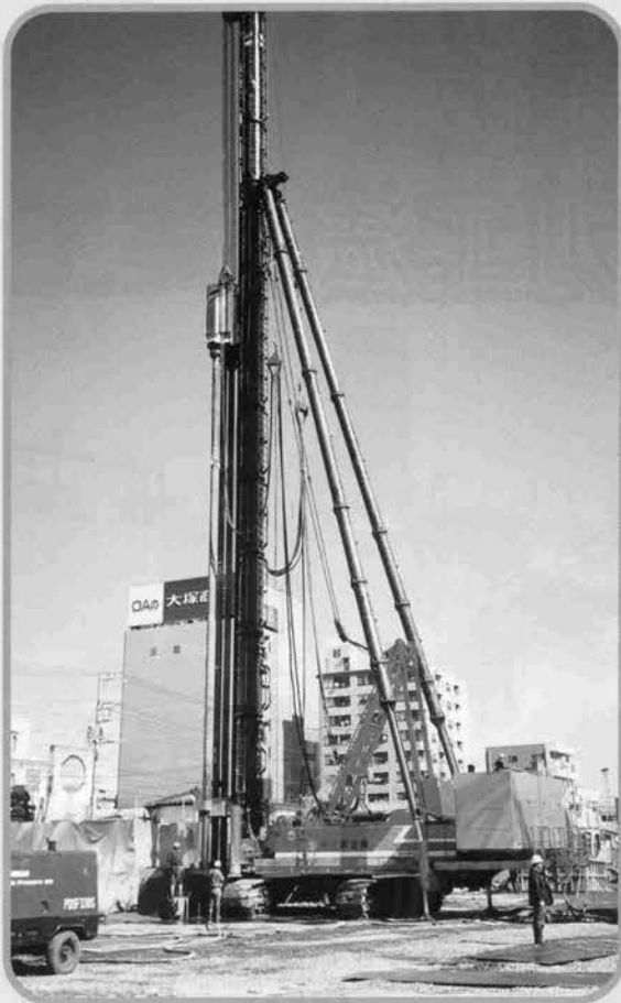
↑三軸オーガによる削孔工
