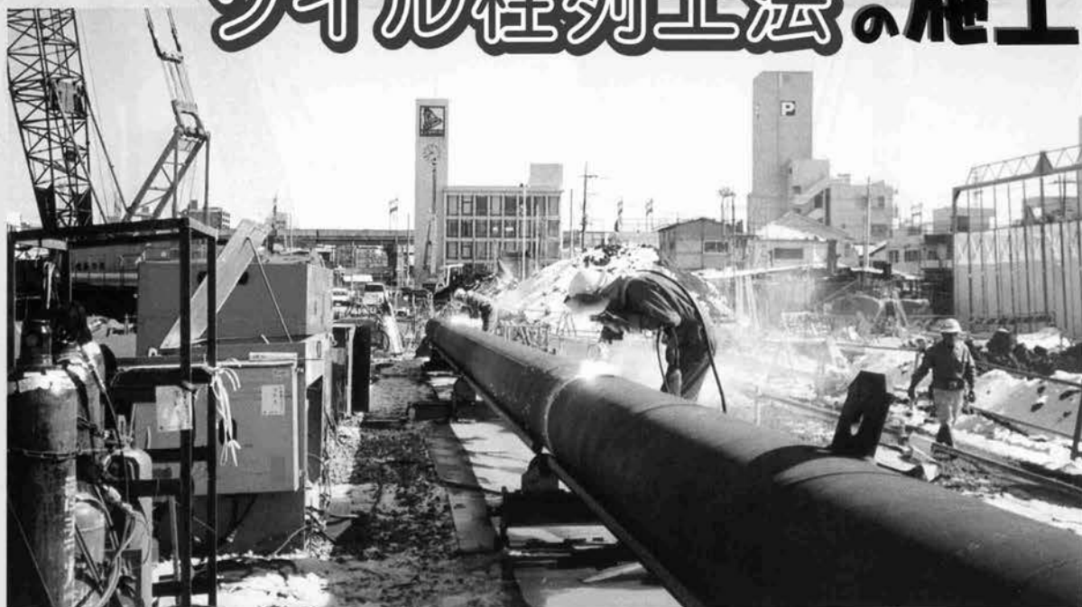
↑鋼管矢板の現場溶接による接合
