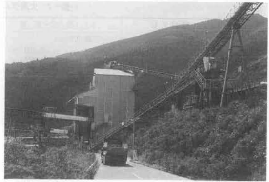
写真-3 2次破碎設備スクリーンタワー
