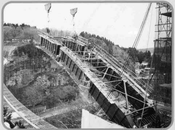
↑鋼管アーチ部架設状況
