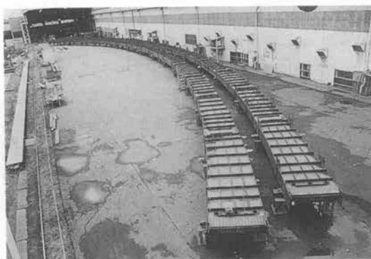
写真-2 鋼管アーチ部材平面仮組検査状況
