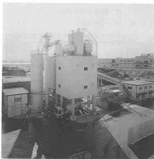
写真-3 新港プラント全景
