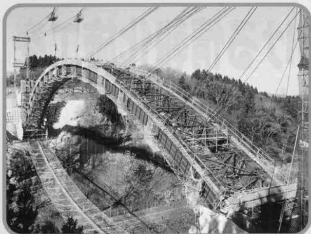
↑最終鋼管アーチ部材架設(鋼管アーチ閉合)
