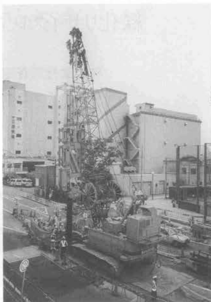
写真一1 施工状況
