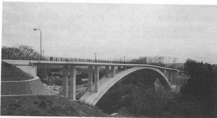
写真—1 完成した夢乃橋
