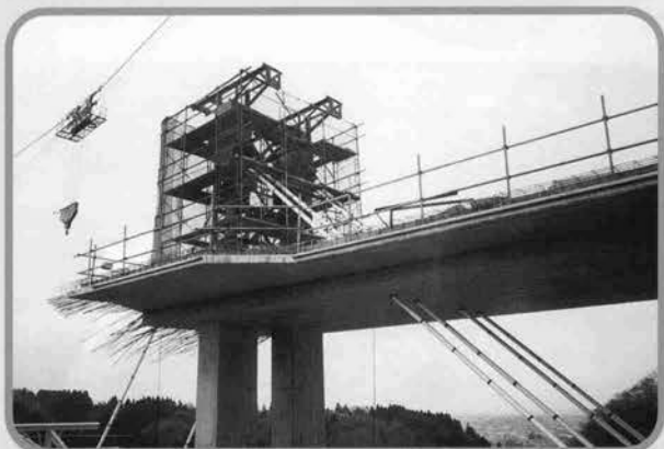
↑斜吊り用支柱及斜吊り機
