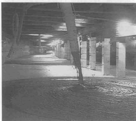
写真二 流動化処理土打設状況
