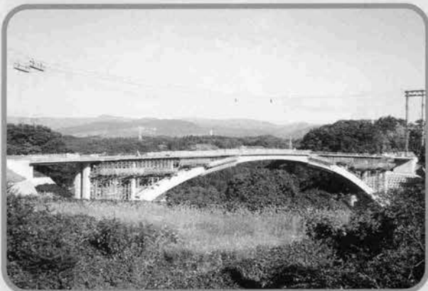
↑中央径間、補剛桁の施行状況
