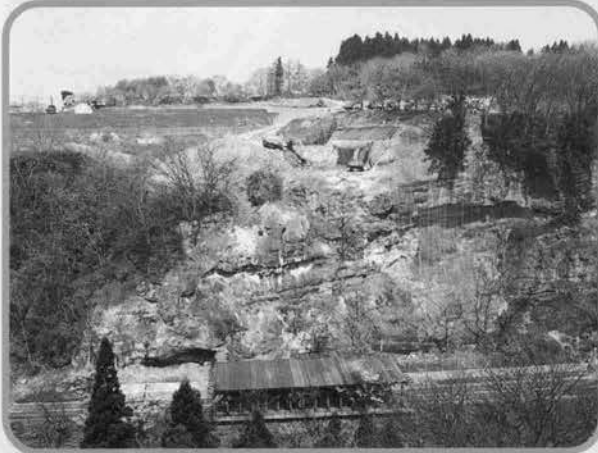
↑基礎掘削(右岸側)
