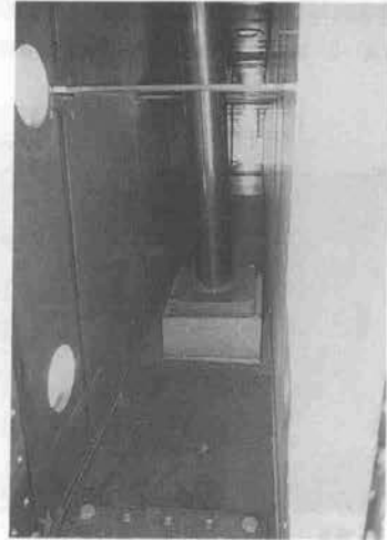
写真—7 斜吊り材定着部(鋼管アーチ部材内)
