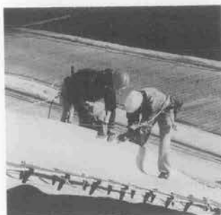
写真二 縫製接合状況
