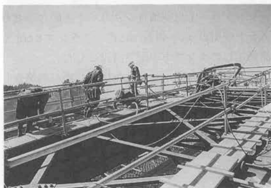
写真-5 充填コンクリート打設状況
