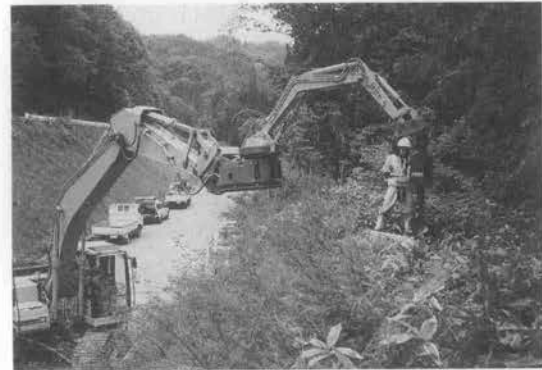
写真-3 境界杭設置工事
