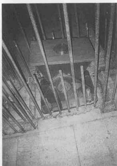
写真-4 鋼管アーチピン支持
