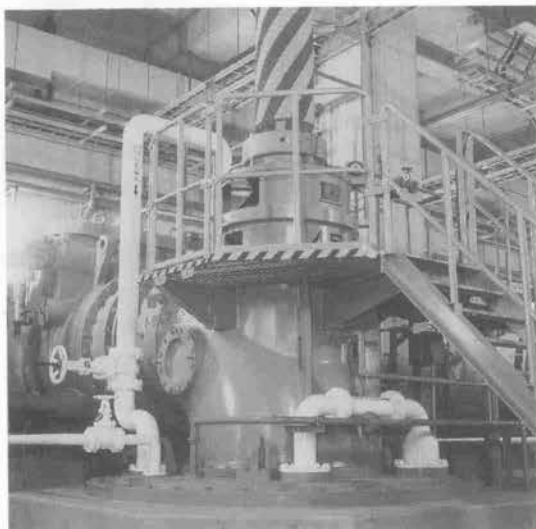
写真-1 下水道用立軸斜流雨水排水ポンプ(先行待機型)
