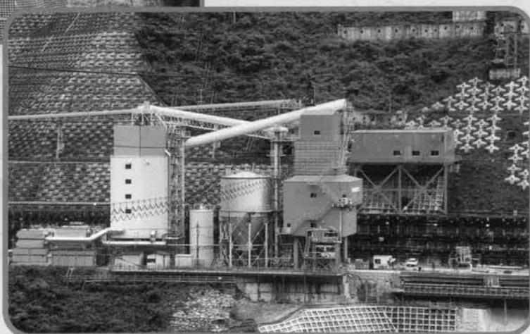
↑左岸天端バッチャ周辺
