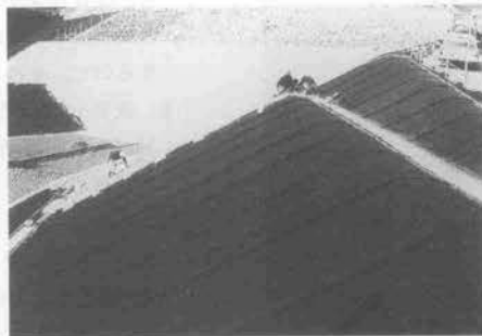
写真三 保護マット敷設状況
