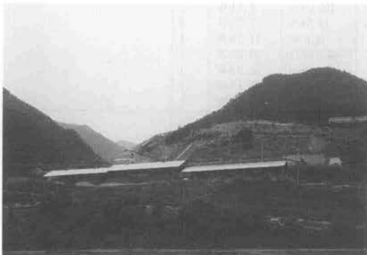
写真-2 2次破碎骨材プラント
