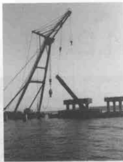
杭切断後の撤去
