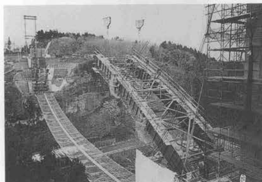
写真-3 鋼管アーチ部材架設状況
