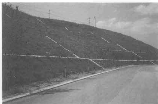
写真-2 植生状況（施工後1年2ヵ月）（立命館アジア太平洋大学設置事業に伴う造成工事）*
