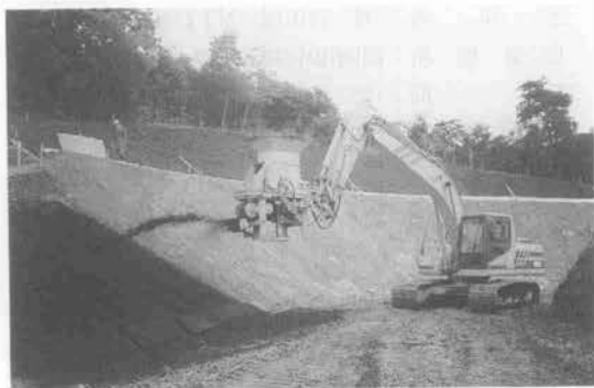
写真-1 専用装置による施工状況
