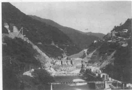
写真-1 ダムサイト（下流から）
