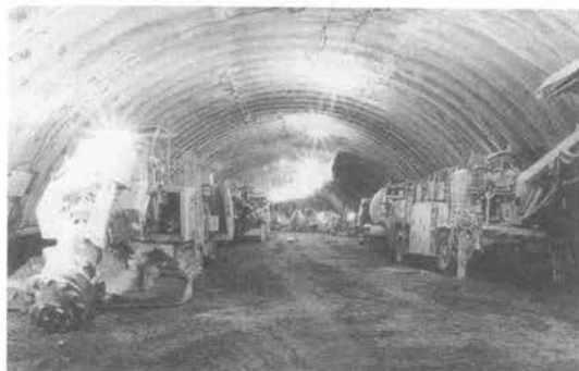
写真-3 Aトンネル上半掘削状況
