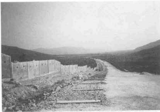
写真-5 中間カーブ部フレーム据付け状況
