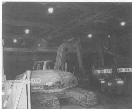
写真-1 防音ハウスに覆われたずり仮置き場
