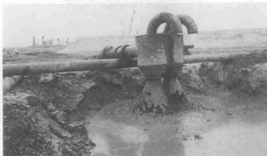
写真-1 打設状況
