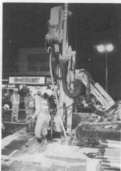
福岡市営地下鉄夜間工事現場で、 静かに活躍するECO-13V
