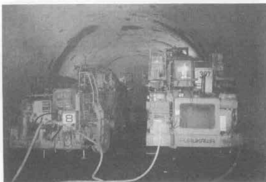
写真-1 削孔中での余掘り計測状況（右側の削岩機の後部）。計測値は事務所に自動送信
