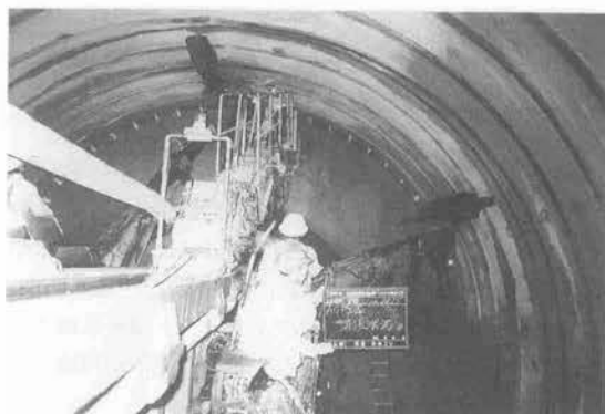
写真-1 施工写真
