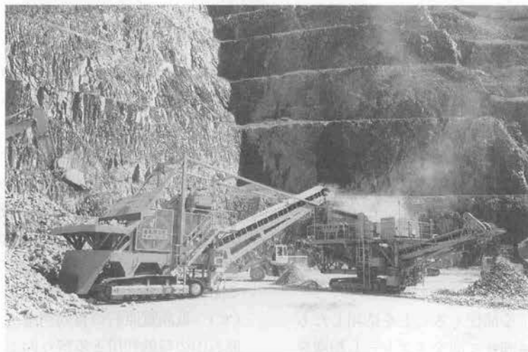
写真-4 自走式破碎設備例
