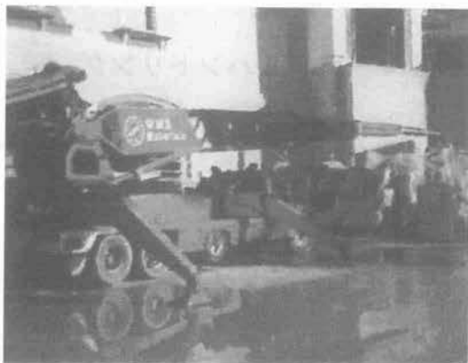
写真-1 ラスベガスのCSRが所有するブツマイスター・テルベルト社のTB 105は、水平距離 (horizontal reach) 105フィート、高さ58フィートの材料搬送 (discharge) ができる。
