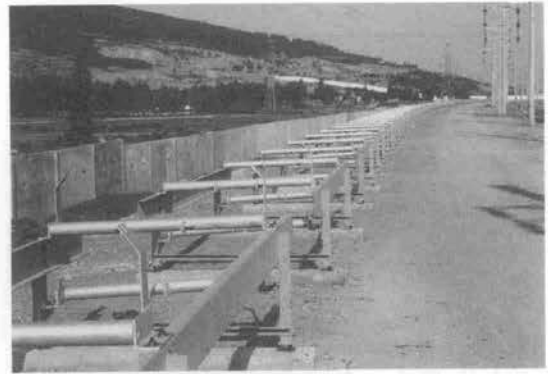
写真-6 中間カーブ部フレーム据付け状況
