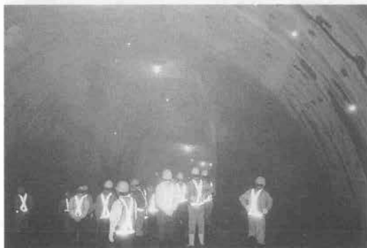
写真-2 中央導坑部見学風景
