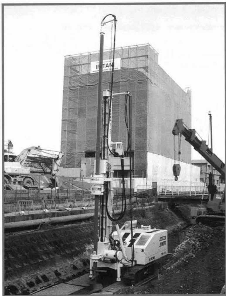
小型JST工法機アースキッズTSR-15型 三和機材株式会社
