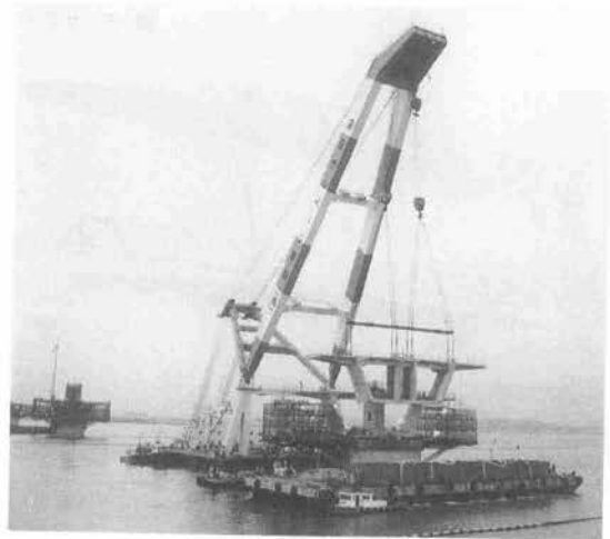
写真-10 柱頭部セグメントの架設
