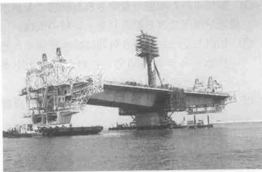
写真-11 標準部セグメントの架設
