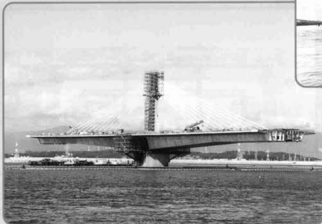
↑張出し架設完了後の状況(揖斐川橋 P2橋脚)
