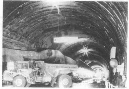
写真—4 ずり運搬状況 (摺糖工区)
