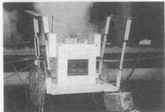
写真-4 坑内ステーション
