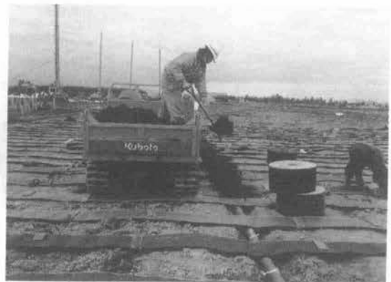
写真-1 水平ドレーン・有孔集水管敷設
