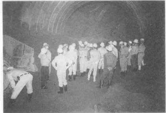
写真-1 御堂工区切羽
