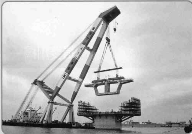
↑柱頭部セグメントの架設(木曾川橋 P3橋脚)
