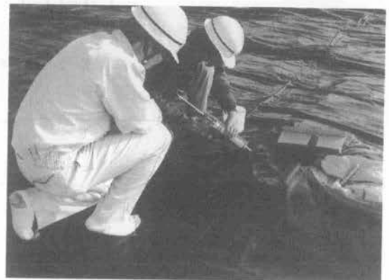
写真-2 気密シートの現地接合
