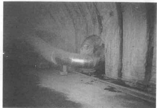
写真—6 坑内 \phi 1,700 mm換気立坑 (御堂工区)
