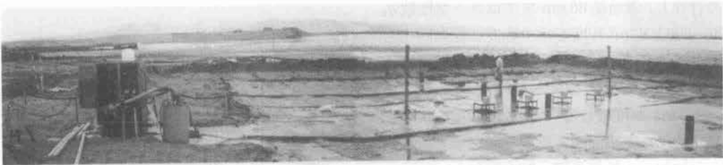
写真-4 真空圧密工
