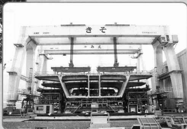
⇧セグメントの運搬(ヤード内)
