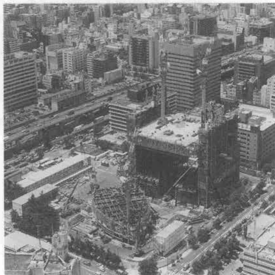
写真-4 高層部鉄骨およびBKホール鉄骨建方状況
