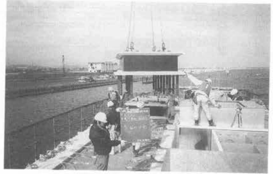
写真-9 支承の据付け
