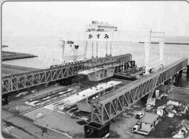
↑セグメントの運搬(栈橋部)
