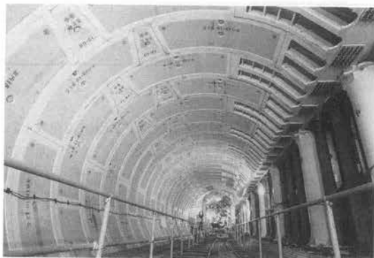
写真—2 施工状況（下段シールド）
