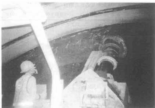
写真—5 NARAI システムによる掘削状況
