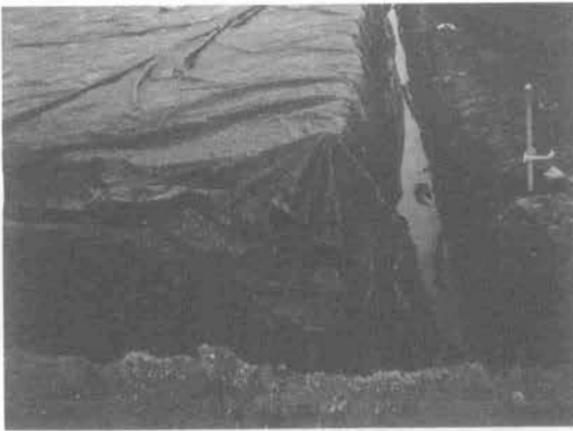
(a) 端部の気密シート敷設状況
