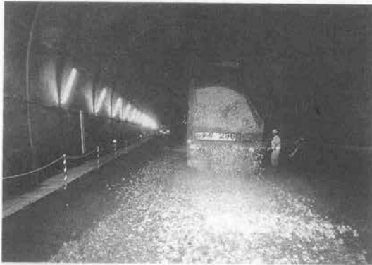
写真—3 路盤整備状況
