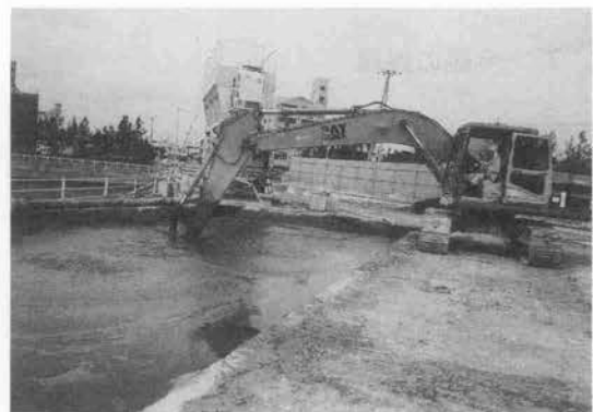
写真-7 土質改良状況
