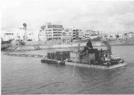
写真-1 浚渫船全体
