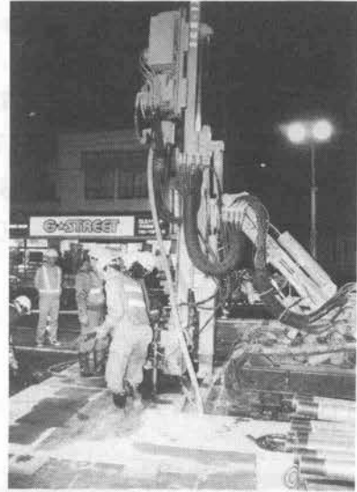
福岡市営地下鉄夜間工事現場で、 静かに活躍するECO-13V
