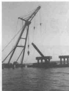
杭切断後の撤去
