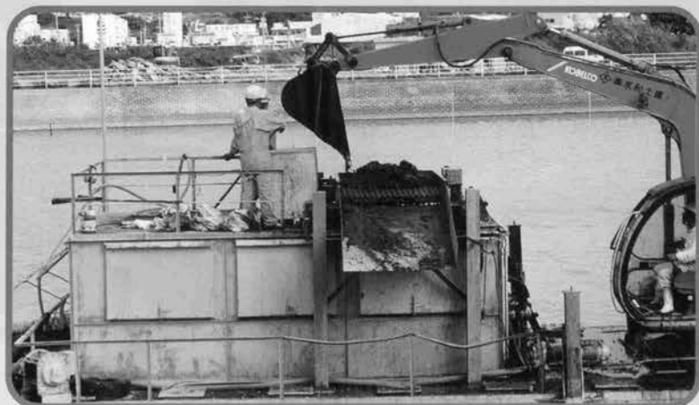
↑ 動力用台船 4.8m×7.2m×0.9m 高濃度浚渫用台船 4.8m×9.6m×1.0m
