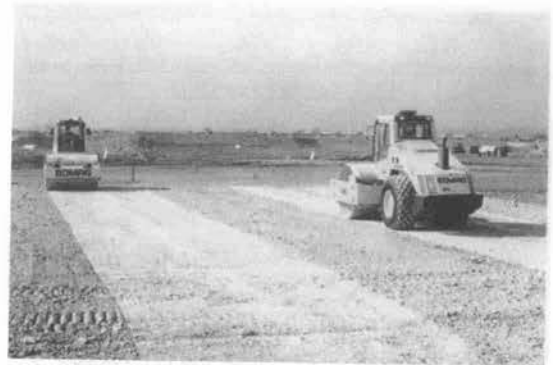
写真-1 施工写真
