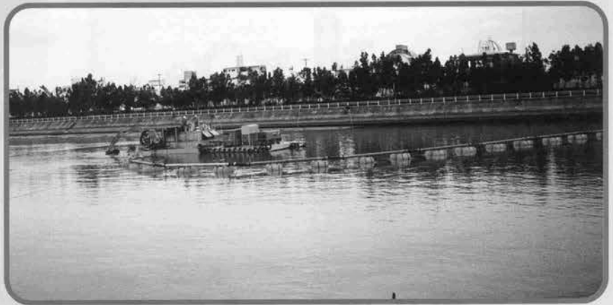
↑水上排泥管φ200 施工状況全景
