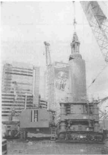
写真-3 掘削圧入作業時の状況
