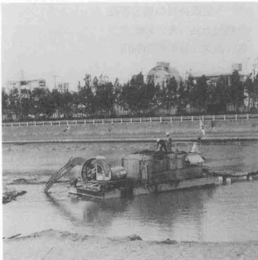
写真-5 工事施工状況
