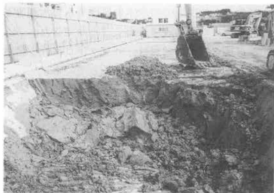
写真-8 土質改良土
