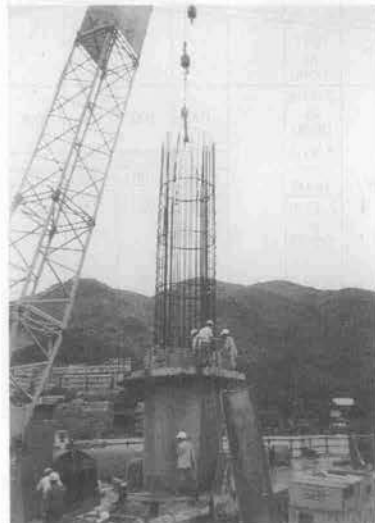
写真-5 鉄筋かご建込み状況
