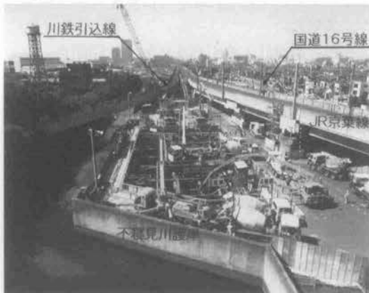
写真-1 現場全景(底盤1ロットのコンクリート打設状況)
