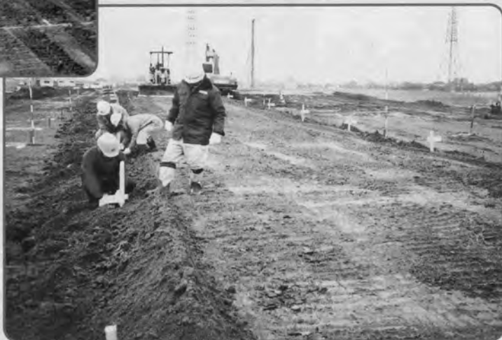
↑参考、従来施工(オペレータ操作)の結果 (両端に丁張りを設置して施工)
