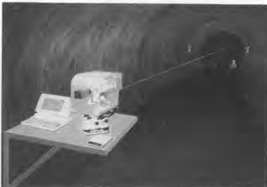
図-2 トンネル三次元マーキングシステム
