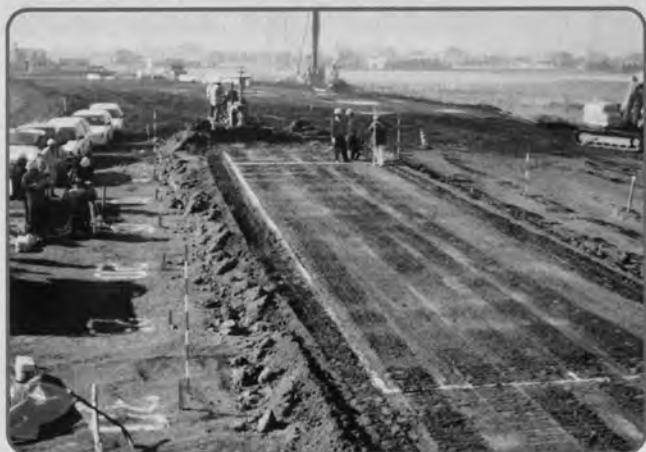
↑実証実験結果 (両端に丁張りを設置しなくても、十分に精度が確保された)
