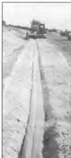
写真-2 施工状況写真
