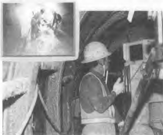
写真-2 コンクリート打設状況を見ながらポンプを操作
