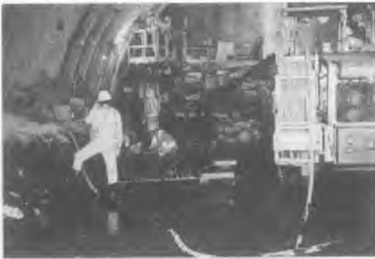
写真-1 トンネル内でのPHSの利用状況
