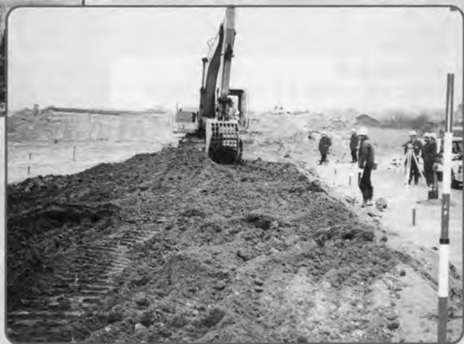
⇩ バックホウによる事前の荒造成地盤
