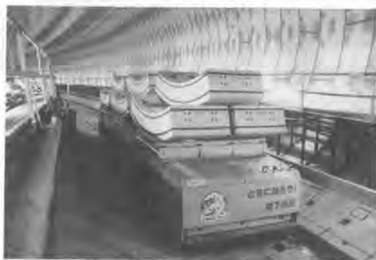
写真1 タイヤ式セグメント搬送車走行状況（外郭放水路）
