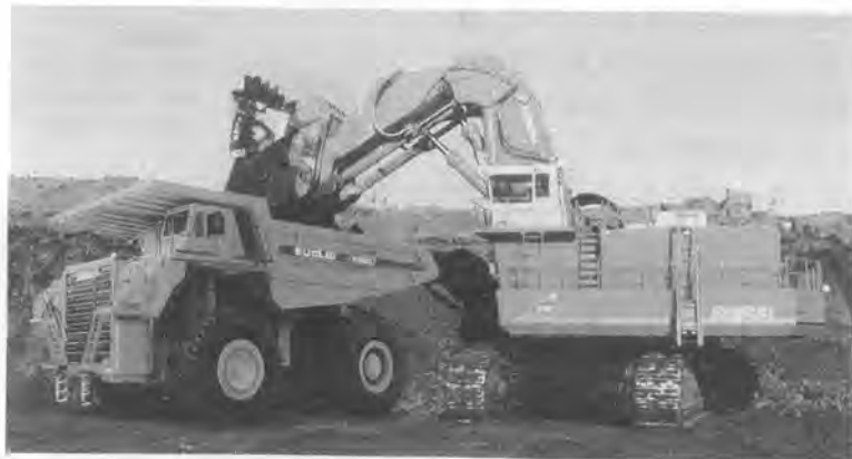
写真-1 超大型油圧ショベルの稼働状況
