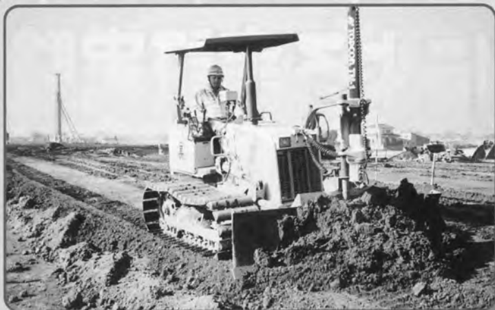
↑実証実験状況① (3次元マシンコントロールシステムによる敷均し)
