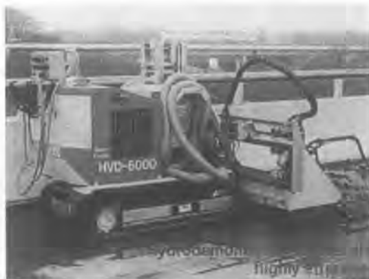
写真-2 Svensk Vattenblningsteknikのアクアジェット機 HVD-6000
