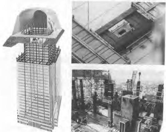
図-3 鉄骨位置決めシステム
