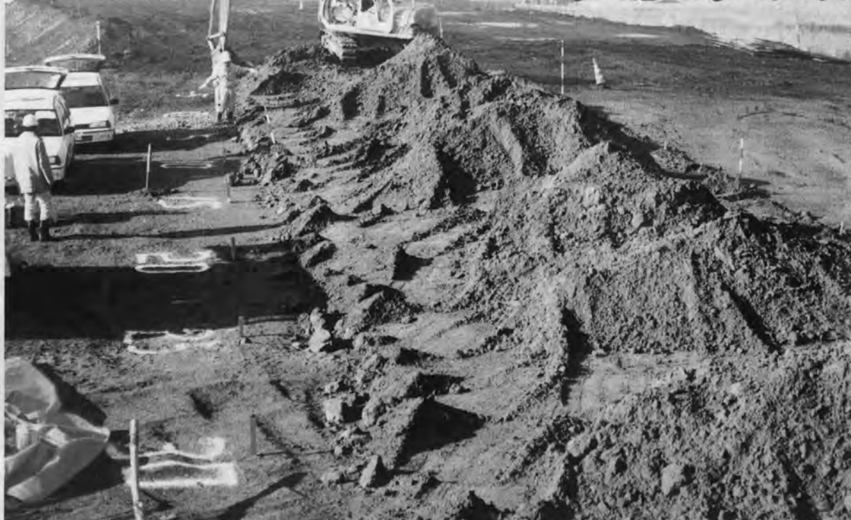
⇩ 敷均し前の土砂仮置状況（情報化施工では丁張りを設置しない）
