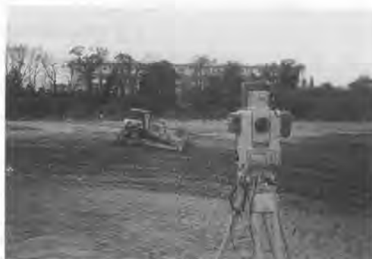
写真-1 盛土施工管理システム稼働状況
