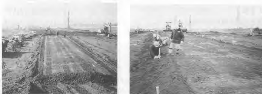
写真二 施工後の路面状況 (左：情報化施工；右：従来工法)
