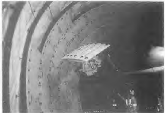
写真一 施工状況（施工完了）
