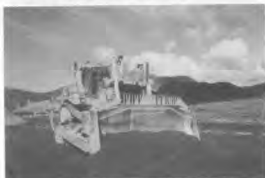
写真-1 施工状況
