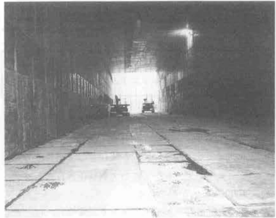
写真-2 MMST トンネル
