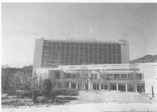
写真-6 2工区全景-2
