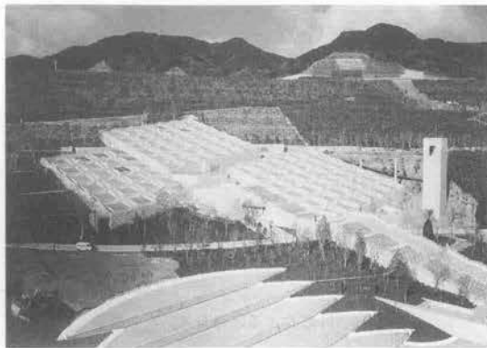
写真-8 3工区全景-2
