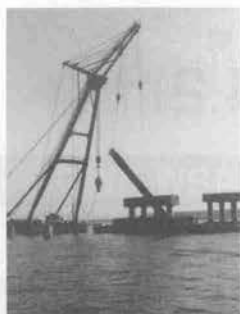
杭切断後の撤去
