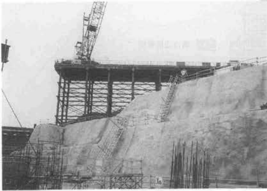
写真一 山側斜面部に設置した構台
