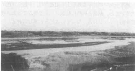
写真-2 大気圧工法により水深を確保した状況
