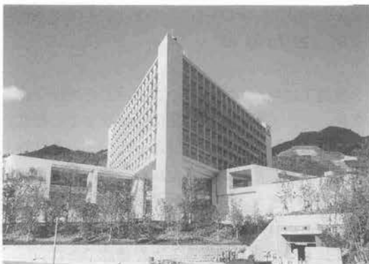
写真-5 2工区全景-1
