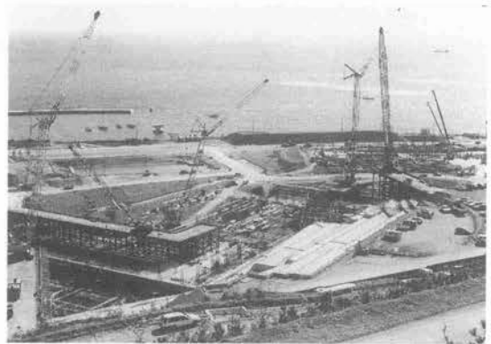
写真四 2 工区構台設置状況
