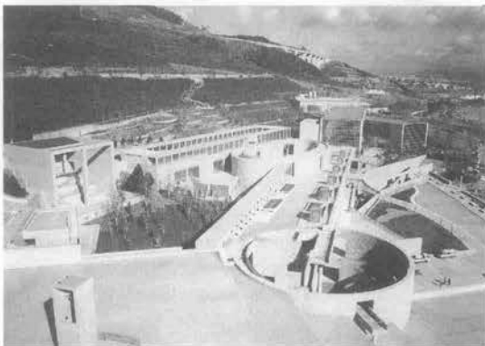
写真-7 3工区全景-1
