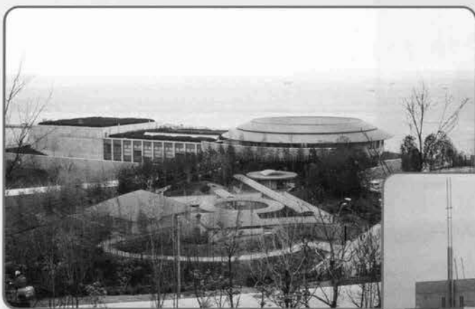
↑国際会議場棟(1工区)
