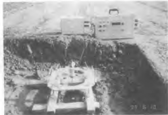
写真一 水位計測装置の設置状況
