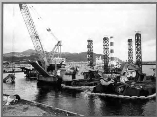
↑海底掘削用クラブ船及びスパット台船
