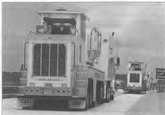
写真—5 6 ft幅のSKIDABRADERはコンクリート橋舗装表面処理を施す
