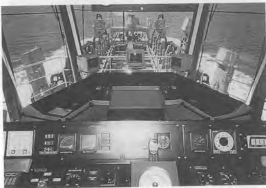
写真-4 浚渫操作盤
