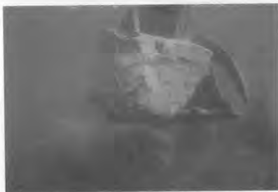
写真—3 被覆石均し状況
