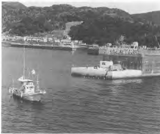
写真-1 施工概況（動力ユニット設置状況）
