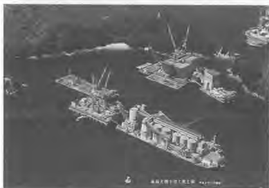
写真-4 来島大橋東工事全域航空写真
