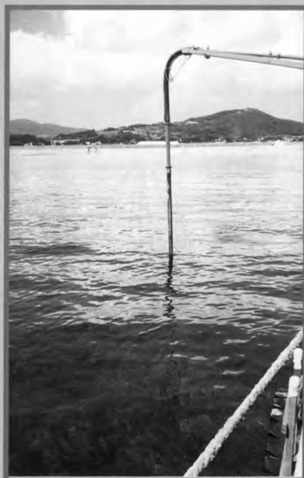
↑深層水取管ファブリコンクリート打設 (海の濁りは始どなし)
