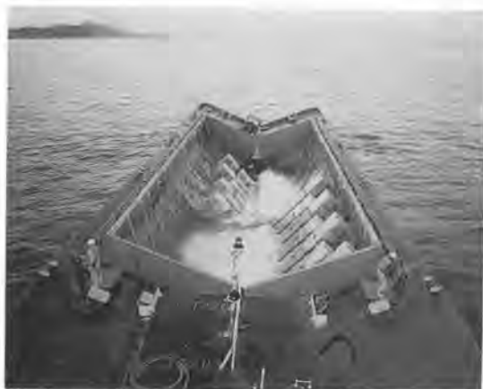
写真-3 バージ船からのブロックの投下状況
