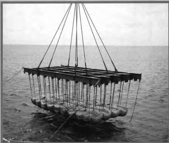
↑ ファブリコンクリートの設置状況 (10m×5m×60cm)
