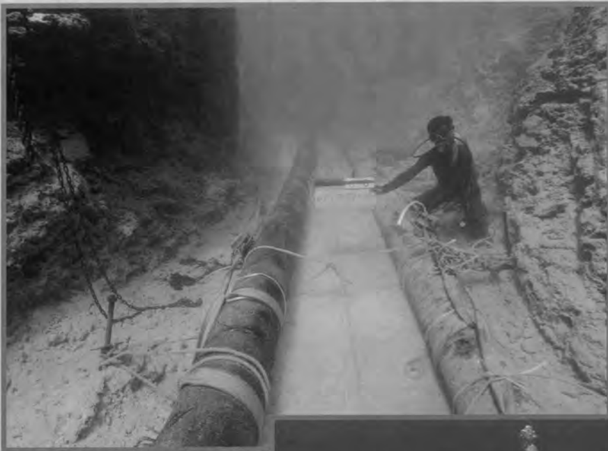
↑ トレンチ内の管敷設状況
