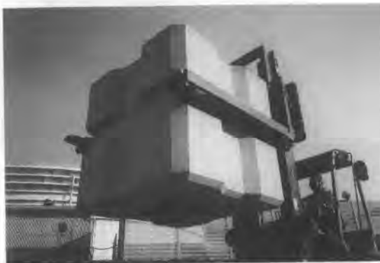
写真-2 アッシュクリートブロックの概要 (1.6×1.6×1.6m) -フォークリフトによる横持ち状況-
