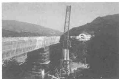
写真-6 P2橋脚部回転状況
