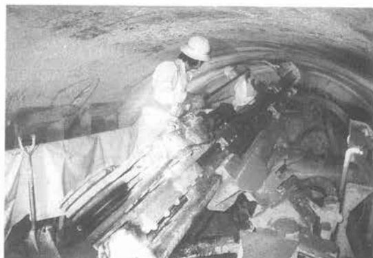
写真-4 削孔検層
