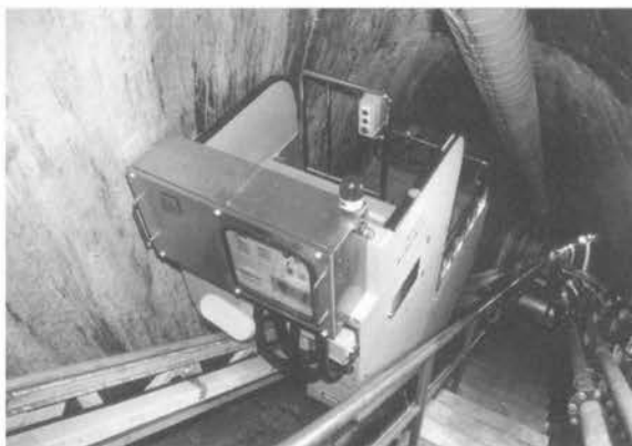
東京電力(株) 七倉ダム監査廊
