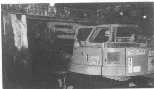
写真—4 地下鉄12号線建設現場とPG75
