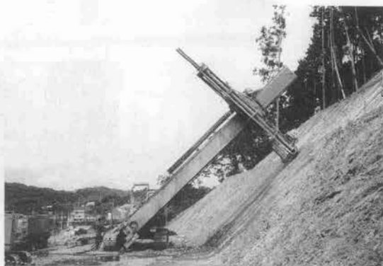
写真-1 稼働中のロックボルトセッタ
