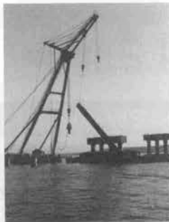
杭切断後の撤去
