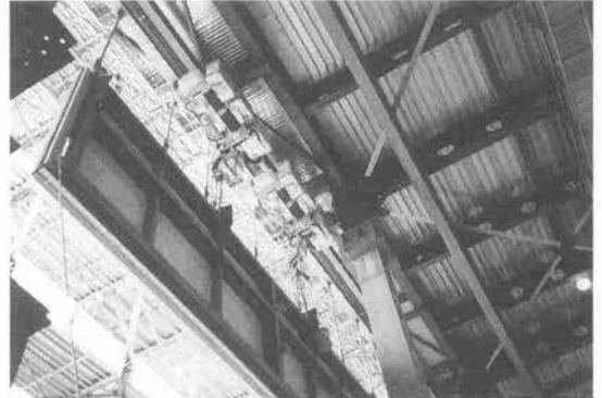
写真-5 大型外装材搬送中の4.8t+4.8tホイスト
