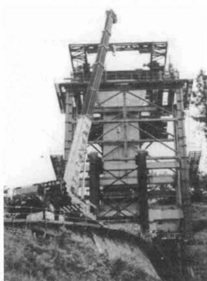
写真—8 ガイドタワー、地組立て
