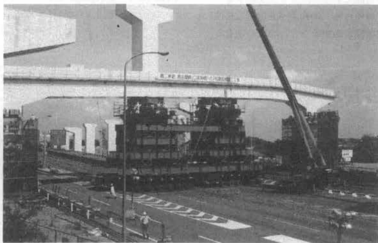
写真-1 一括架設工事状況
