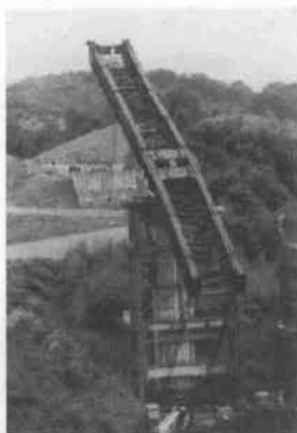
写真-5 P1橋脚部回転状況
