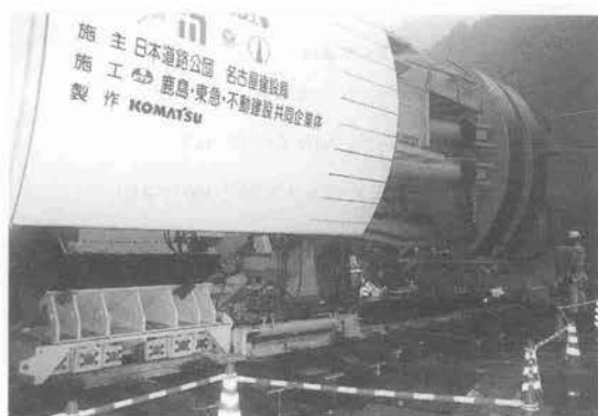
写真-3 TBM 引込み台車、ジャッキ
