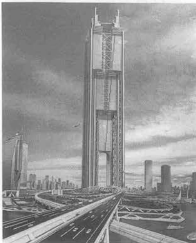
ステップオーバータワーの景観 (清水建設提供)
