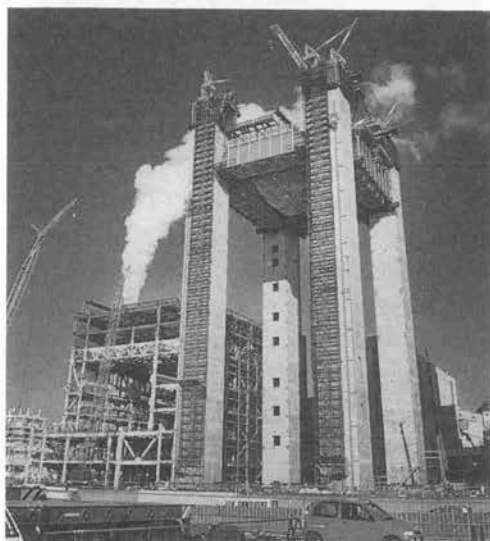
写真-1 リフトアップ状況
