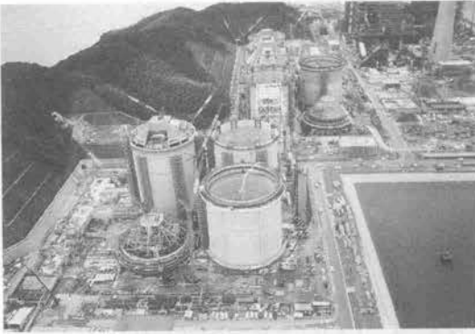
写真-3 施工状況
