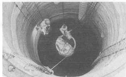
写真-1 モルタルライニング土留め
