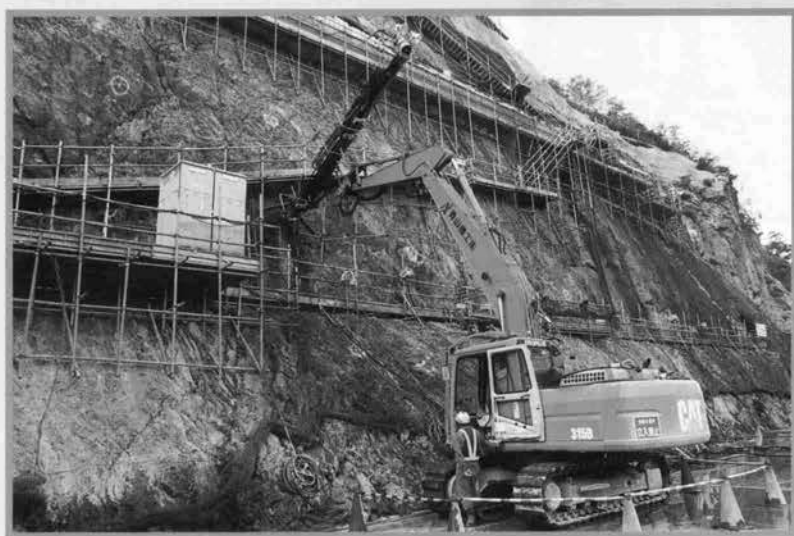
↑高所ボーリングマシン
