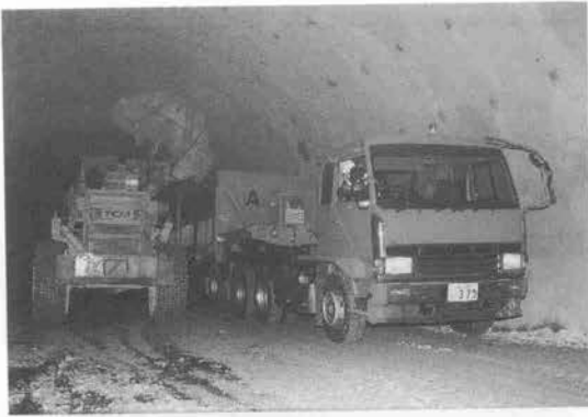
写真-2 積み込み
