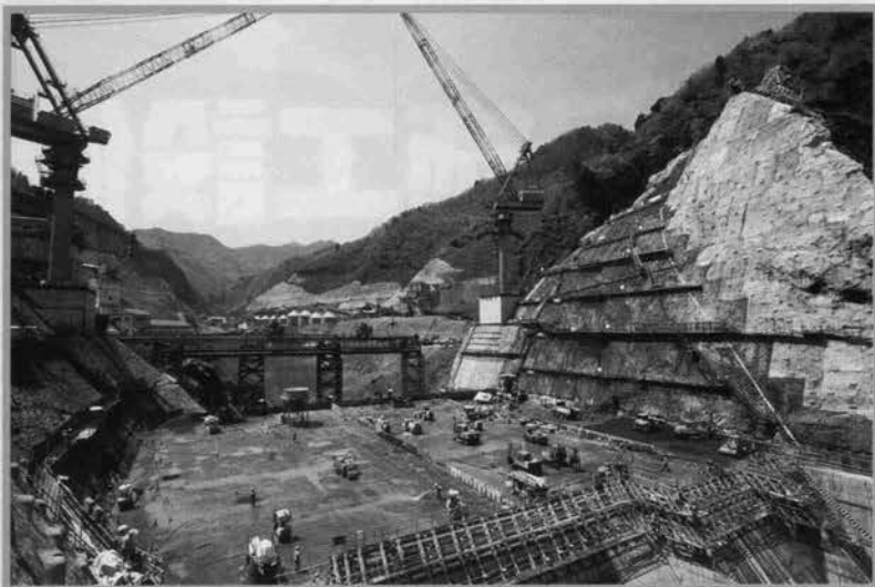
↑コンクリート打設状況
