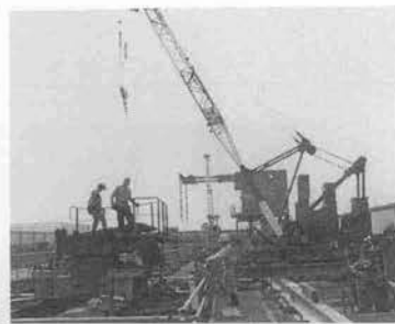
40 R を 5 R で解体
