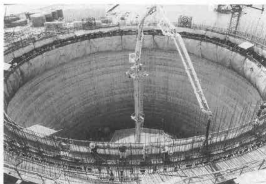
写真-2 コンクリート打設状況
