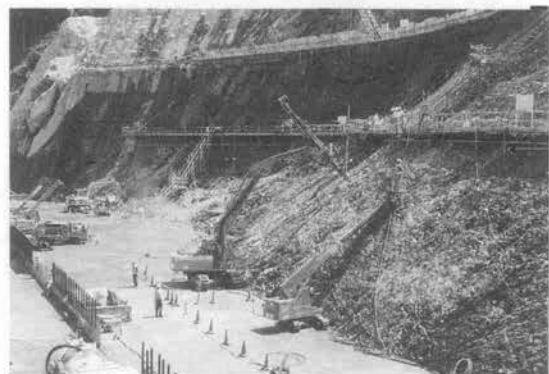
写真-4 高所ボーリングマシン施工状況
