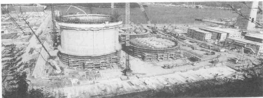
写真-1 サイロ工事全景
