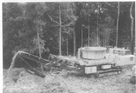
写真-2 林道作製の現場
