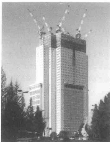
400 t・m×6基 基準階面積 3,600 m 2 最高高さ 195 m
