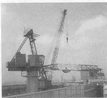
150 H を 40 R で解体
