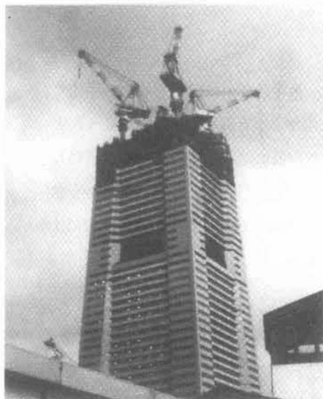
1,500 t・m×4基 基準階面積 3,500 m 2 最高高さ 29 m
