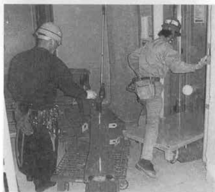
HUC 02 を人力で解体、エレベータで降ろす
