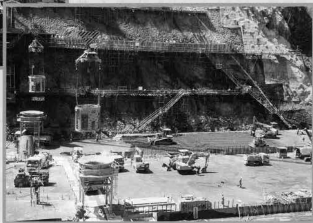
↑コンクリート打設状況
