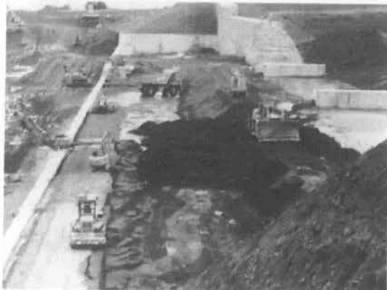
写真-3 現場施工状況
