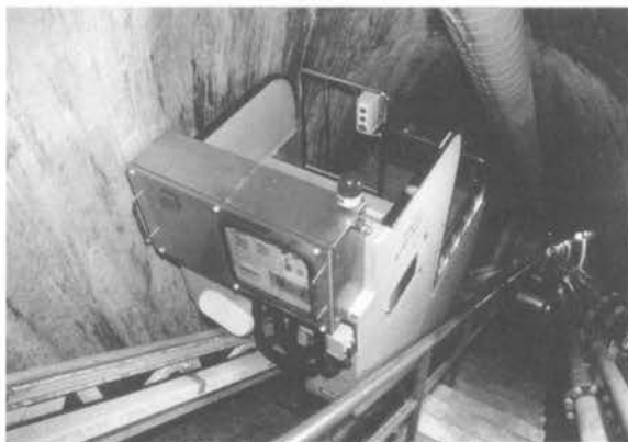
東京電力(株) 七倉ダム監査廊
