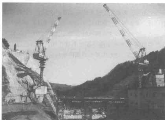
写真-3 クライミングクレーン
