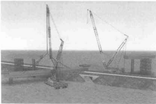
写真-2 大型クレーン1台で吊上げて移動、仮置き
