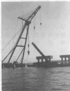
杭切断後の撤去
