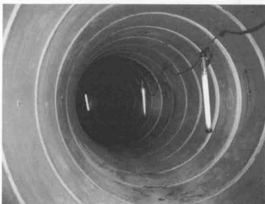
写真-1 φ1,650, R=12.5m 管内状況
