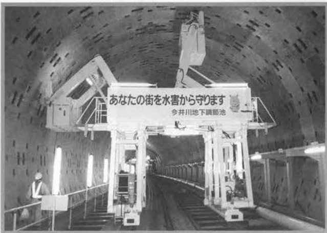
⇧ シールドトンネル坑内
