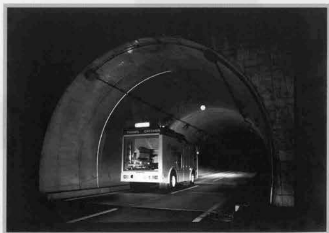
⇩道路トンネルの計測状況
