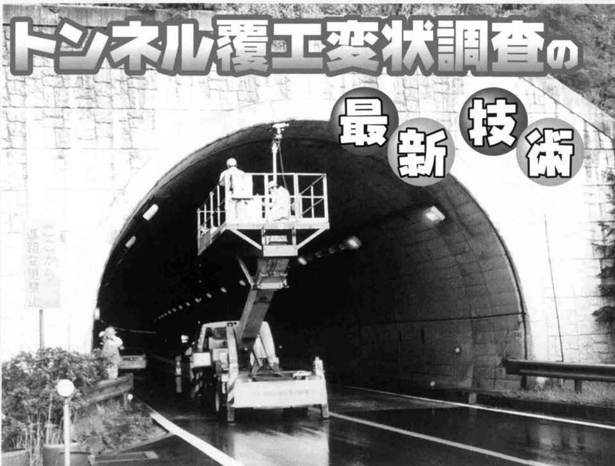
⇩道路トンネル計測状況
