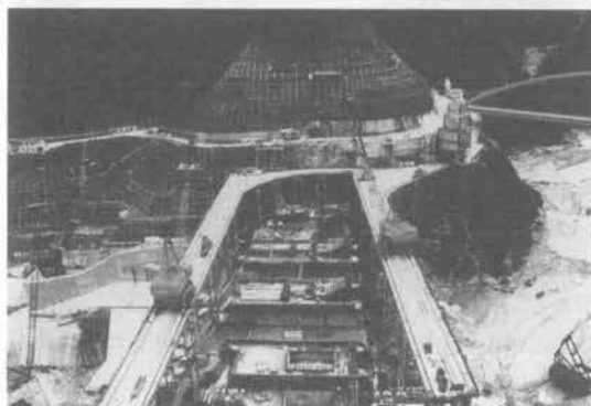
写真-2 ジブクレーン
