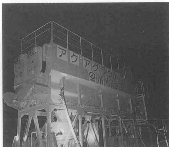
写真-4 坑外プラント全景
