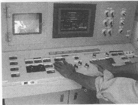
写真-8 操作状況
