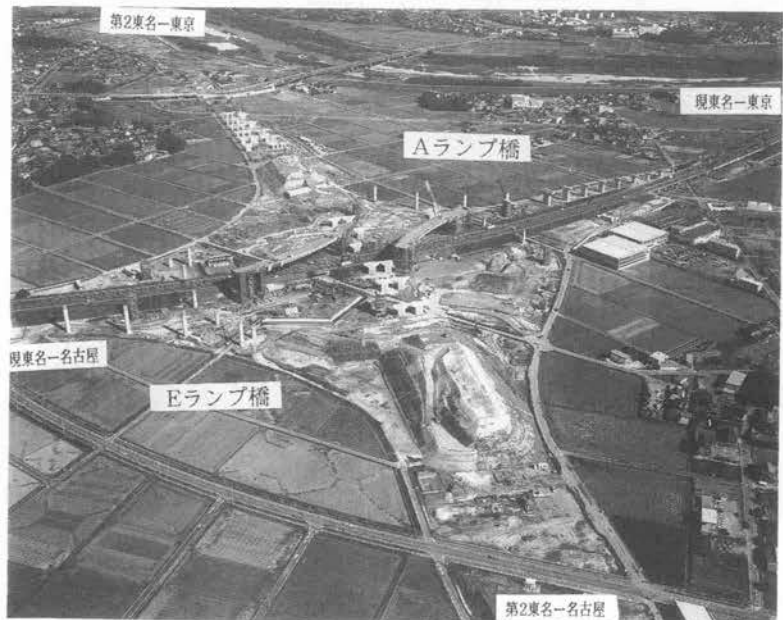
写真-7 大ブロック架設後
