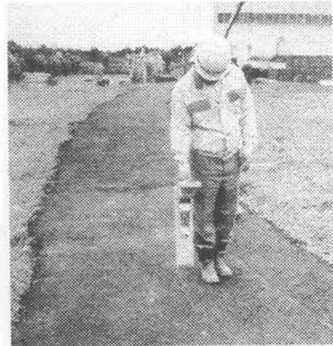
写真-4 磁力線による位置測定状況
