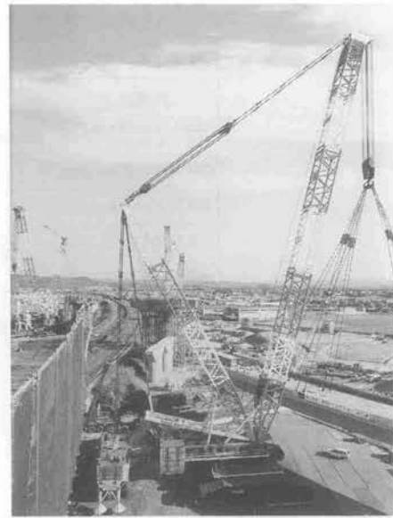
写真-1 1,200 t クローラクレーン
