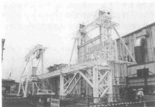
写真-3 立坑自動ストックシステム地上部
