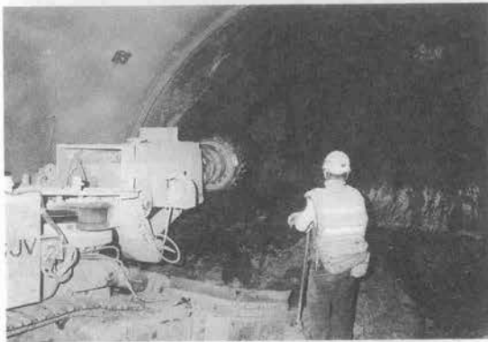
写真-4 上半掘削状況
