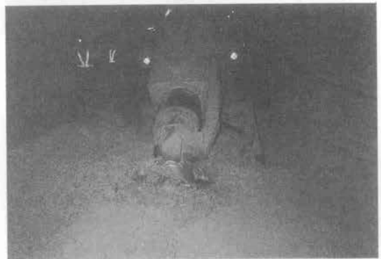
写真-6 インバート掘削状況
