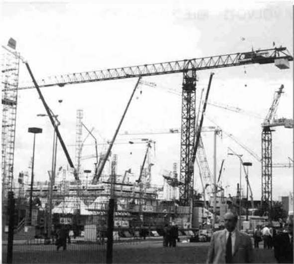
↑タワークレーン
