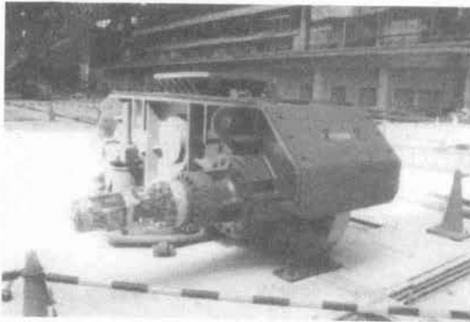
写真—2 MB 台車据付け
