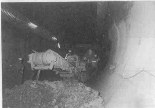
写真-5 下半掘削状況
