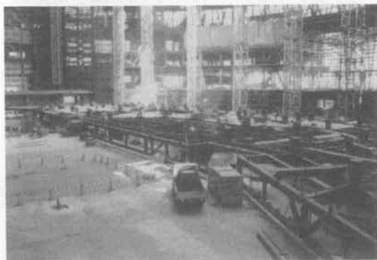
図-3 台車配置, 1節鉄骨建方
