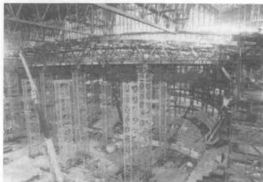
図-7 鉄骨建方完了
