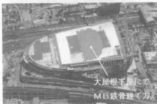
写真—1 ムービングブロックの施工
