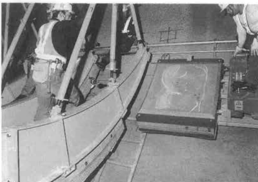
写真-8 下部覆工版設置状況
