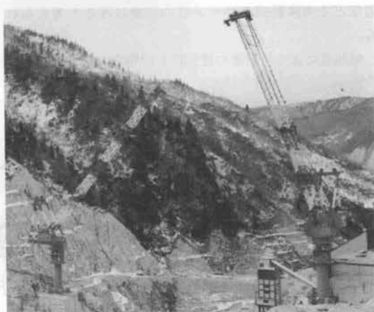
写真-9 クライミングクレーン
