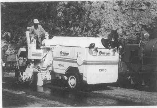
写真—9 常温式路上表層再生機 (Wirtgen 1000 CR)
