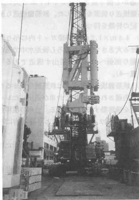
写真—2 SATT掘削機
