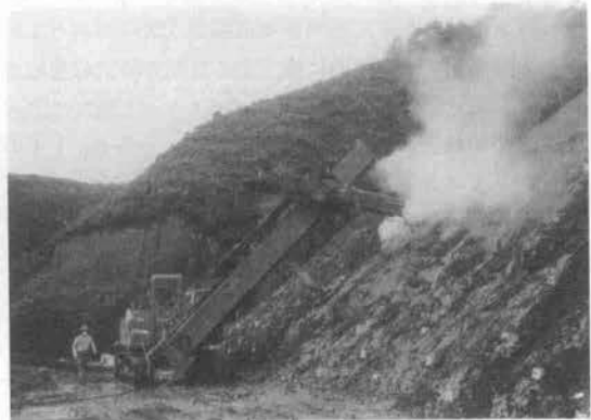
写真—2 掛川東工事
