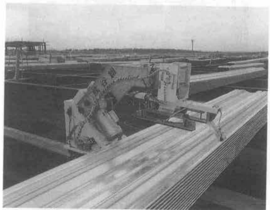
写真-1 デッキプレート自動敷込みシステム
