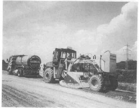
写真-8 路上再生路盤の施工例 (オーストラリア, Bomag MPH 120 R)
