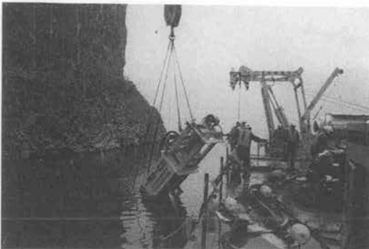
写真-25 水中油圧ブレイカ施工状況
