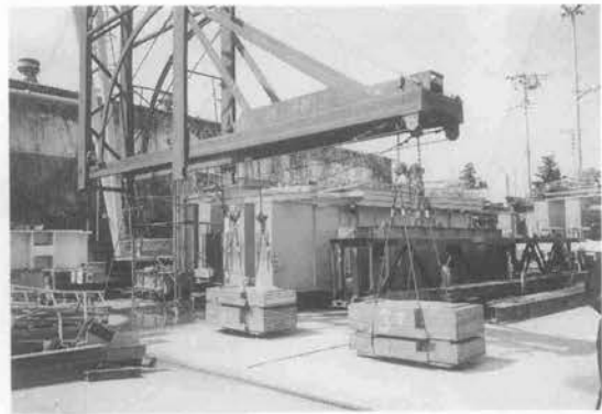
写真-5 台車の横移動状況 (10tのカウンタウェイト使用)
