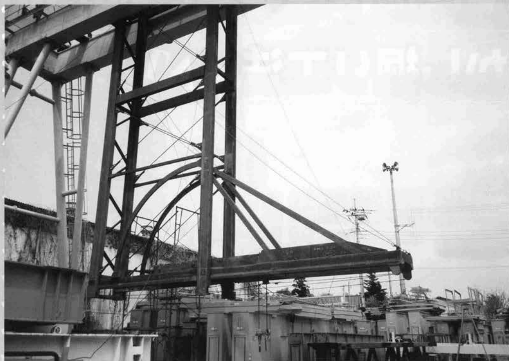
↑ 鉄筋籠横送り装置（張り出しレール倒し込み）
