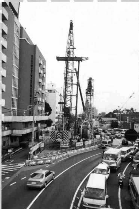
↑ 鉄筋籠横送り装置 挿入状況
