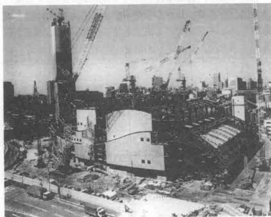
写真-3 臨海部の清掃工場
