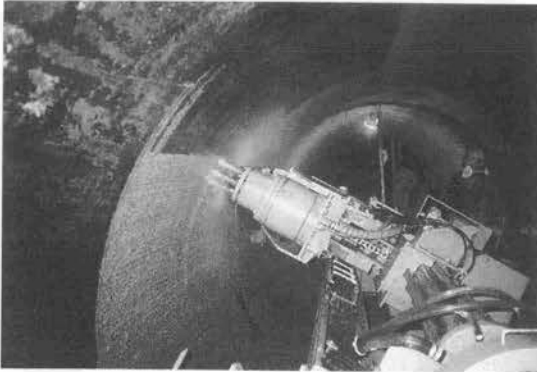
写真-30 はつり施工状況
