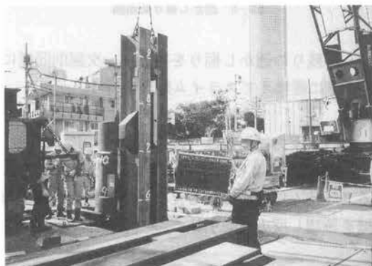
写真—3 反力材建込み状況
