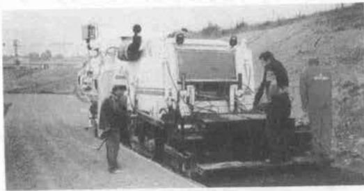
写真—10 常温式路上表層再生機 15) (Wirtgen 2100 DCR)
