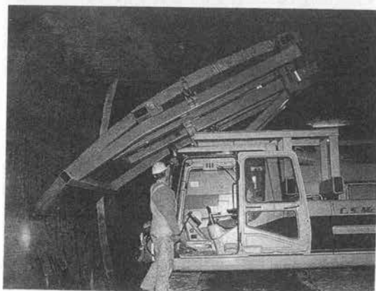
図-2 傾斜カーブの壁面パネルを決められた位置に設置するパネル据付け機械
