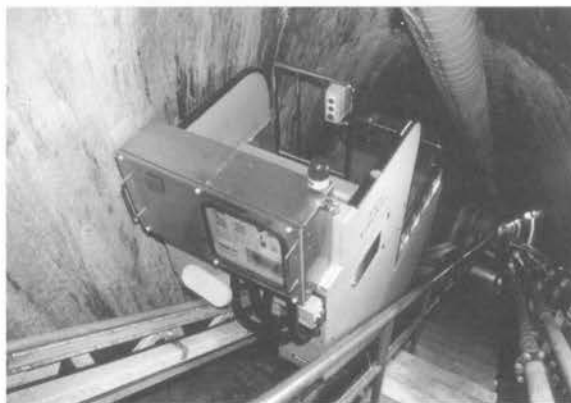
東京電力(株) 七倉ダム監査廊
