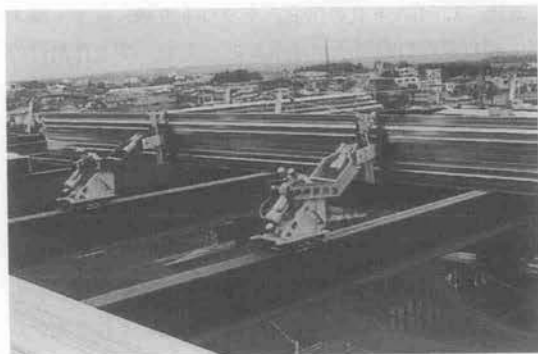
写真-2 施工状況
