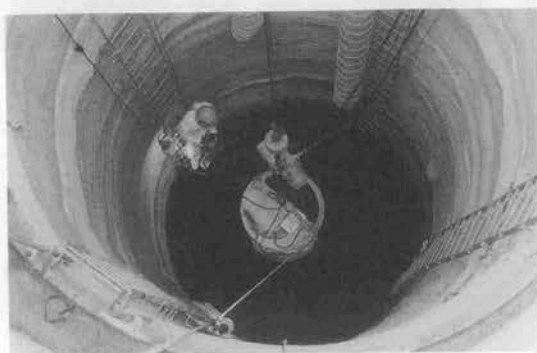
写真-2 坑内吹付け状況
