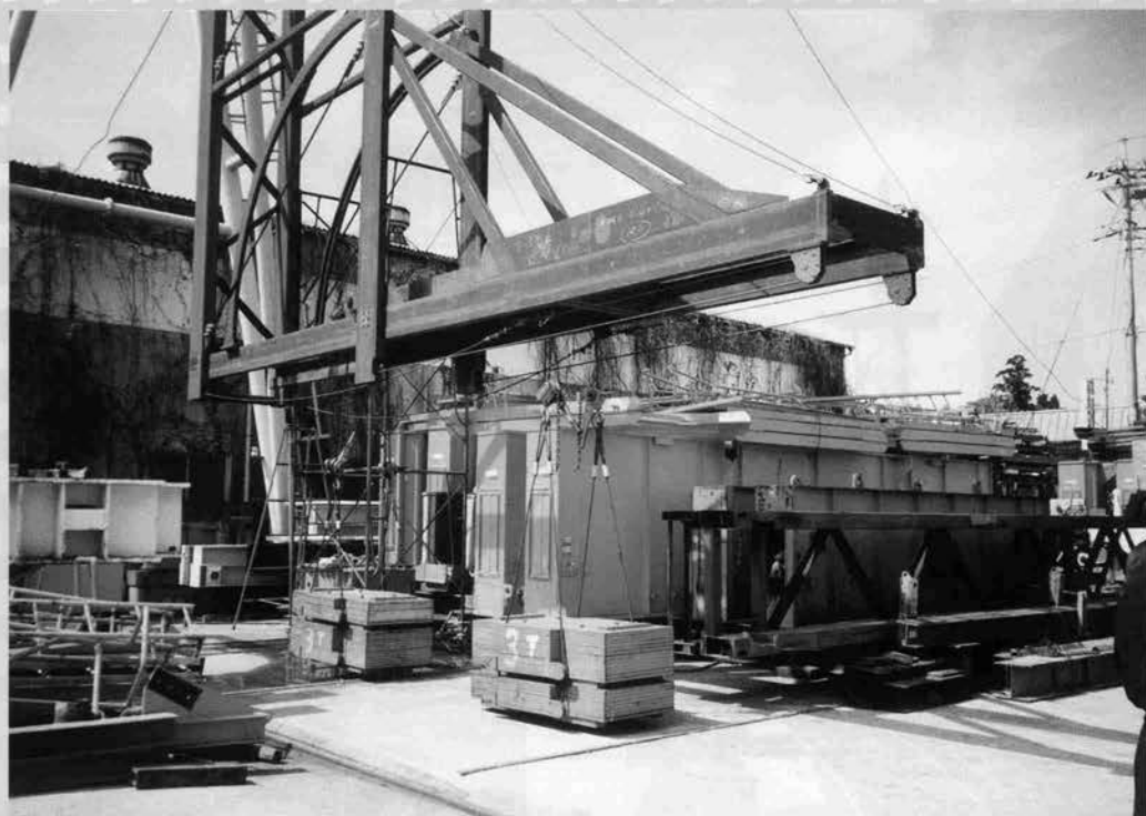
↑ 鉄筋籠横送り装置（鉄筋籠台車移動）
