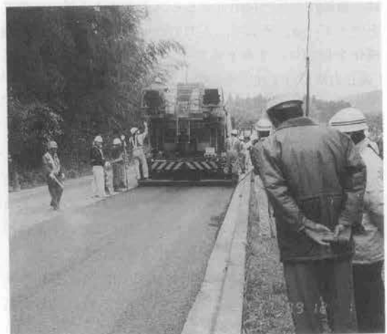
写真-3 マルチレーンペーブメント工法実施状況
