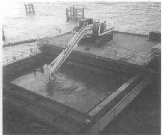
写真—23 水中構造物解体状況
