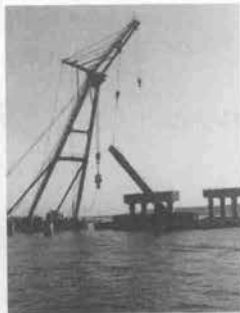
杭切断後の撤去
