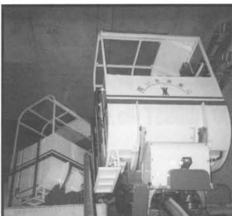
水資源開発公団 浦山ダム堤内巡視設備
