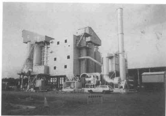
写真-8 アスファルトプラント (NP 1000 D)
