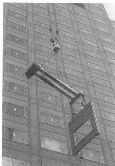
写真-21 外壁板取付けシステム
