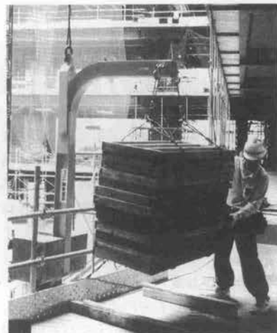
写真—7 荷取り吊り治具
