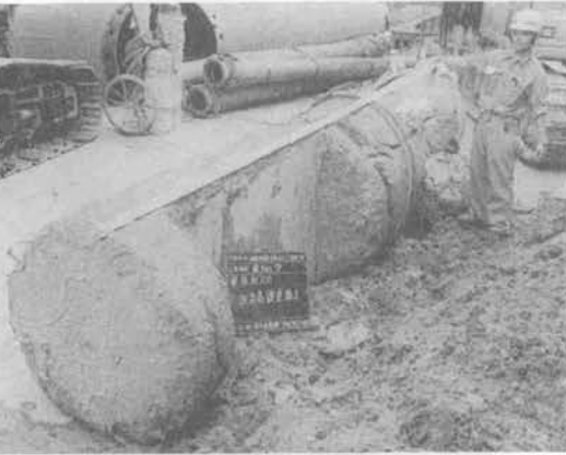
写真-1 耐圧盤、地中梁撤去状況
