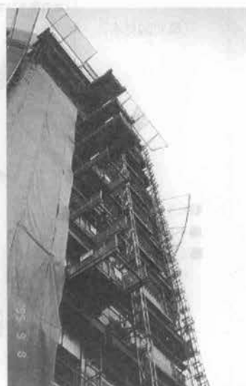
写真-11 荷取り構台
