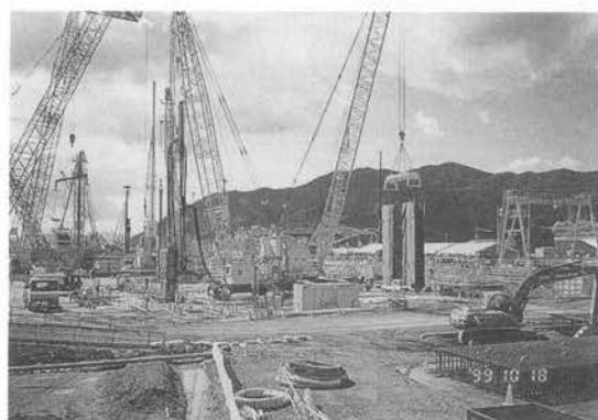
写真-3 掘削機遠景
