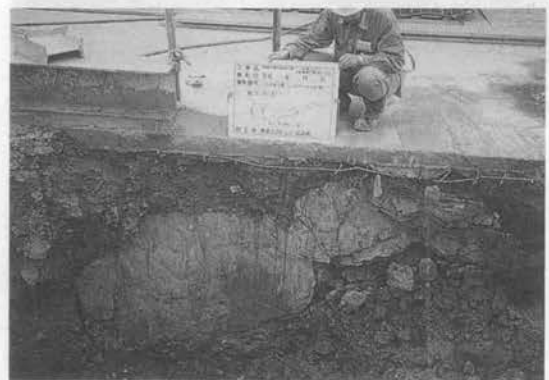
写真-1 掘削された巨転石
