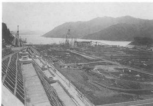
写真-2 サイロ部全景 (No.1~3)
