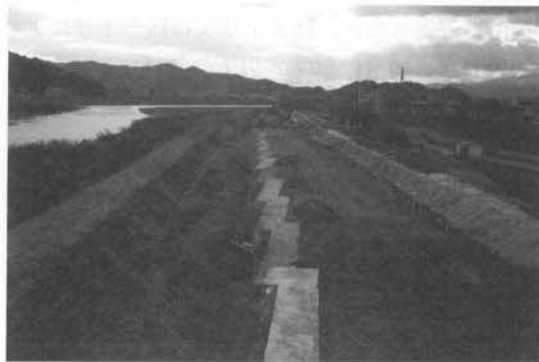
写真-2 上流側折返し部仕上がり状況
