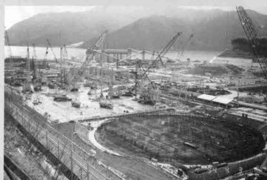
↑ サイロ部基礎全景
