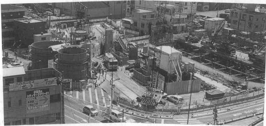
写真-2 工事全景
