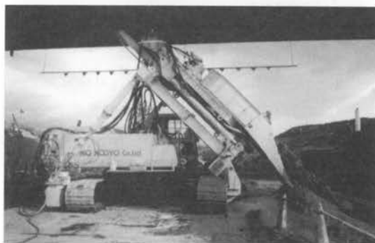
写真-3 三本木橋桁下低空頭施工状況
