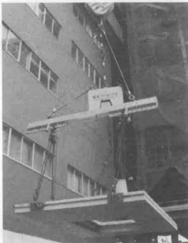
写真—5 PCa・CW 反転装置
