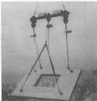
写真—4 PCa・CW 反転装置
