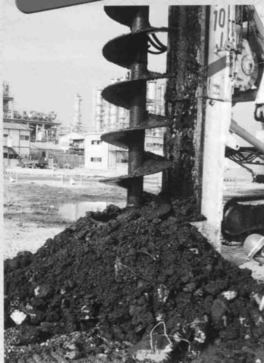
⇐マルチドリル工法掘削機 ソイルメック モデル R-10J アースオーガー工法 連続スクリュウオーガー装着
