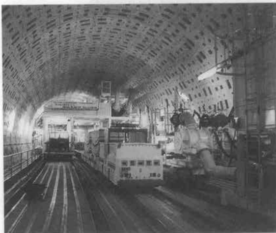
写真-1 第一工区(セグメント自動搬送はSS無線が採用されている)
