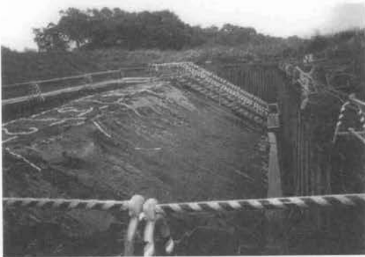
写真-1 実証実験における開削状況
