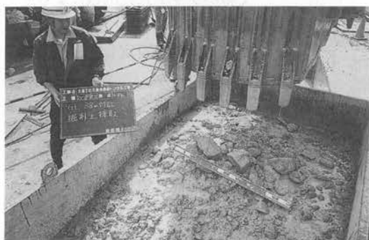
写真-1 掘削土状況 (バケット式掘削機による)
