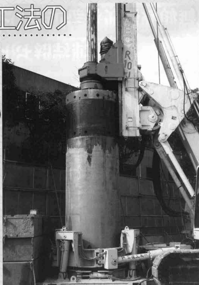
↑マルチドリル工法掘削機 ソイルメック モデル R-10J オールケーシング工法 ケーシング装着、R-10J本体油圧駆動専用揺動装置併用
