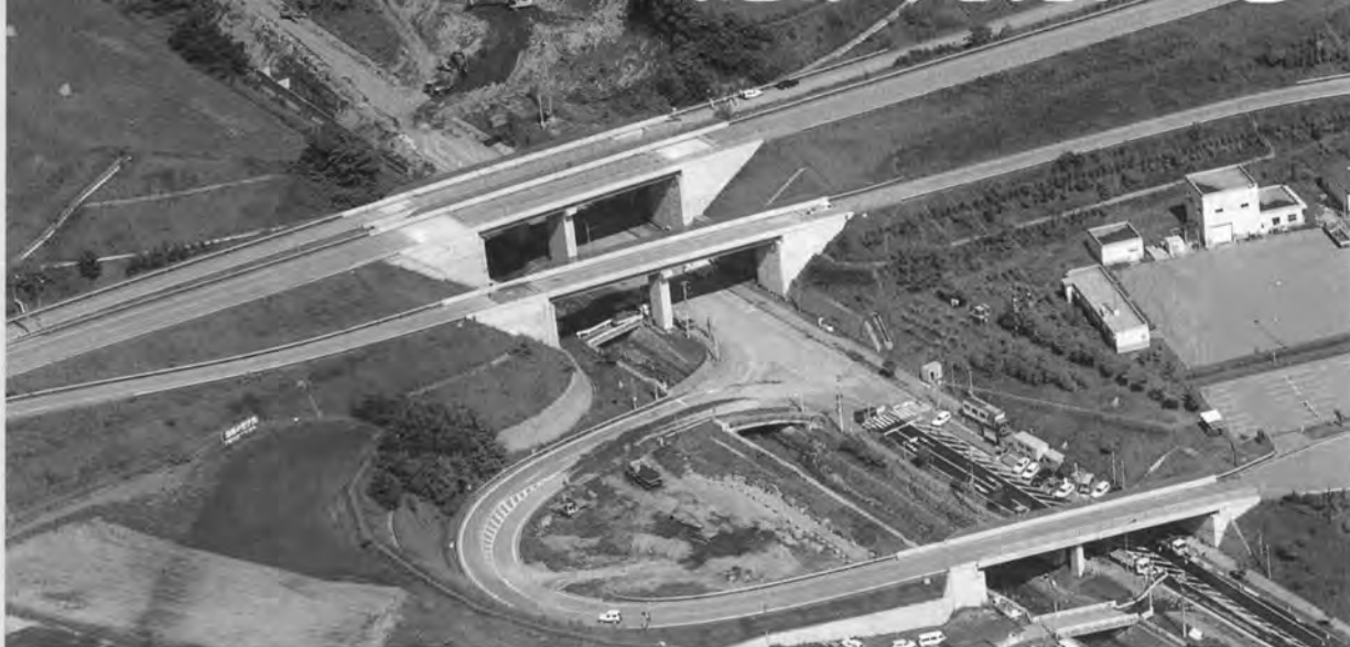
↑道央自動車道の北側で遊砂地設置のための掘削(上空より)
