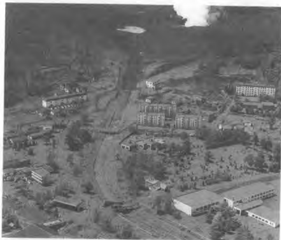
写真—4 西山川（着工前：6月10日撮影）
