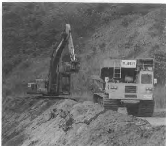
写真—3 板谷川（施工中）
