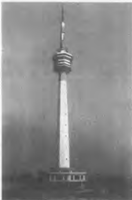
写真-2 西安テレビ塔の施工例
