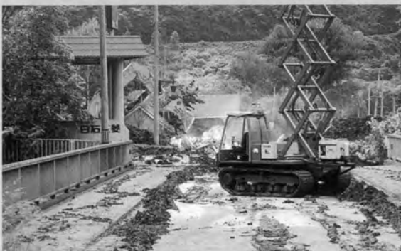
↑橋桁の取壊し状況 手前は移動カメラ車
