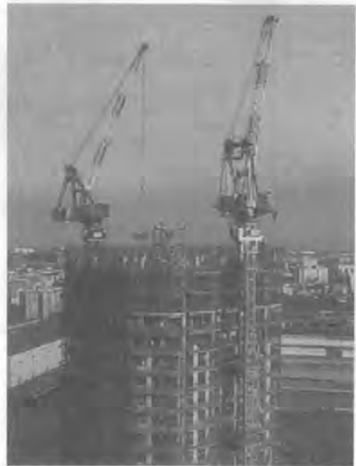
写真一 施工状況 (左 230 t-m, 右 200 t-m)
