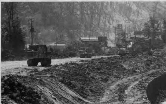
↑西山川右岸 土砂運搬状況
