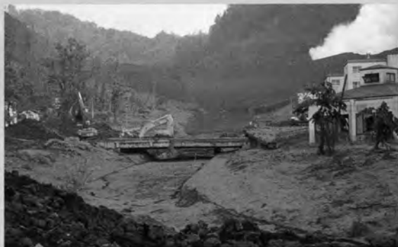
↑こんびら橋 橋桁(上流から熱泥流により流出)の取壊し状況西山川を下流から臨む
