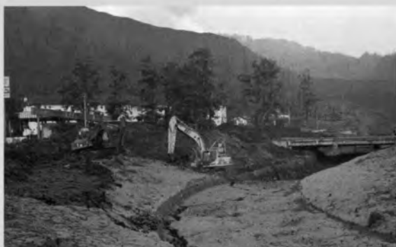
↑流路内の掘削状況(堆積した泥流を除去)
