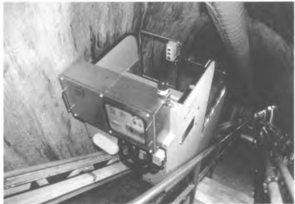
東京電力(株) 七倉ダム監査廊
