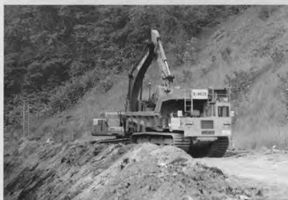
↑掘削積込みの状況
