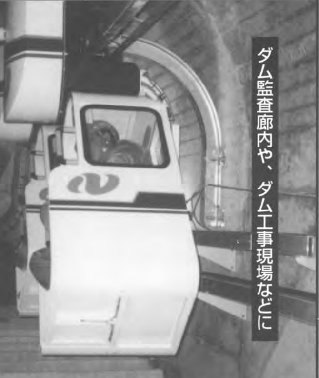
長崎県 萱瀬ダム監査廊
