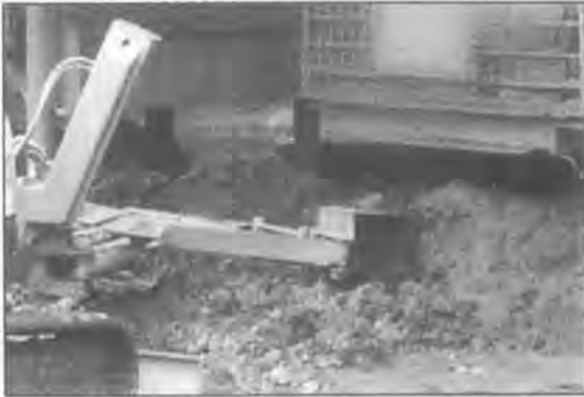
写真—5 水平掘削作業
