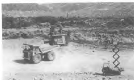
写真—1 施工状況
