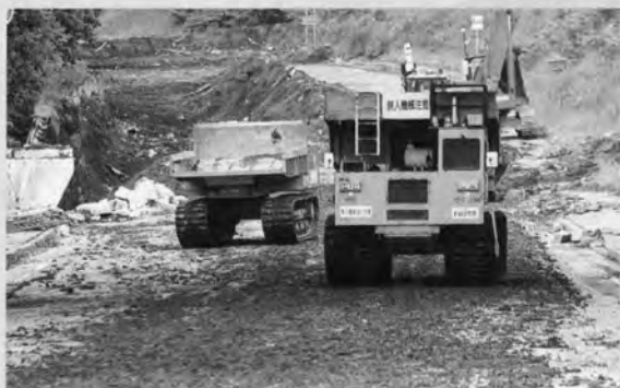
↑土砂運搬状況
