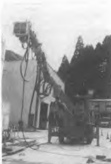
写真-1 吹付けロボット
