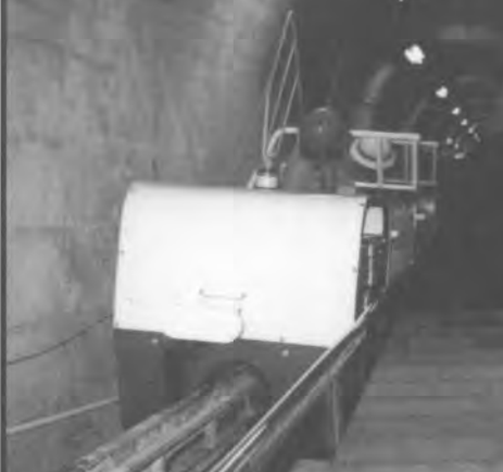
九州農政局 天神ダム監査廊
