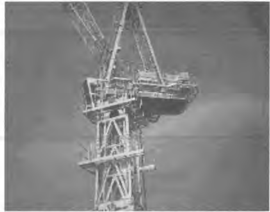
写真-4 特殊型 150 t-m クライミングクレーン
