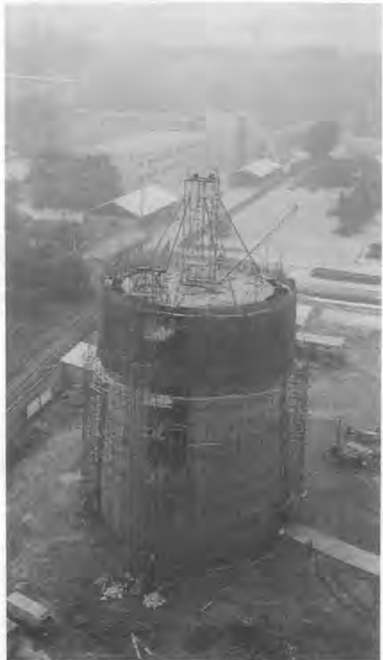
写真一 超高鉄筋コンクリート煙突の施工例
