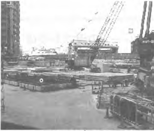
写真-2 PCサイト全景
