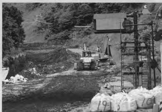
↑掘削状況(下流より)
