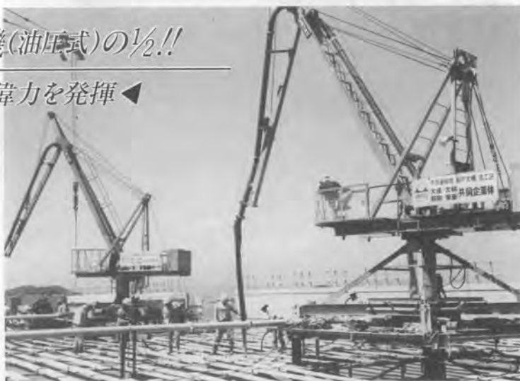
(本四架橋現場設置例)
