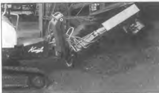
写真—6 斜め掘削作業
