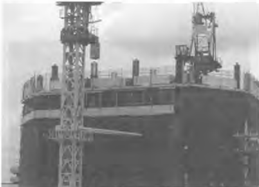
写真-3 水平支持材取付け状況
