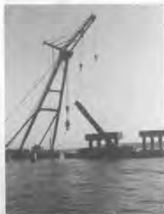
杭切断後の撤去
