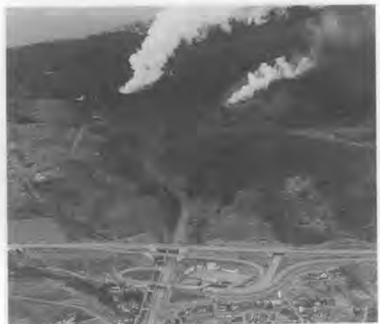
写真-1 板谷川(着工前:4月15日撮影)
