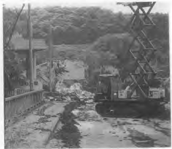
写真—6 西山川（施工中：6月29日撮影）
