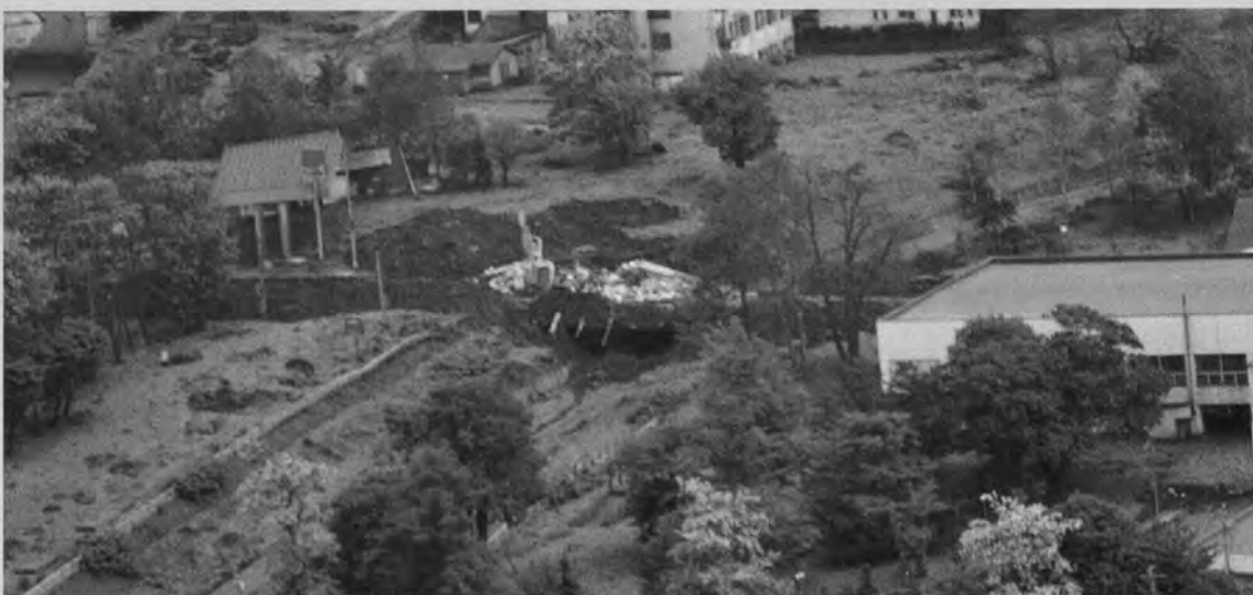
↑橋桁の取壊し状況(上空より)
