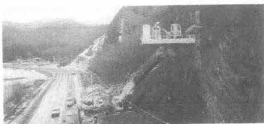
写真-4 メインデッキによる岩盤削工
