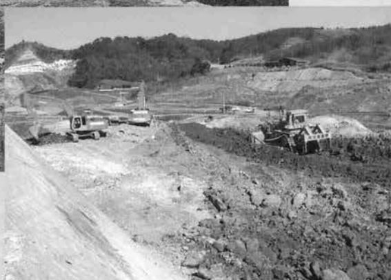
↑開削部施工状況
