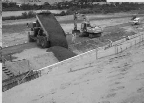
↑拡幅部下流左岸施工状況
