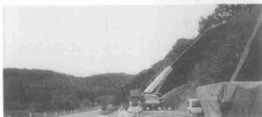
写真-5 サブデッキによる岩盤削工
