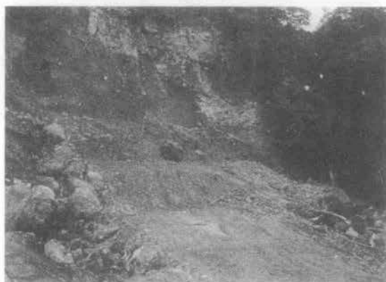
写真—8 作業完了状況
