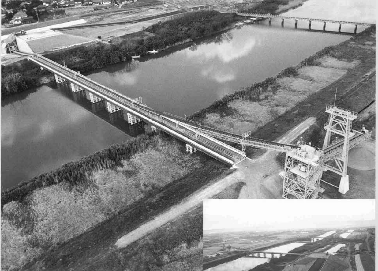
⇧土砂運搬設備 右岸側上流上空より全景
