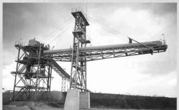
⇧ストックヤードコンベヤ
