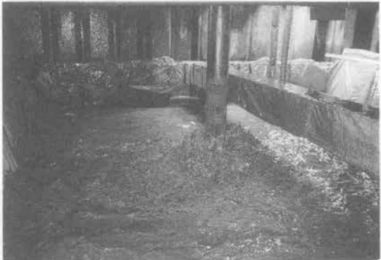
写真-5 施工状況 (1)
