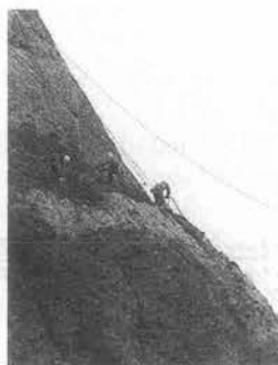
写真—1 人力による岩盤削工
