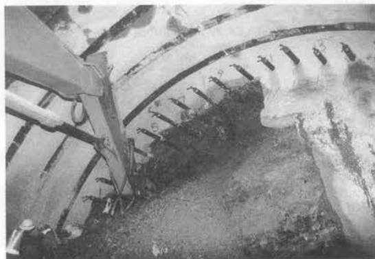
写真一 AGF-S 工法（無拡幅型）施工状況
