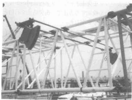
写真-2 ブームに固定された架台
