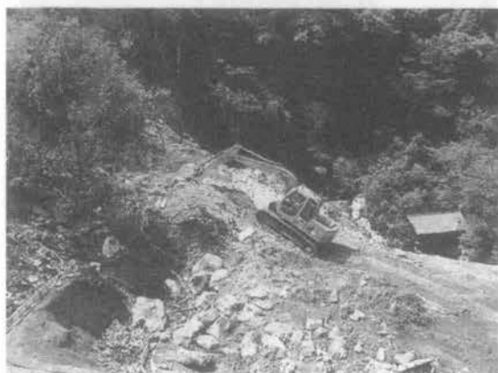
写真—6 作業状況
