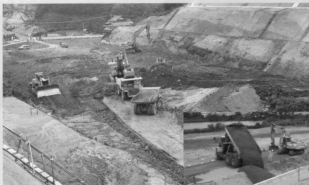
↑開削部施工状況
