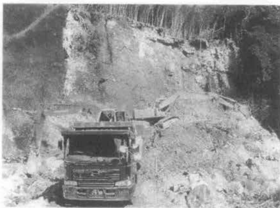
写真—7 トラックによる土砂搬出
