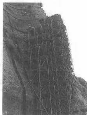
写真—2 単管足場
