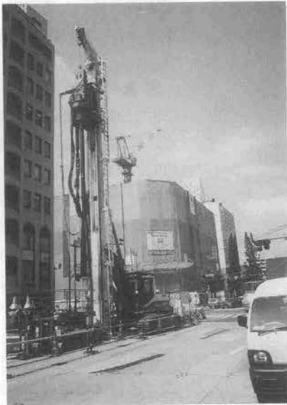
写真-1 SWING 施工機
