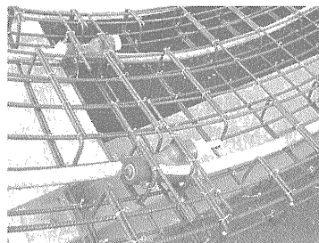
写真-2 定着体、鉄筋配置
