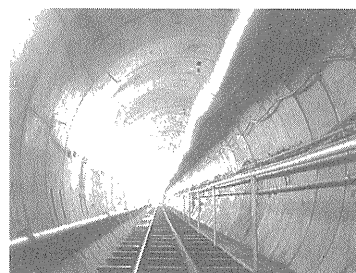
写真-3 坑内全景
