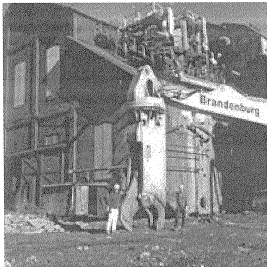
写真—1 Brandenburg社の解体機
