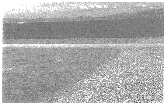
・50～150mmの碎石を養浜工事材として使用
