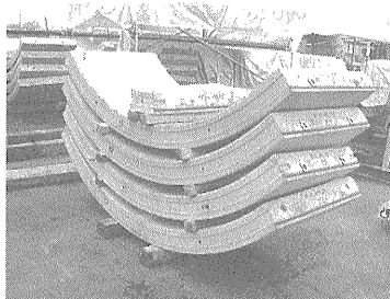
写真-1 セグメント仮置き
