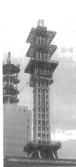
写真-2 プラットフォーム 施工状況
