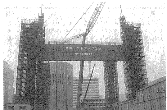
(第1回リフトアップ状況)
