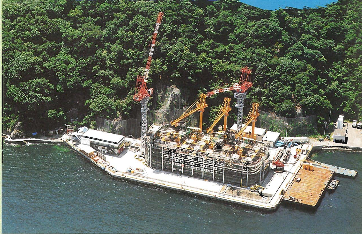
⇩ 女神大橋2P主塔基礎工事全景
