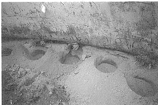
写真—3 刃口掘削状況
