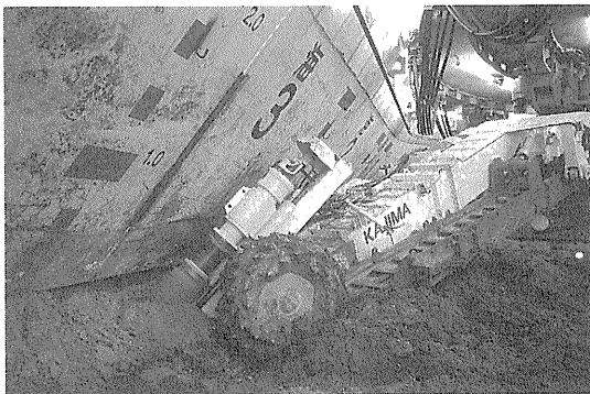
写真—2 刃口掘削装置掘削状況
