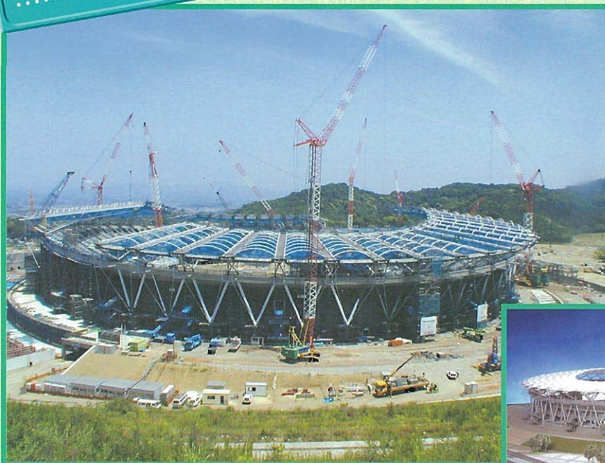
↑建設中スタジアムの全景
