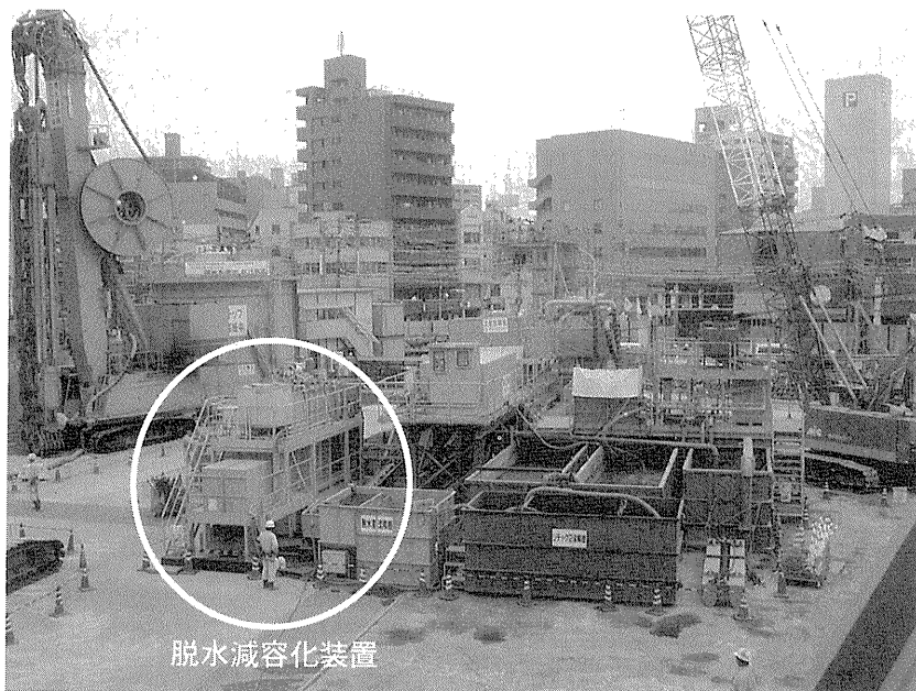
写真-1 RC 地中連続壁工事の安定液循環設備とリユースの脱水減容化装置設置状況
