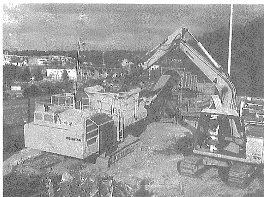
写真-4 解体系廃木材処理現場
