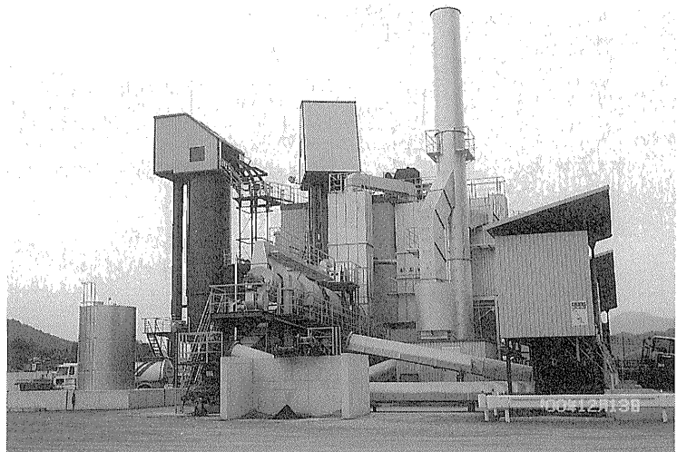
写真-3 再生アスファルトプラント(併設型リサイクルドライヤ方式)
