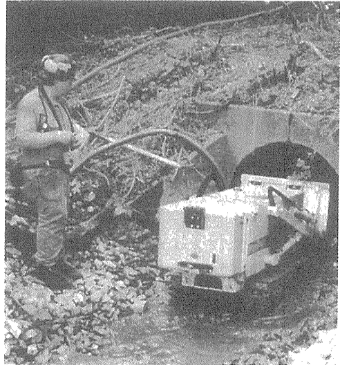
写真—1 作業員はリモコンを使って安全な場所からMT 346を蛇が棲息するボックスカルバートに導入する
