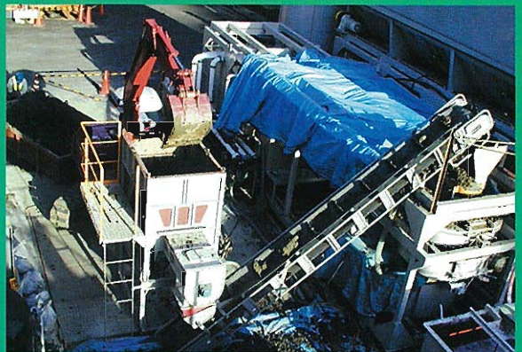
↑固形物を用いた安定液製造状況
