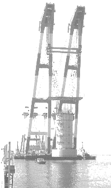
写真-1 据付け中の防衛工 (大阪府土地開発公社提供)
