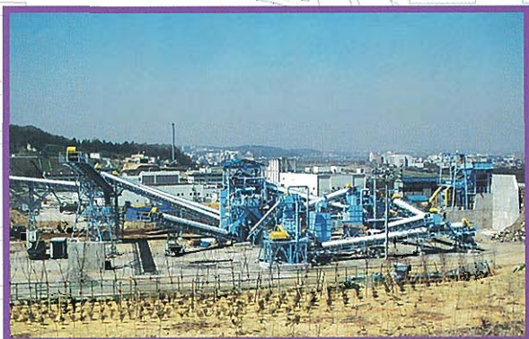
↑コンクリート塊定置式リサイクルプラント
