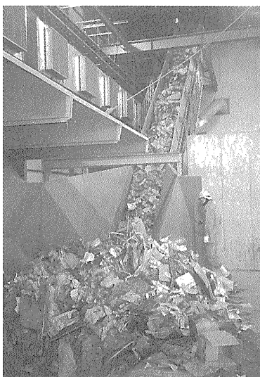
写真-3 混合廃棄物供給ホッパ部
