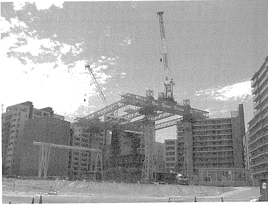
写真—1 組立て完了状態
