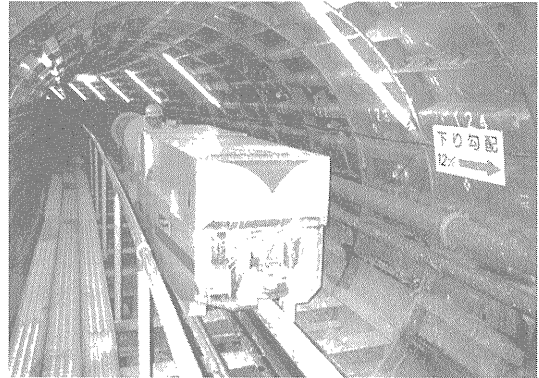
図-2 「じょくらいまー3500」による急勾配搬送状況（勾配12%）
