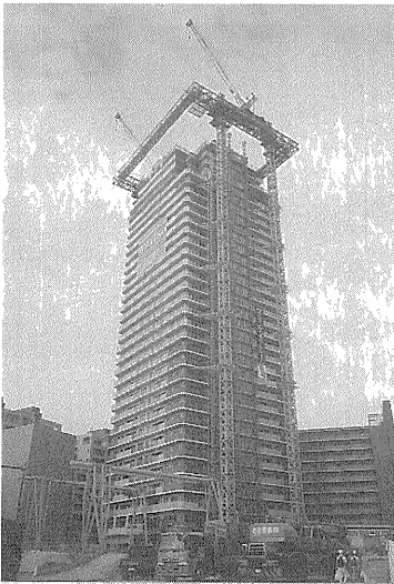
写真-4 天井クレーン解体/ホイストビーム移動完了状態
