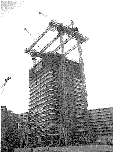
写真—2 クライミング状況(23階コアウォール・21階床施工中)
