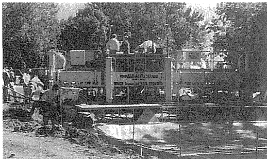
写真一 Leica 社の自動 3 次元制御システムを用いることで Gomaco 社の機械はセンサロープなしで出来形通りに舗装できる。
