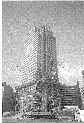
写真-6 迫下げ・マスト及び水平ステー解体(2)
