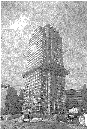
写真-5 迫下げ・マスト及び水平ステー解体(1)
