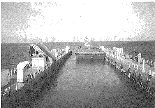
写真—6 土運船出渠
