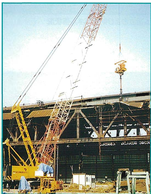
↑工場の解体 波鉄板、モヤ材の撤去
