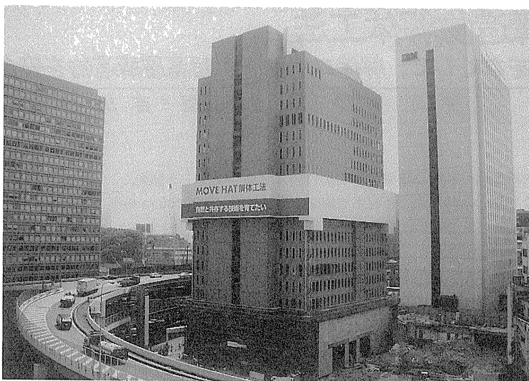
写真一1 工事状況 (MOVE HAT の上昇)
