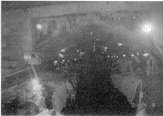
写真-20 地下鉄工事現場
