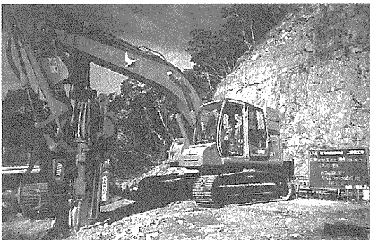
写真-4 ドリル付き油圧くさび破碎機
