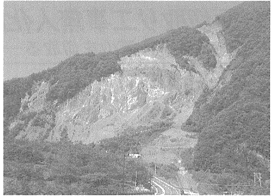
写真—3 大西山の全景
