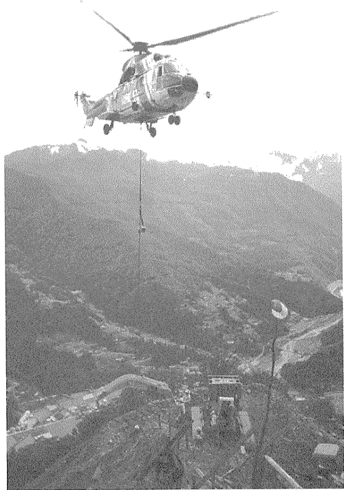
写真—6 空輸作業
