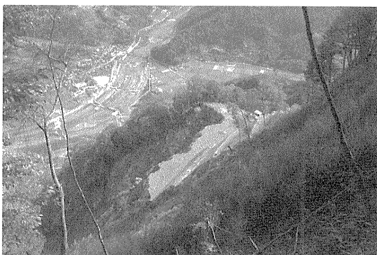
写真—13 切取り・4段目完了
