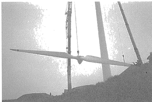
写真—10 ブレード吊上げ
