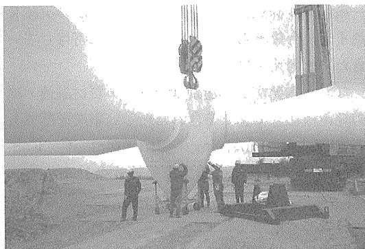
写真—9 ブレード吊上げ準備
