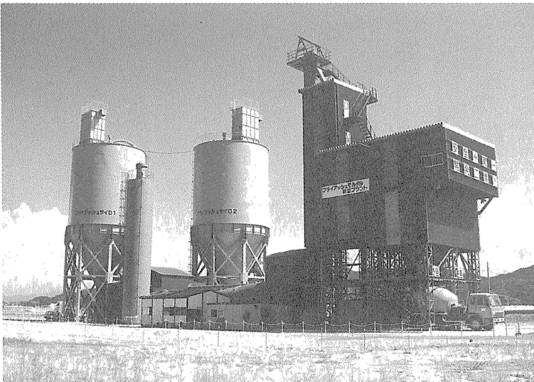
写真—1 プラント全景
