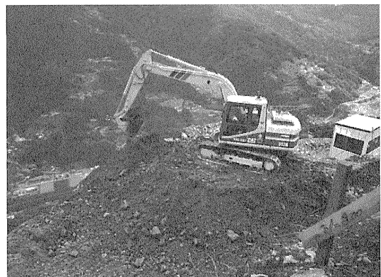
写真—8 無人化機械作業状況
