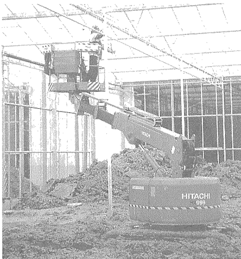
写真—8 高所作業車 Hitachi-HX 99 B (展示機と同一モデル)
