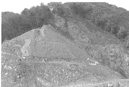
写真—10 法面保護工
