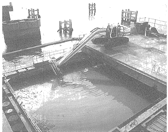
写真—3 解体状況
