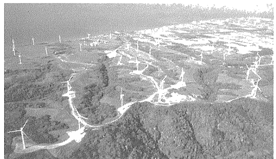
写真—1 苫前ウィンビラ発電所全景
