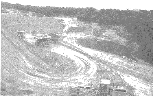
写真—2 現場施工状況
