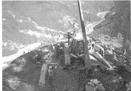
写真—7 組立て作業
