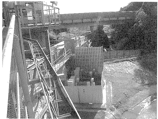
写真-6 駆動部防音壁設備
