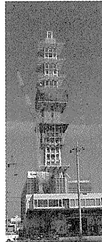
10/5 J 面部材搬入取付
