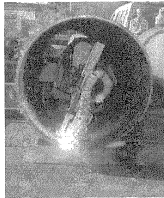
写真-2 プラズマ切断機による溝加工状況
