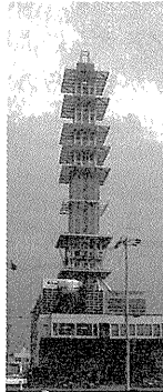
10/13 G 面部材搬入取付
