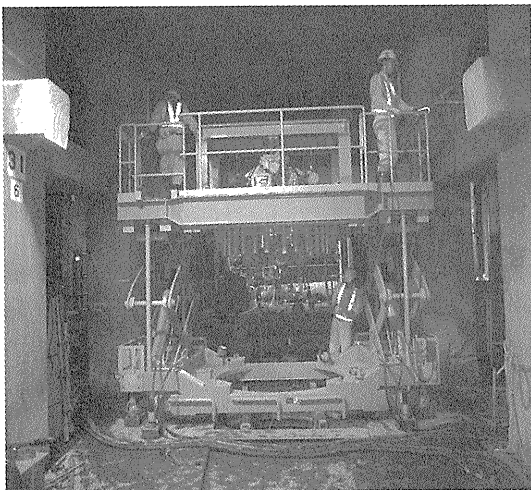
写真—1 ストランド建込み装置
