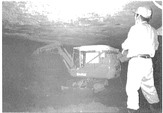
写真-1 ミニショベル操作状況
