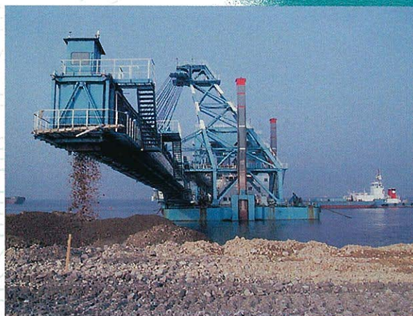
⇩リクレーマ船による直接揚土状況
