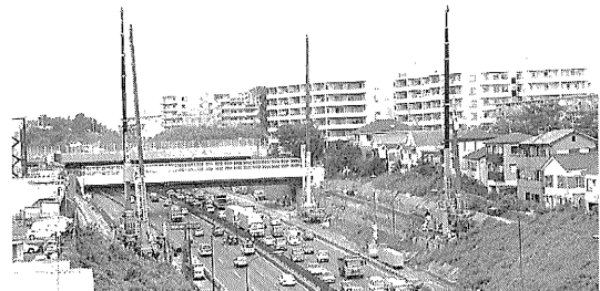
写真-1 現場全景
