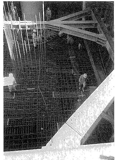
写真-3 配筋状況
