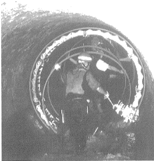
写真—6 製管状況（自走式）
