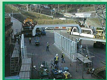
⇩ プロテクターの組立状況
