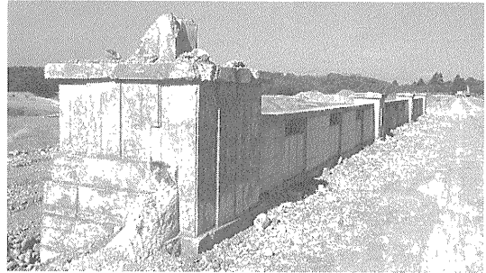
写真-1 発見されたコンクリート製旧高欄
