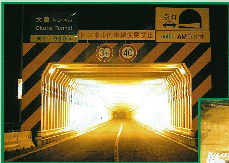
⇩ プロテクター設置完了
