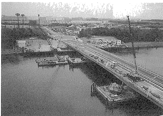
写真-1 ケーソン施工状況（全景）
