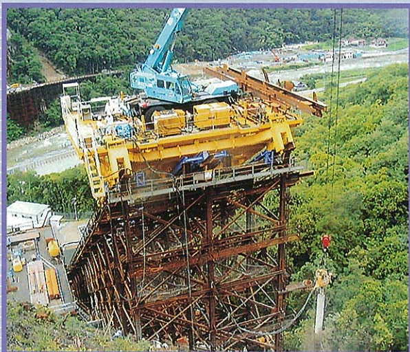
⇩架台敷設作業中(前方より撮影)
