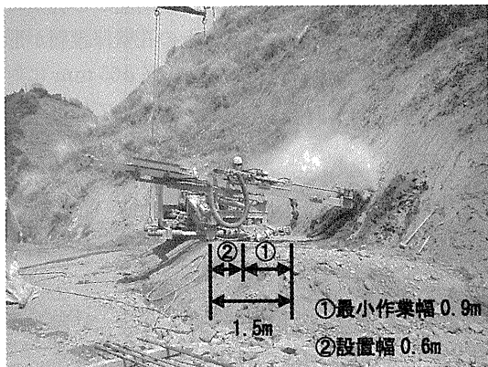
写真—5 最小足場幅の現場実験
